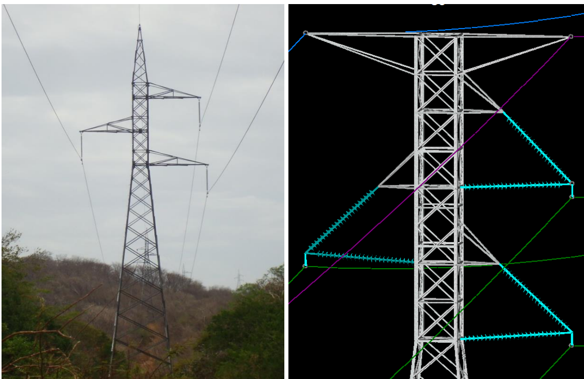
Imagen 2. Imagen de la configuración actual de la línea en torres de suspensión y esquema del ajuste requerido para repotenciar la línea a 230 kV.
