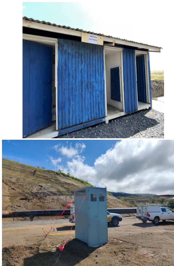
Figura 42. Manejo de las aguas residuales de tipo ordinario mediante tanque séptico y caseta sanitaria en seco.
