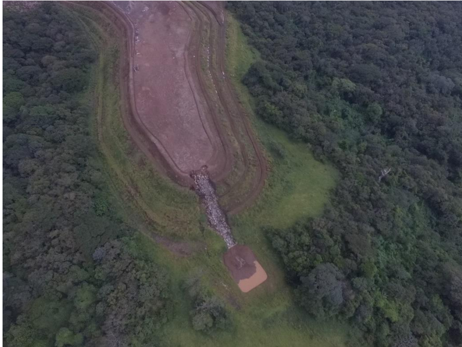
Sedimentador principal del sitio de obra Escombrera 1. Noviembre 2024.
