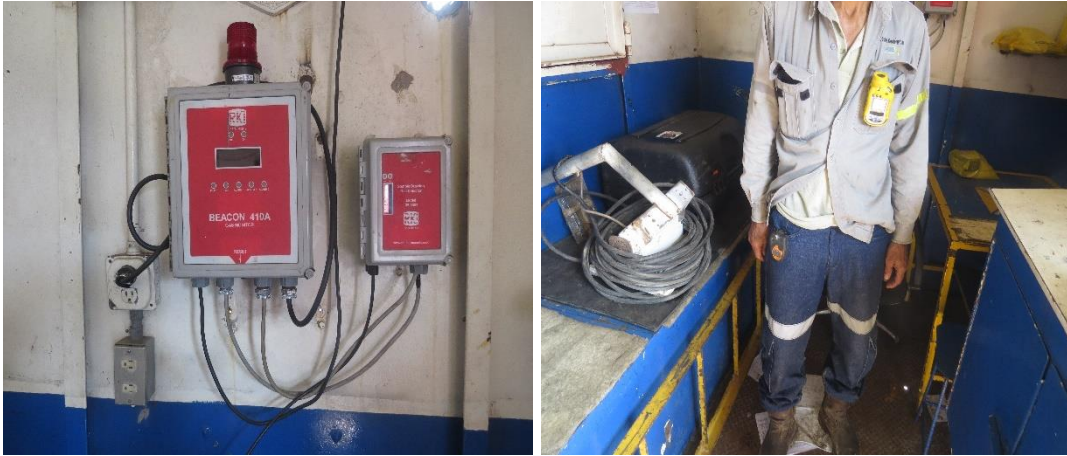
Figura 17. Detectores de gases utilizados en pruebas de producción y labores de perforación de pozos profundos.
