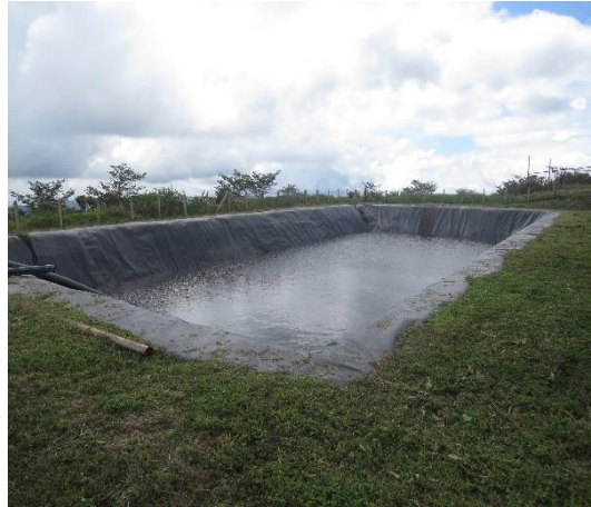
Figura 151. Laguna de almacenamiento para agua de trabajo.
