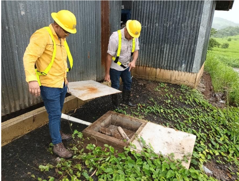
Figura 11. Revisión de trampa de hidrocarburos del taller mecánico.
