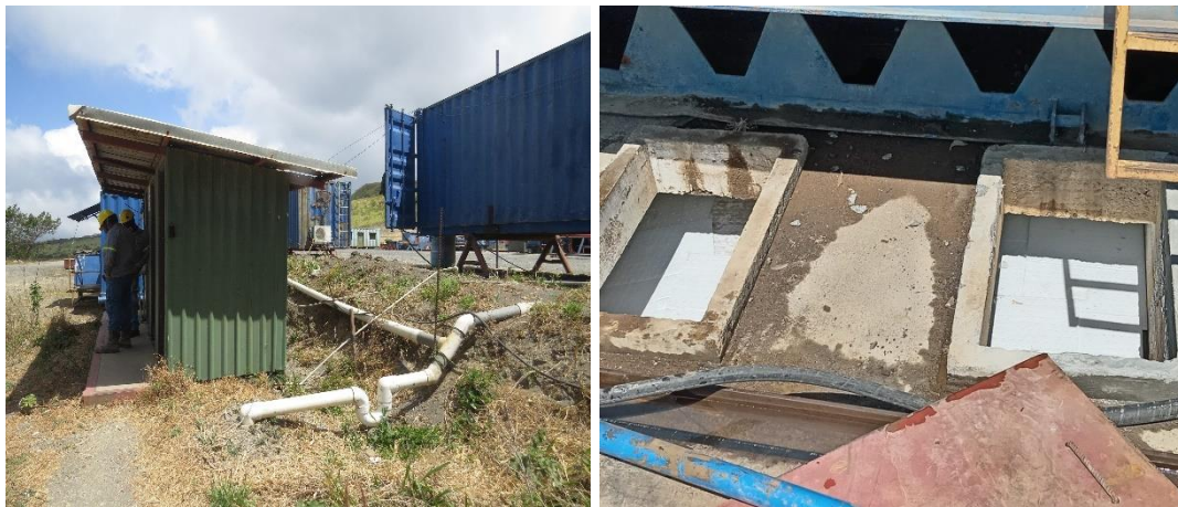
Figura 41. Manejo de aguas residuales de servicios sanitarios y trampa de grasa del sistema de contención de derrames del tanque de almacenamiento de hidrocarburos en la plazoleta PLB-08.
