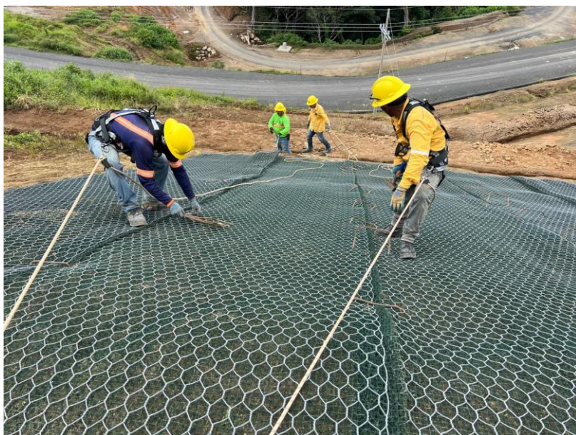
Figura 65. Colocación de geomanto en taludes.
