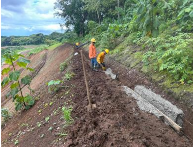
Figura 157. Construcción de cunetas de concreto para control de erosión.
