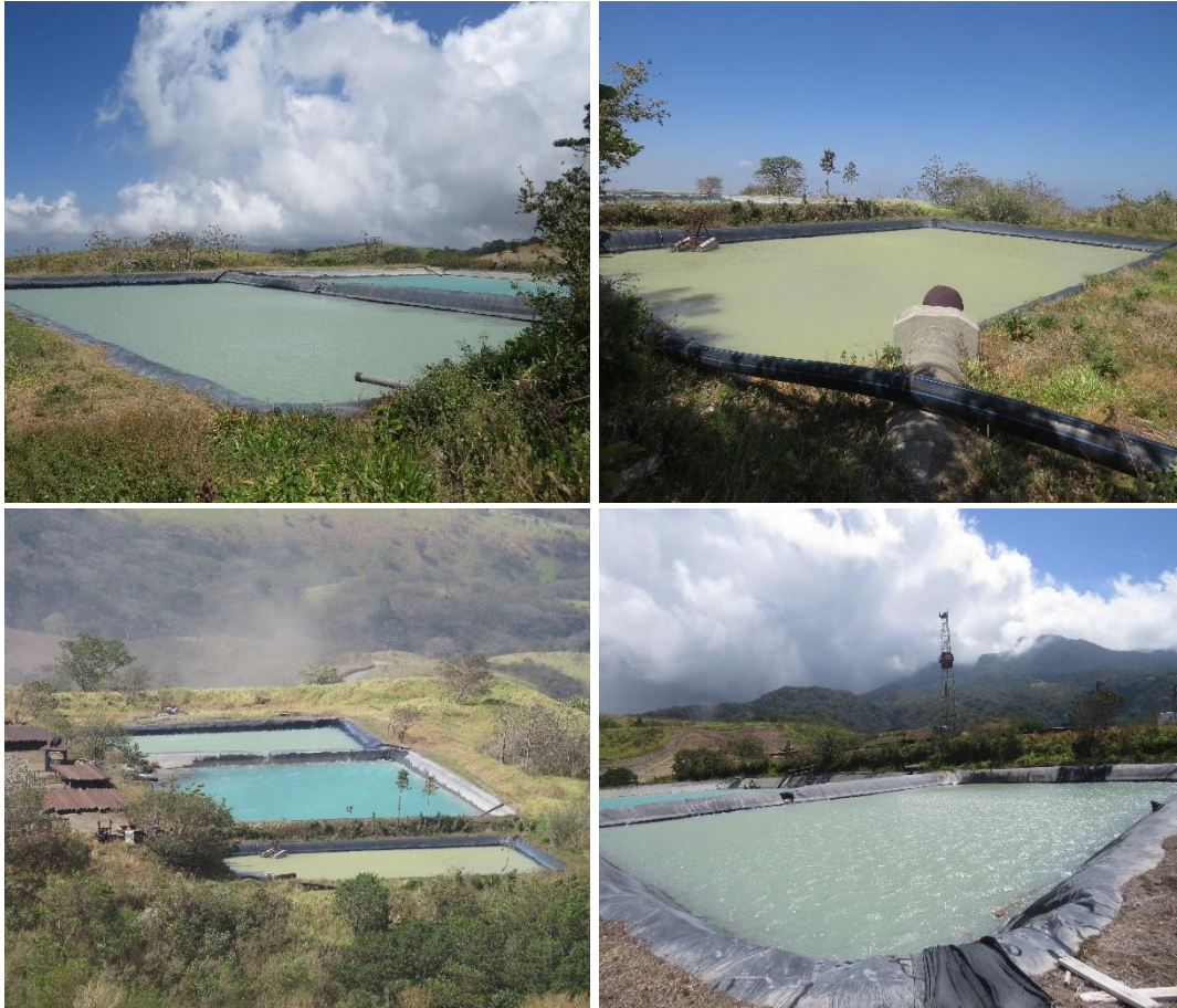
Figura 39. Lagunas impermeabilizadas en PLB-05.
