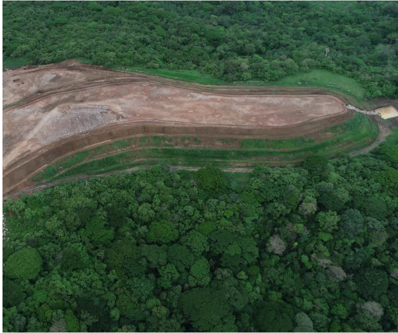
Figura 34. Proceso de Revegetación y Sedimentador de la Escombrera 1.
