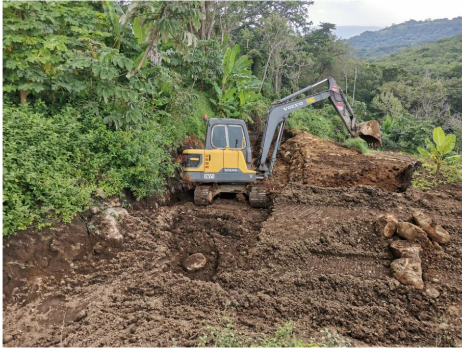
Figura 33. Trabajos para reducir procesos de erosión.
