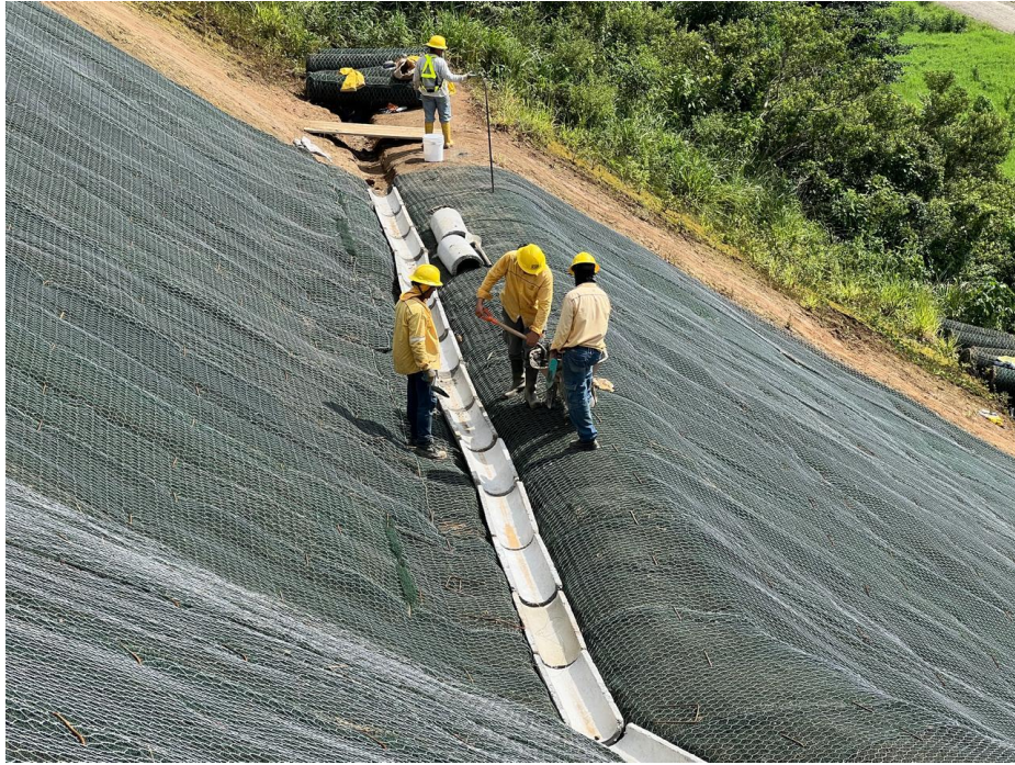
Figura 32. Manejo de aguas en taludes.
