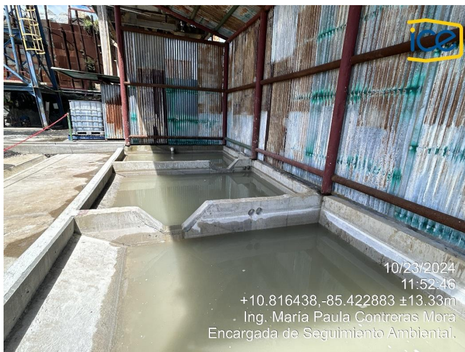
Figura 66. Sedimentadores para la planta de concreto y lavado de equipos.
