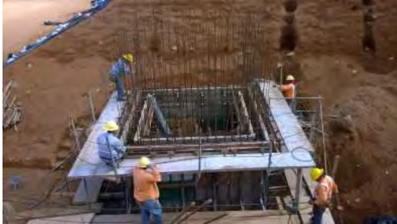
Figura 160. Construcción I Etapa de Muros de la Toma de Salida Laguna 4.
