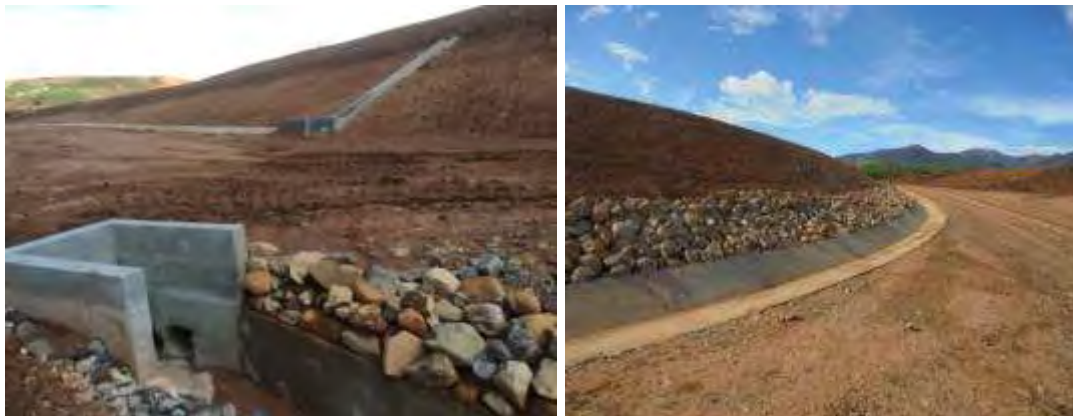
Figura 124. Estado actual de la escombrera 1, nótese las obras de manejo de agua pluvial ya construidas.
