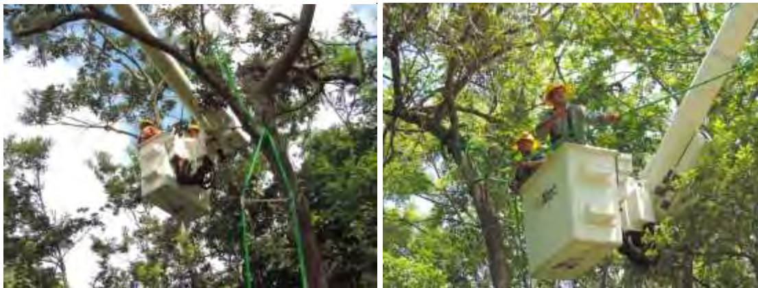
Figura 110. Instalación de pasos aéreos para fauna arborícola.
