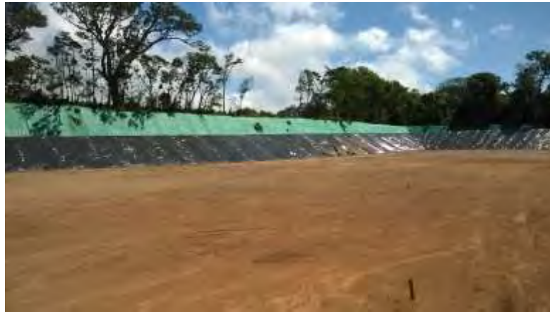
Figura 161. Excavación terminada de la Laguna 4 con los taludes protegidos.
