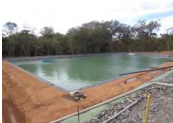
Figura 26. Lagunas utilizadas para el manejo de fluidos geotérmicos y de perforación.
