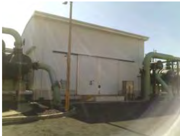
Aislamiento térmico y acústico de la caseta de turbina, 14 de diciembre.
