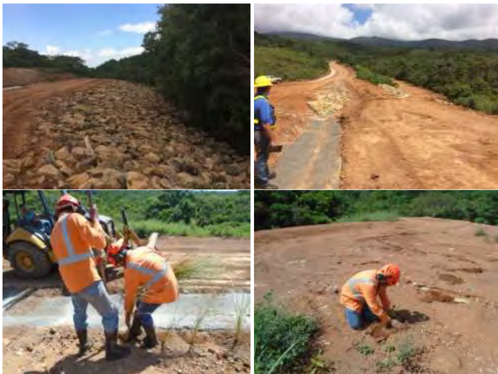
Figura 126. Actividad de siembra de zacate vetiver y de árboles en sector de la escombrera de la Plazoleta 13.
