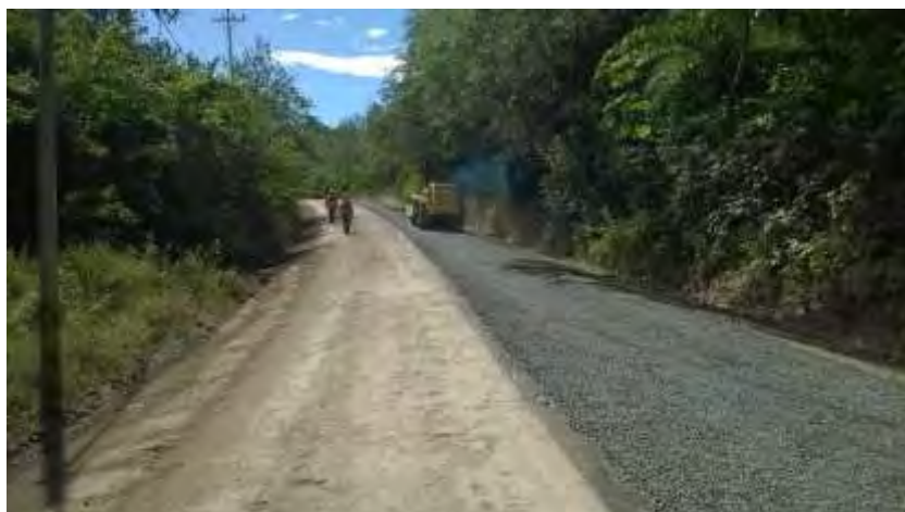
Figura 166. Tratamiento con Emulsión Asfáltica Curubandé-Pailas.
