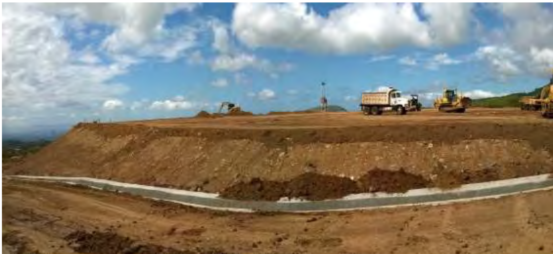
Figura 163. Muestra avance de los trabajos en la Escombrera Pailas I y de las cunetas.
