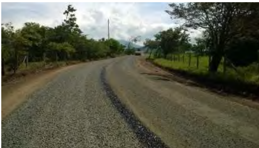
Figura 167. Tratamiento con Emulsión Asfáltica Guayabo-Pailas.
