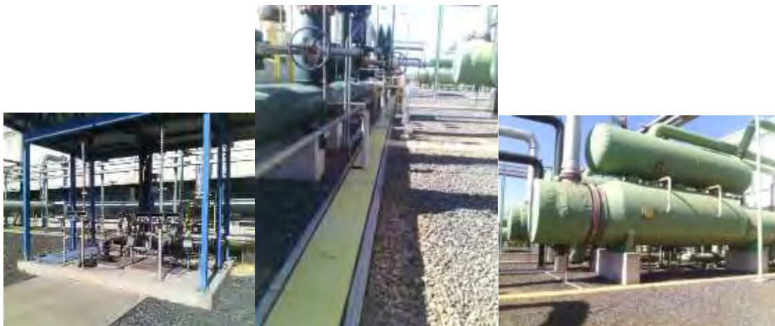
Sistema de recolección y neutralización de drenajes de condensados, se encuentran en buen estado, 14 de diciembre.
