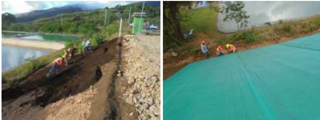
Figura 51. Trabajos de colocación de ecomatrix en taludes de Plazoleta 11, nótese como la tierra orgánica se reutiliza en los taludes de las obras.
