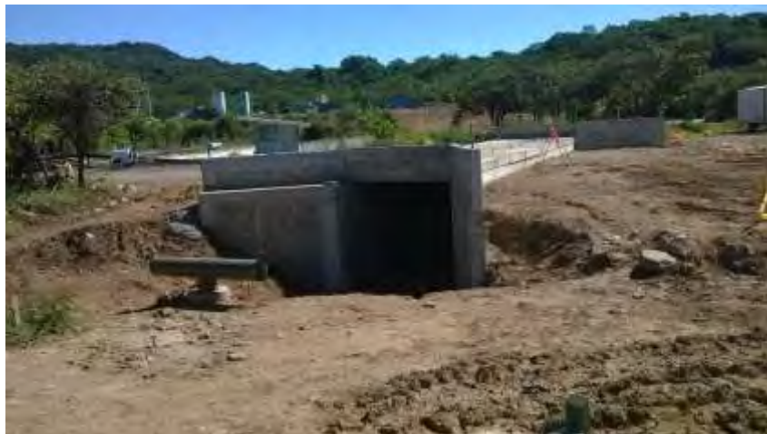
Figura 155. Paso-ducto ruta V (U1/CM2-IP1).
