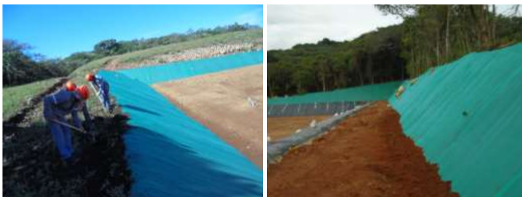
Figura 47. Tratamiento de taludes, se ha implementado eco-matrix en las Lagunas 2 y 4.
