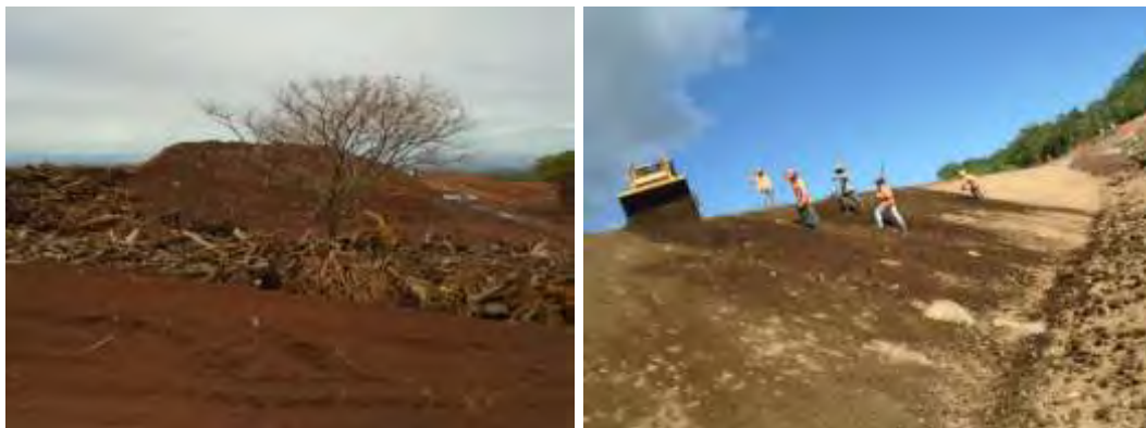
Figura 52. Resguardo de tierra orgánica en Escombrera 1, este material se reutiliza en acondicionamiento de áreas donde se requiere recuperación vegetal.
