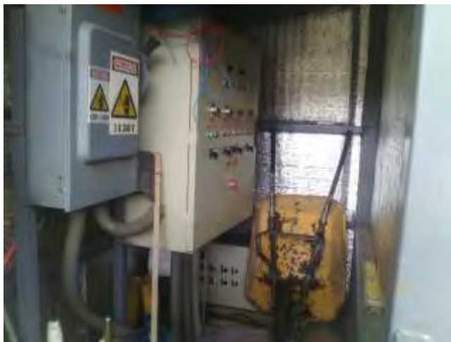
Se instaló agitador y cableado del panel de control nuevo.
