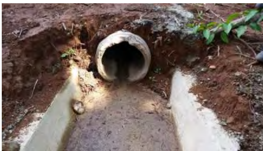
Figura 32. Sedimentador en el Proyecto Geotérmico Las Pailas II.
