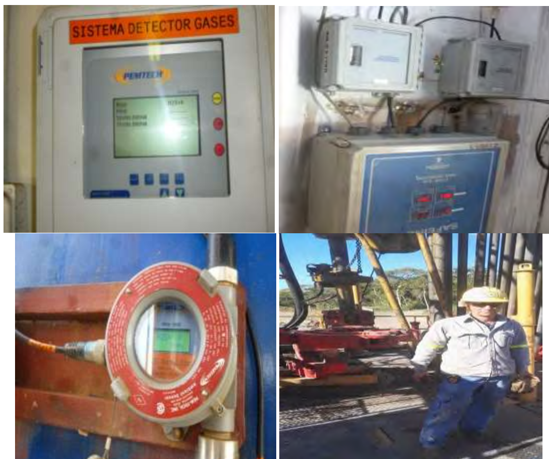
Figura 16. Detectores portátiles y fijos con alarmas audibles de H_2S y CO_2 .
