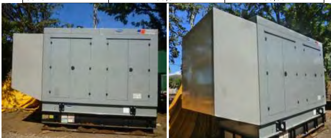
Figura 19. Equipos con mejoras ingenieriles para minimizar el nivel de ruido.
