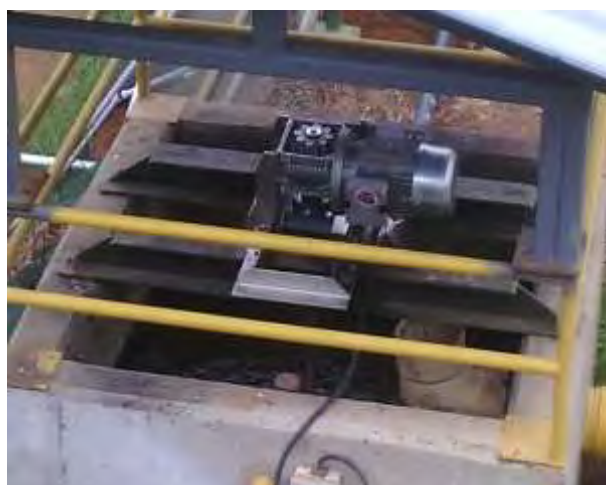
Se instaló agitador y cableado del panel de control nuevo.
