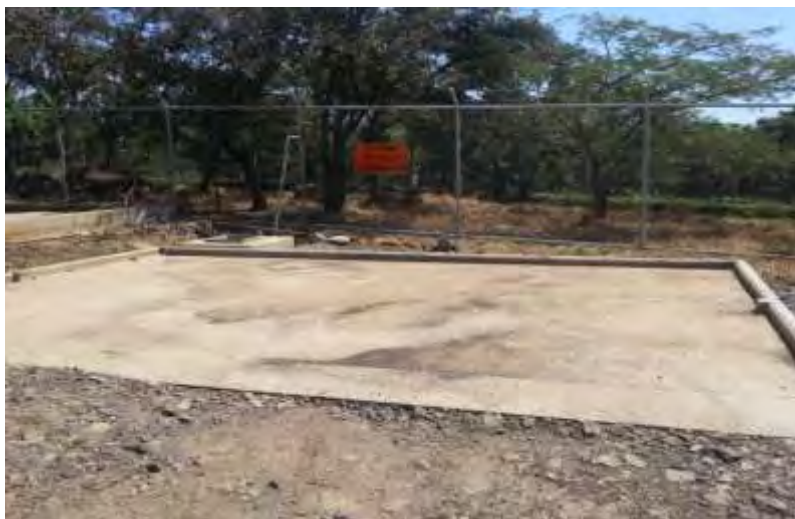
Figura 43. Losa para trasiego de combustibles del Proyecto.
