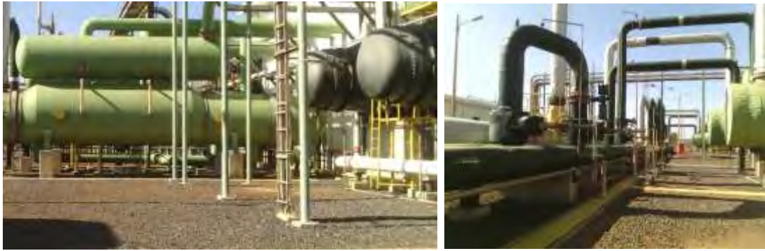
Tuberías recubiertas con forros aislantes térmicos, 14 de diciembre.
