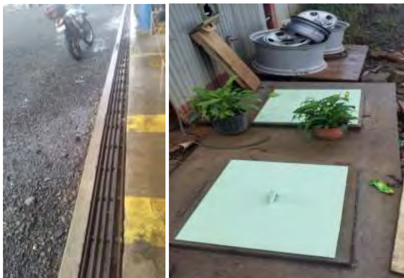
Figura 41. Canal perimetral y trampa de aceite del Taller Mecánico.
