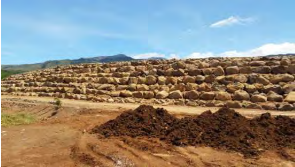
Figura 123. Dique de retención de la Escombrera Pailas I.
