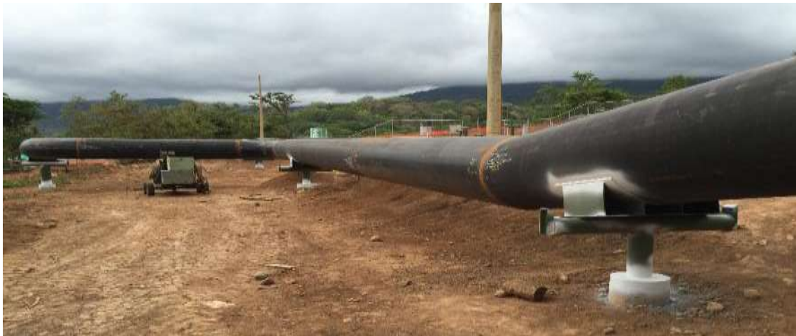
Figura 140. Sección VS2-Unión (vapor), finalizada.
