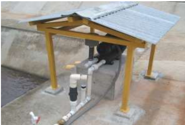
Soplador de aire y lecho de secado limpio
