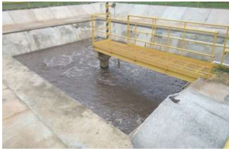
Aireadores de la laguna de homogenización y reactor, con aireación con boquillas nuevas
