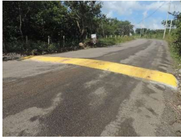
Figura 82. Reductor de velocidad ubicado en los accesos a sitios de obra.
