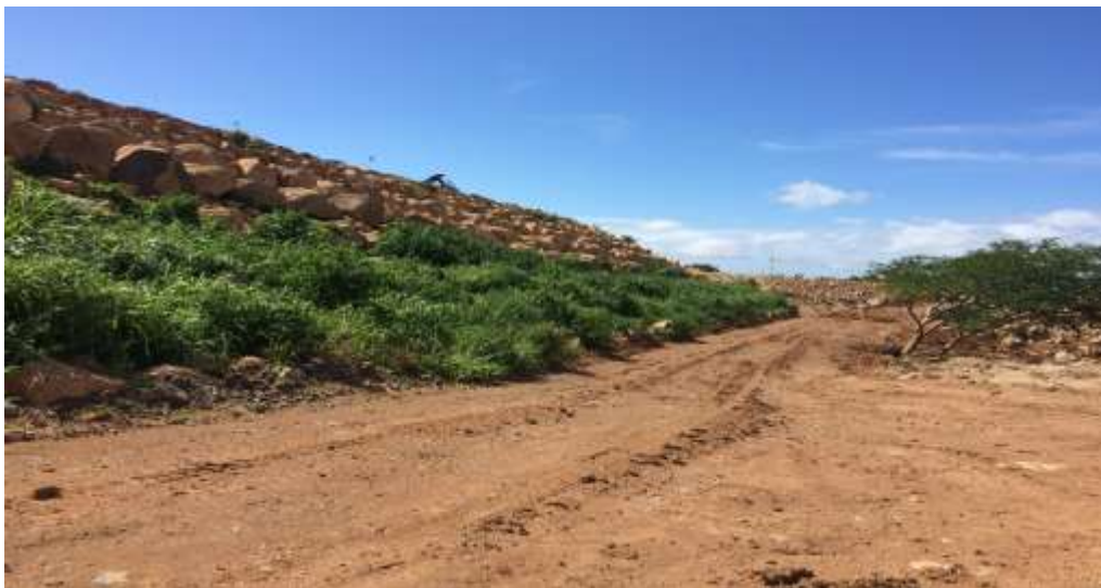
Figura 113. Dique de retención de la Escombrera Pailas I.
