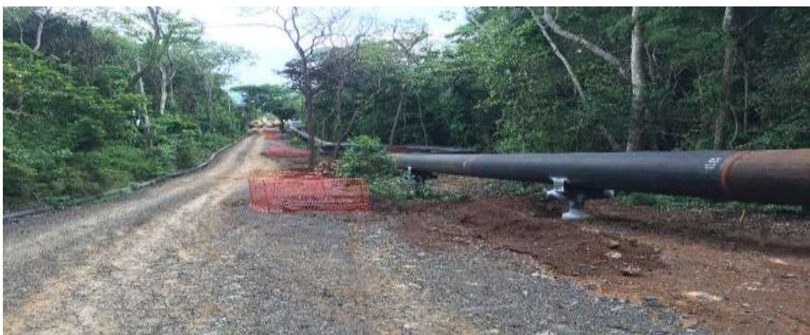
Figura 141. Sección VS3-Unión (vapor), finalizada.
