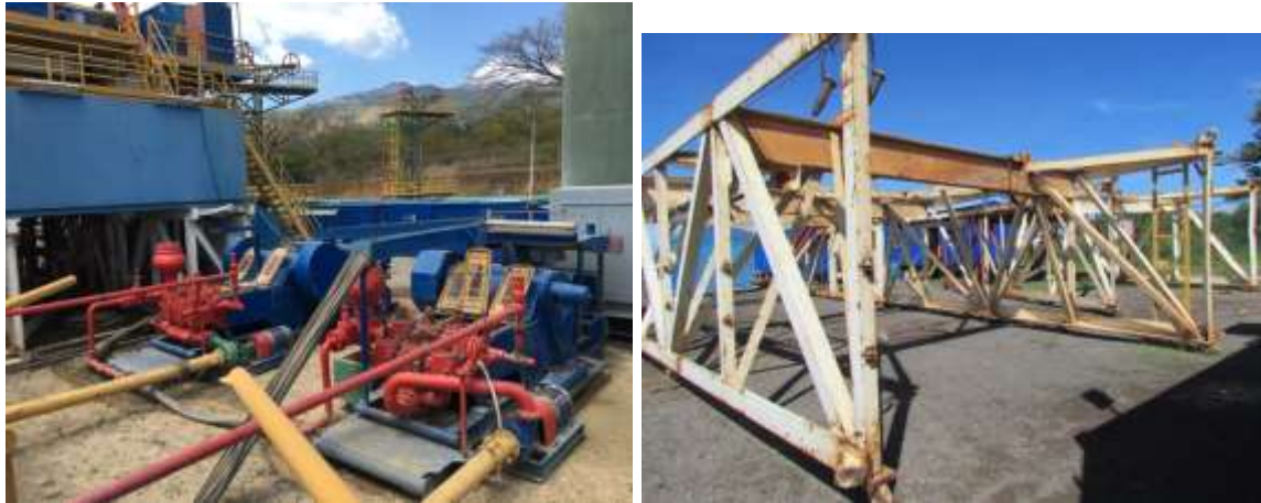
Figura 13: Trabajos de mantenimiento en plataforma de perforación PLP-14.
