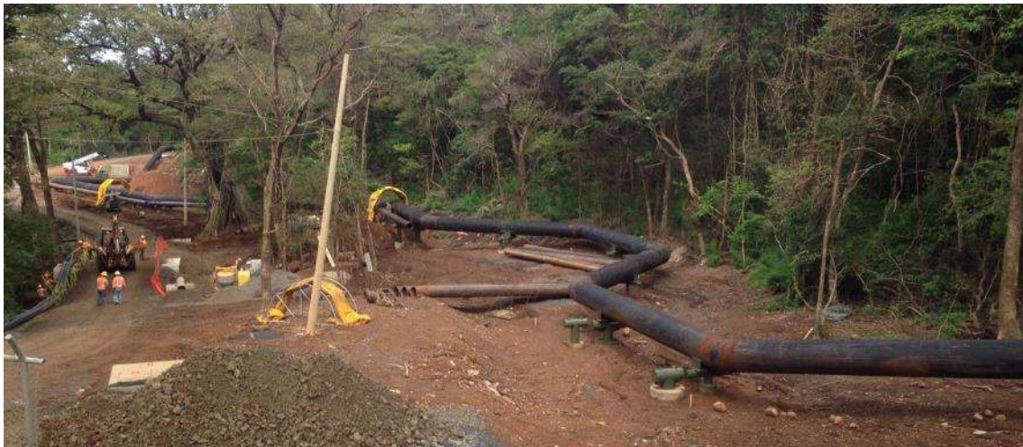
Figura 143. VS4-CM- IP2 Parte 1 (vapor), en ejecución.
