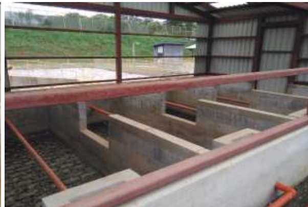
Soplador de aire y lecho de secado limpio
