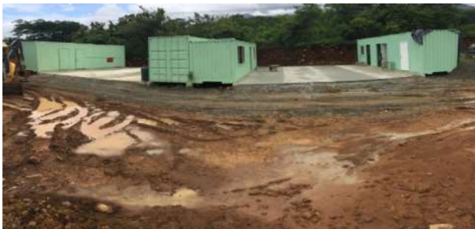
Figura 137. Instalación de Talleres provisionales en el área de Casa de Máquinas.
