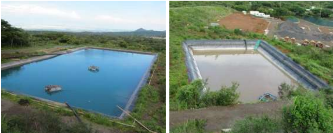
Figura 4: Lagunas utilizadas para el manejo de fluidos geotérmicos y de perforación.
