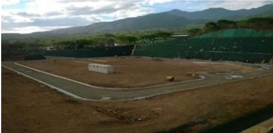
Figura 136. Explanada de Casa de Máquinas con obras de infraestructura completadas.
