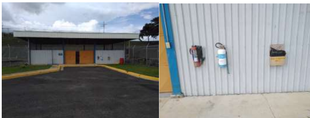
Bodega de inflamables y extintores y hojas de seguridad
