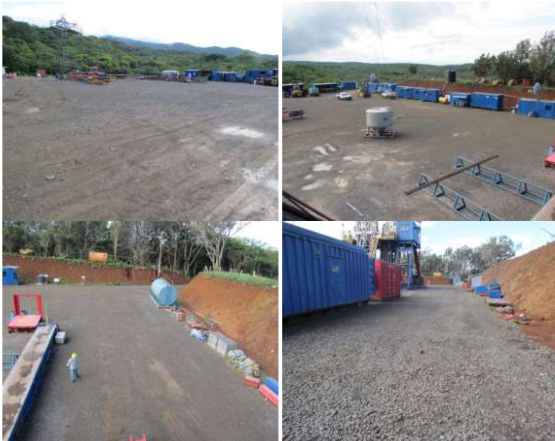
Figura 12: Vistas panorámica de plataforma en perforación PLP-13
