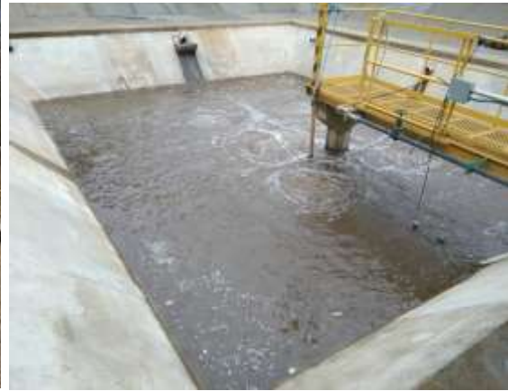
Vista general de planta de tratamiento y vista de la laguna de homogenización con nuevos aireadores.
