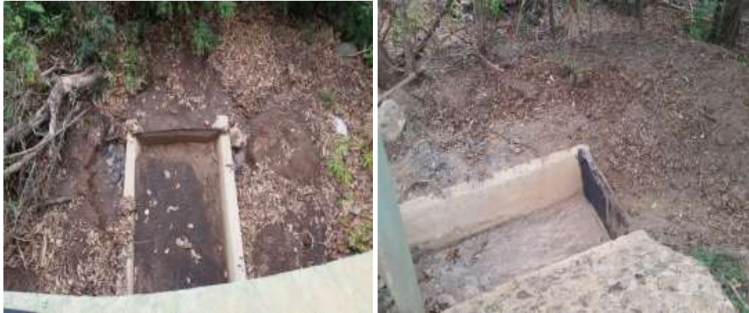
Figura 64. Inspección de sedimentadores abril y mayo.
