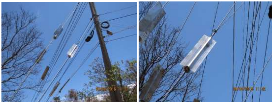
Figura 105. Colocación de láminas antiescalamiento en LD.
