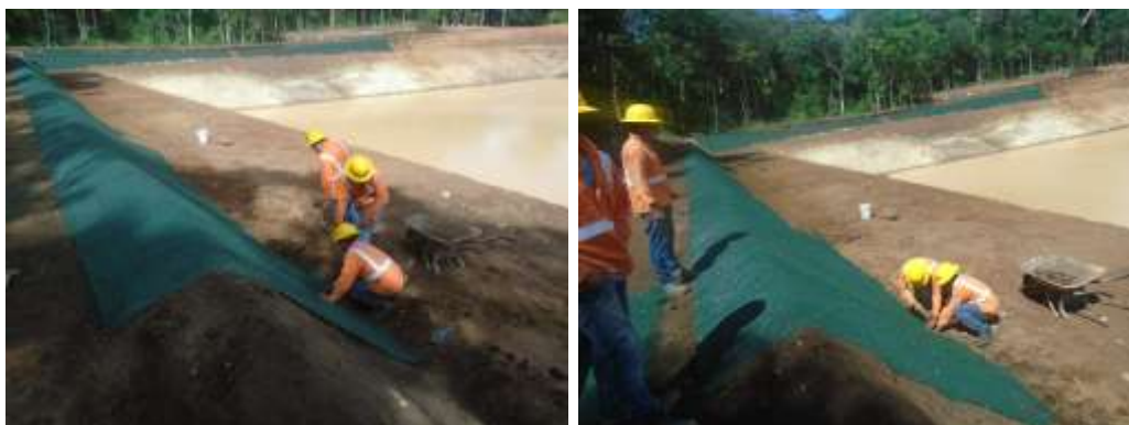
Figura 43. Colocación de Geo-manta en la laguna de enfriamiento 3.
