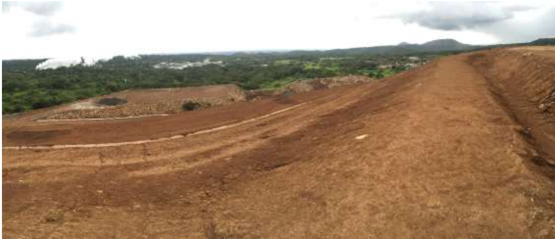
Figura 155. Escombrera Pailas I.
