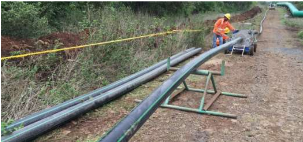
Figura 152. Construcción del acueducto de Casa de Máquinas.
