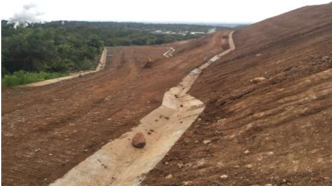
Figura 154. Muestra el avance de los trabajos en la escombrera Pailas I y de las cunetas.
