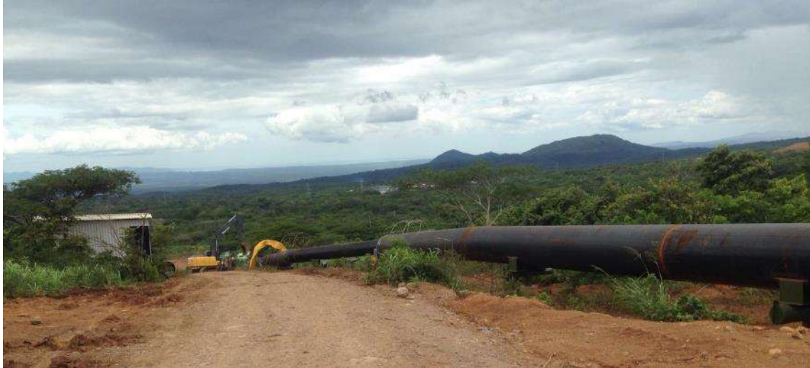
Figura 142. Sección Unión-CM- IP1 (vapor), en ejecución.
