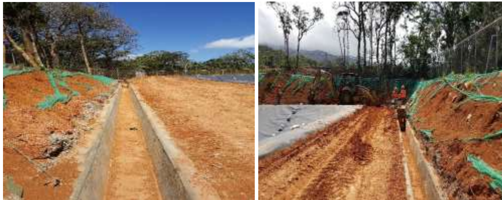
Figura 45. Trabajos de construcción de cunetas en la laguna de enfriamiento 4.
