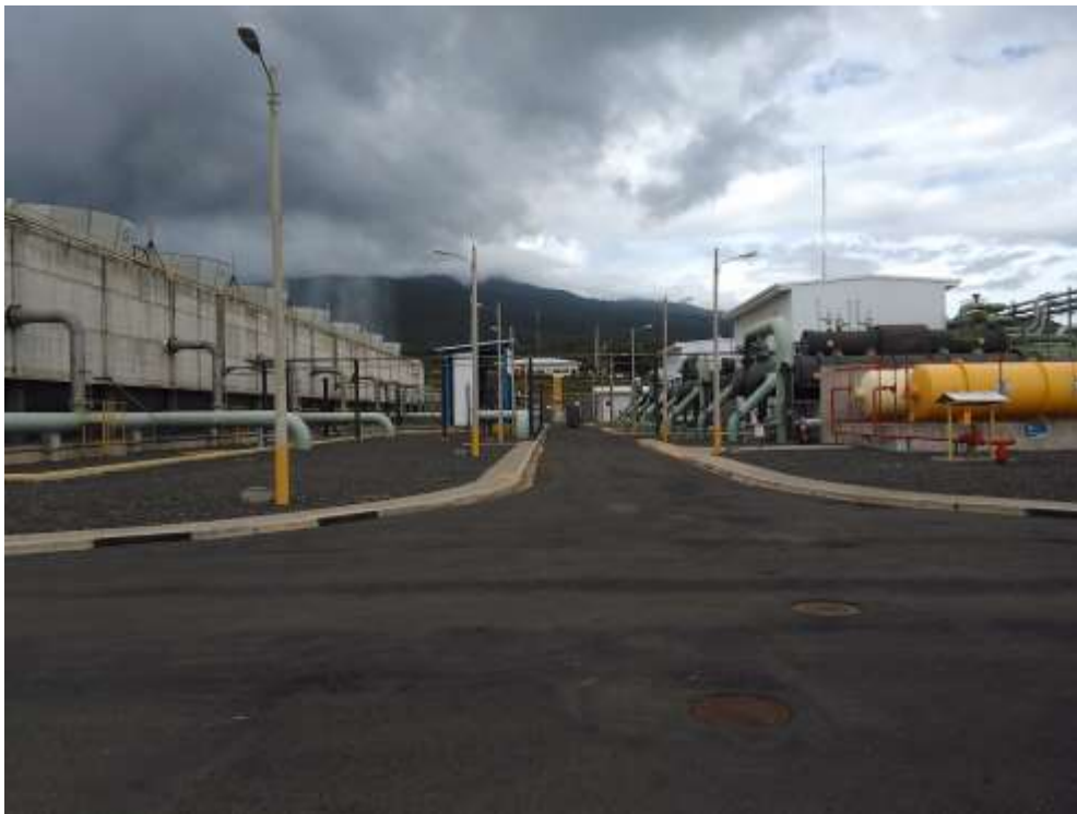
Vista de la planta, se encuentra en buen estado de conservación
