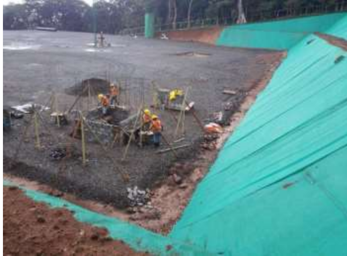
Figura 138. Construcción Caseta de Monitoreo en la Plazoleta 12.
