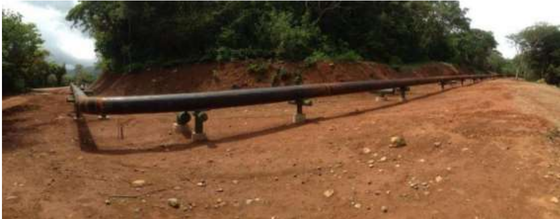
Figura 139. Sección AS2-PL14 (Reinyección en frío), finalizada.
