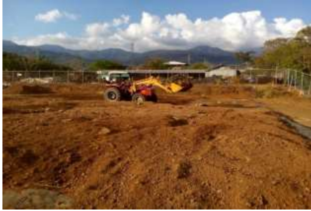
Figura 103. Cobertura de residuos orgánicos en relleno sanitario.
