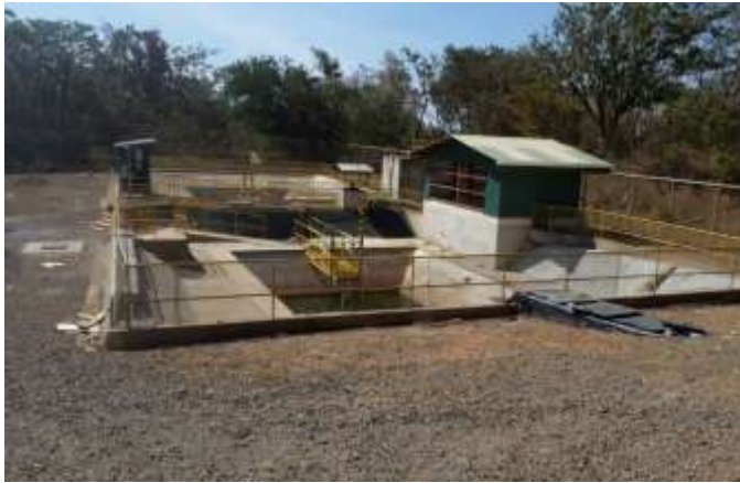
Vista general de planta de tratamiento y vista de la laguna de homogenización con nuevos aireadores.
