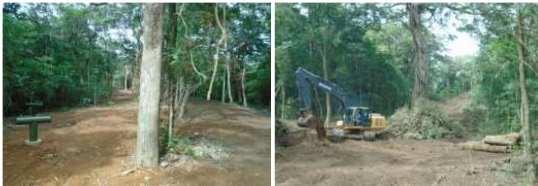
Figura 49. Se evitó la corta innecesaria de árboles de grandes dimensiones.
