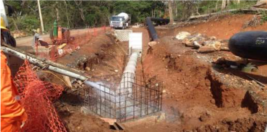
Figura 151. Construcción del alcantarillado PL11- Laguna 4.
