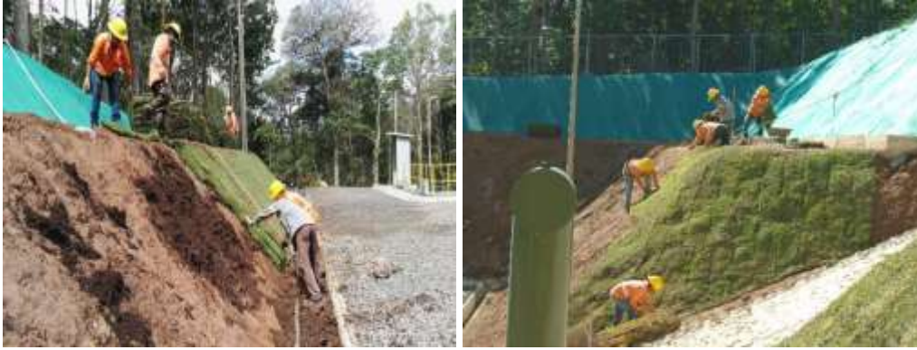
Figura 44. Trabajos de protección de taludes con zacate en la estación separadora 3.
