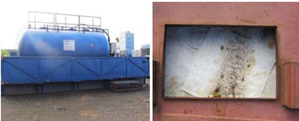
Figura 8: Uso de toallas absorbentes en trampas para aguas oleaginosas en PGP-53.
