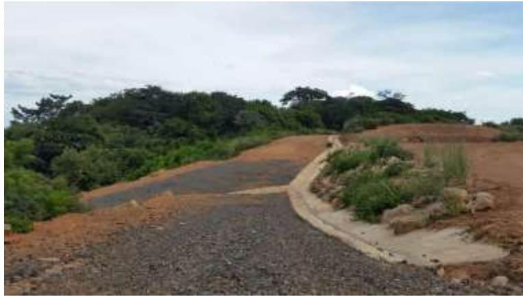
Figura 53. Seguimiento a recuperación de Escombrera de la PL-13.
