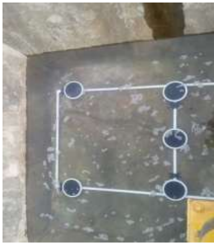
Aireadores de la laguna de homogenización y reactor, con aireación con boquillas nuevas
