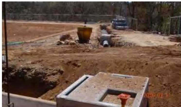
Figura 165. Construcción de Bypass Laguna 4.
