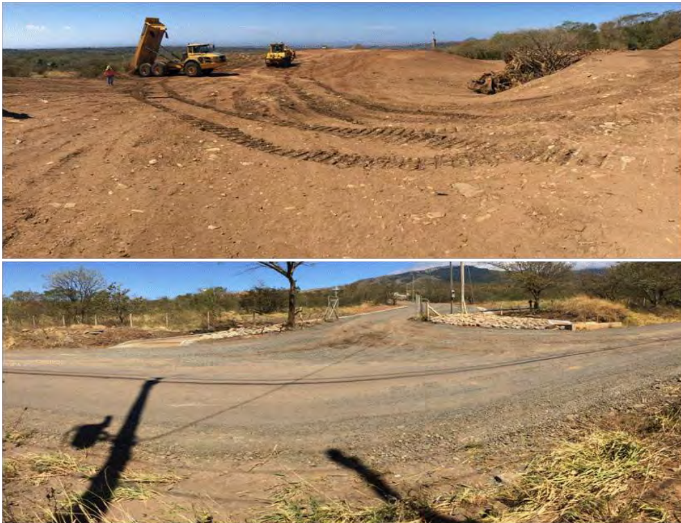
Figura 169. Escombrera Pailas I entrada y obras de manejo de aguas.
