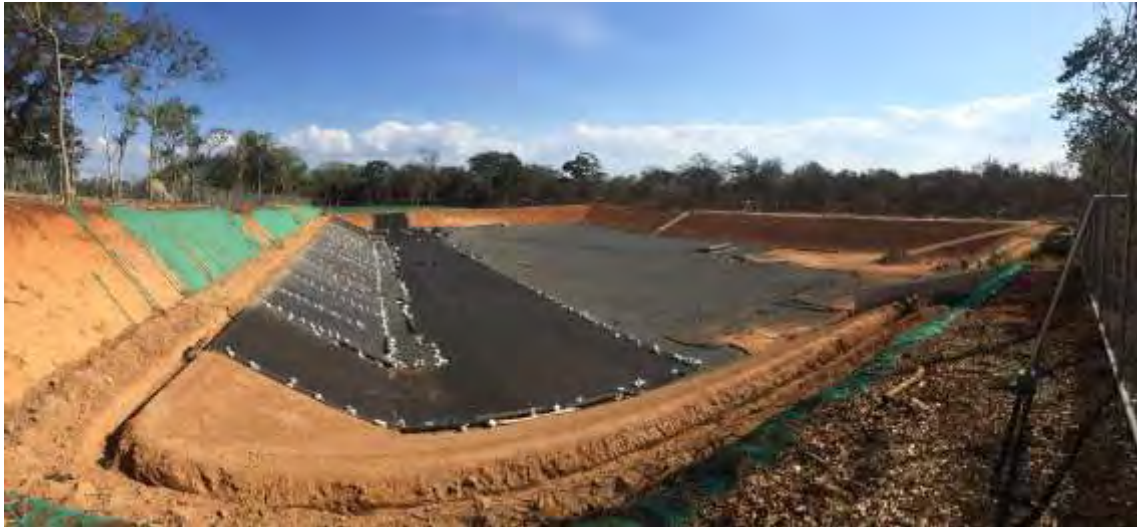
Figura 163. Trabajos de impermeabilización y cerramiento de la Laguna 4.
