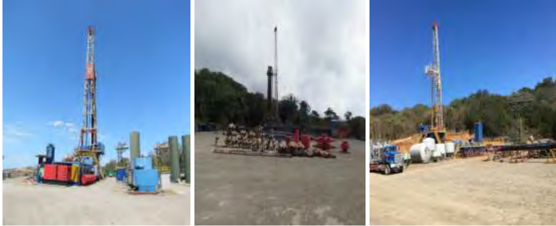
Figura 11. Vistas panorámicas de plataformas en perforación PLP-1, PLP-15 y PLP-13.
