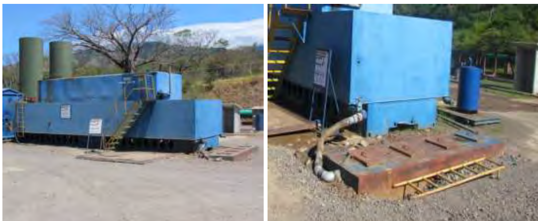
Figura 8. Uso de toallas absorbentes en trampas para aguas oleaginosas en PGP-14.
