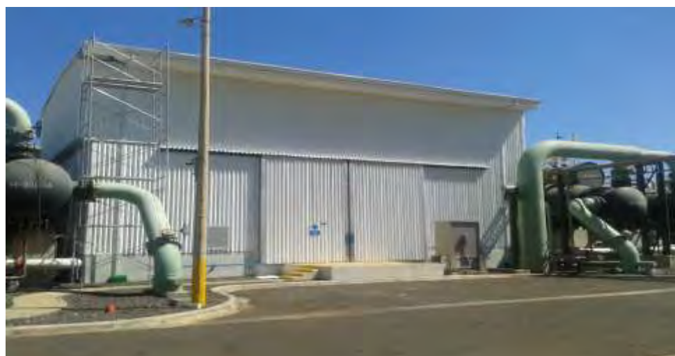
Aislamiento térmico y acústico de la caseta de turbina, 15 de marzo
