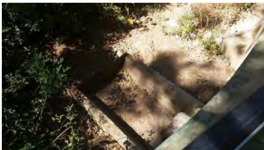
Figura 32. Sedimentador en el Proyecto Geotérmico Las Pailas.
