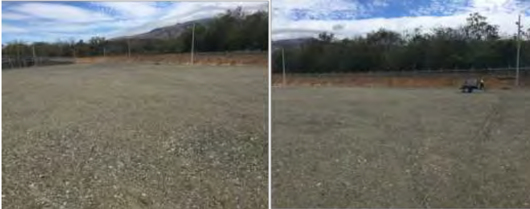
Figura 170. Ampliación de Patio de Materiales para CSRG.
