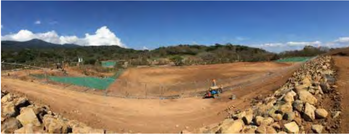
Figura 161. Cerramiento Perimetral Laguna 2
