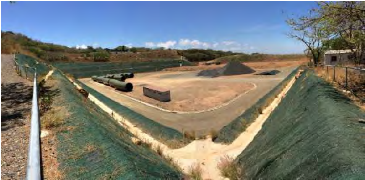
Figura 154. Explanada de Casa de Máquinas con obras de infraestructura completadas.
