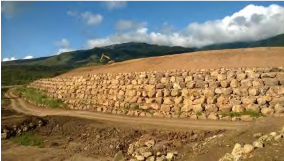
Figura 168. Escombrera Pailas I.
