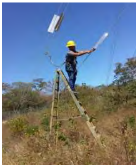
Figura 122. Colocación de láminas anti-escalamiento en LD.
