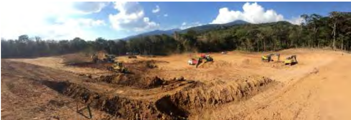
Figura 162. Cerramiento Perimetral Laguna 2
