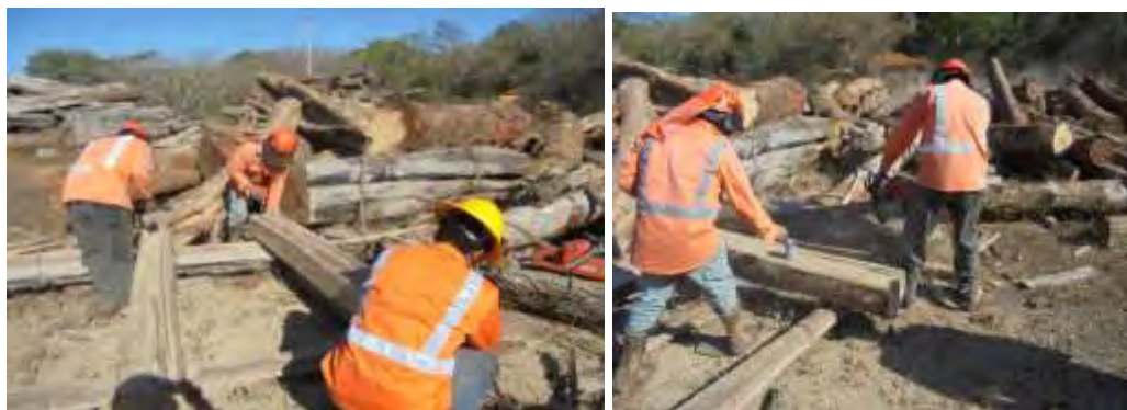
Figura 58. Personal forestal en trabajos de aserrío para cubrir parte del consumo de madera dimensionada del Proyecto.
