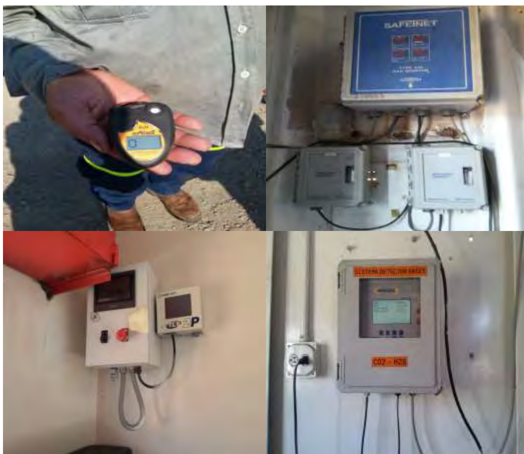
Figura 15. Detectores portátiles y fijos con alarmas audibles de H 2 S y CO 2 .
