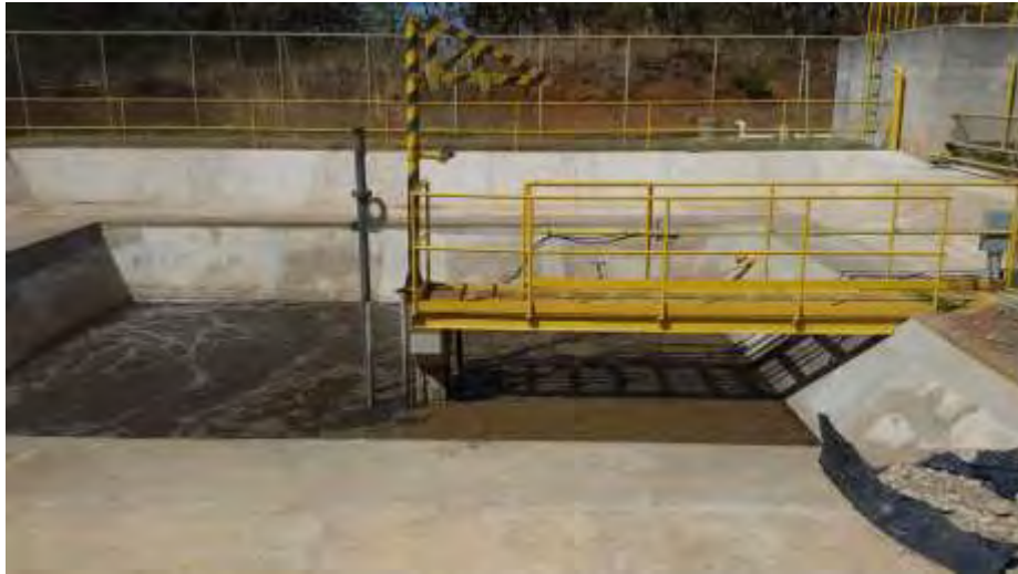
Reactor, vista de la losa perimetral nueva.
