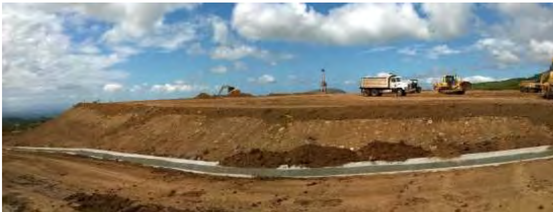
Figura 167. Muestra el avance de los trabajos en la escombrera Pailas I y de las cunetas.
