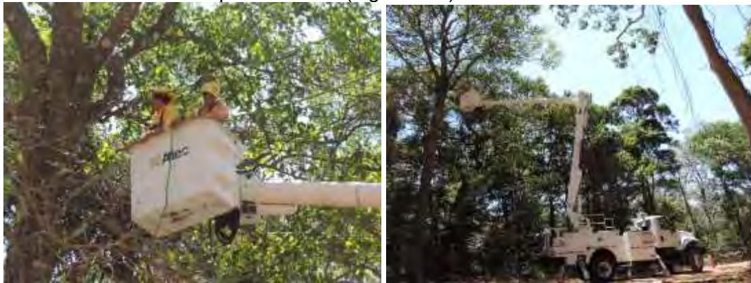
Figura 110. Instalación de pasos aéreos para fauna arborícola.
