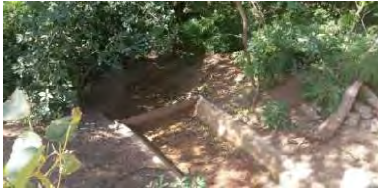
Figura 74. Inspección de sedimentadores correspondiente a enero.
