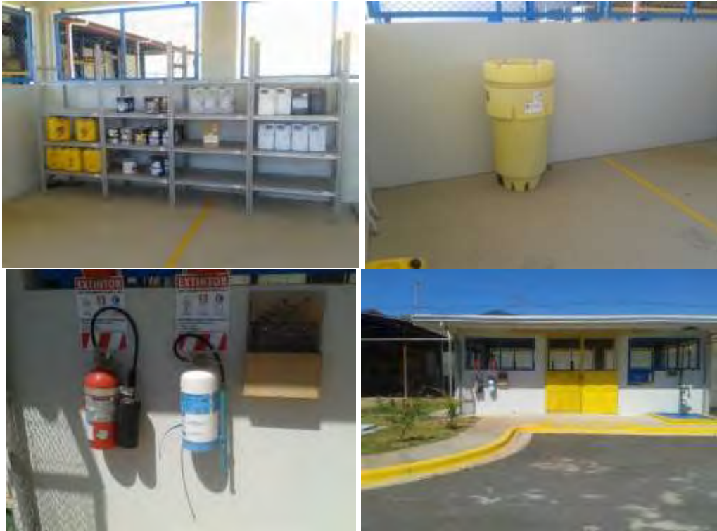
Vista de Bodega de químicos 15 de marzo.
