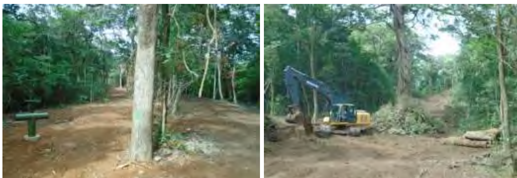
Figura 56. Se evitó la corta innecesaria de árboles de grandes dimensiones.
