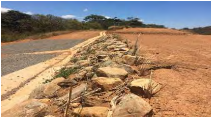
Figura 63. Seguimiento a recuperación de Escombrera de la PL-13.
