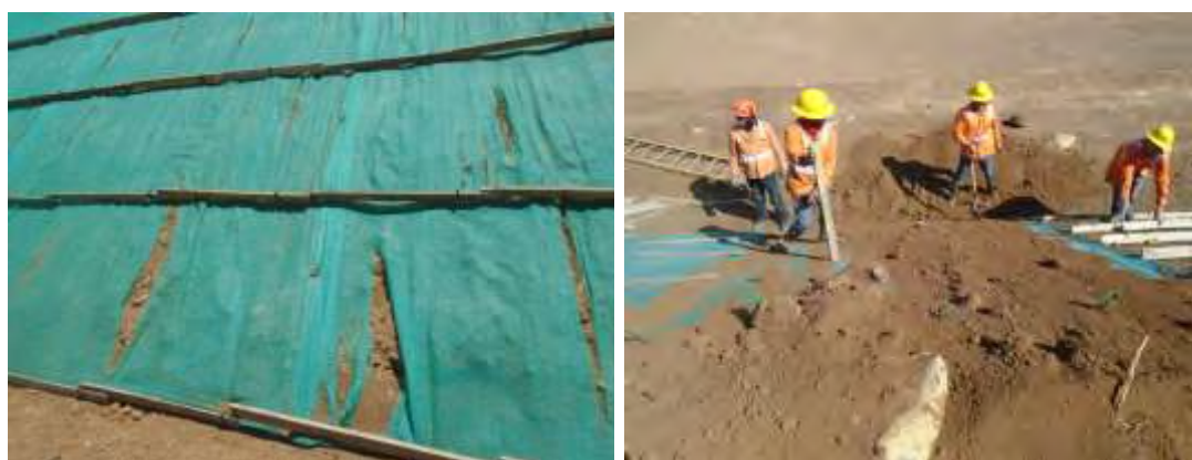
Figura 45. Reparación de ecomatrix en la Laguna 2.
