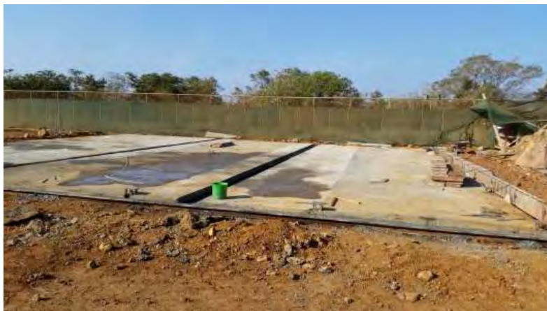
Figura 119. Habilitación de un espacio para implementar una compostera.
