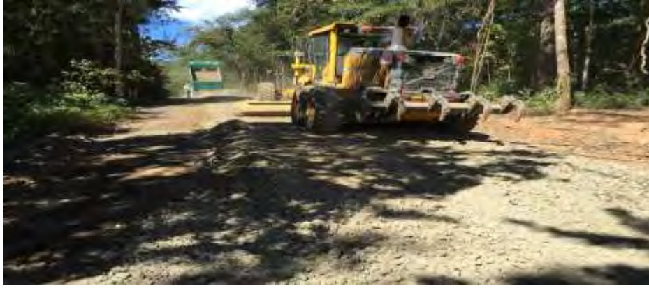
Figura 171. Conformado y compactado de Caminos internos hacia el PG Borinquén.
