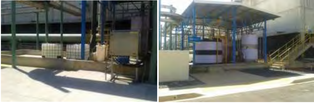
Sistema de soda, muros de contención de derrames se cuenta con un kit de contención de derrames de aceites en el laboratorio. 15 de marzo
