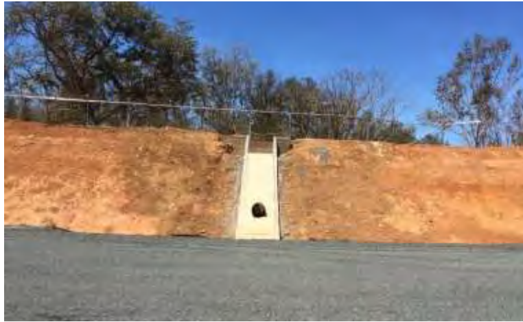
Figura 166. Estructura de Salida.
