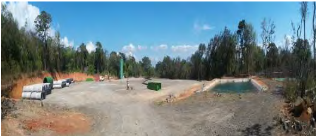
Figura 12. Vistas panorámicas de plataforma de perforación PLP-16.
