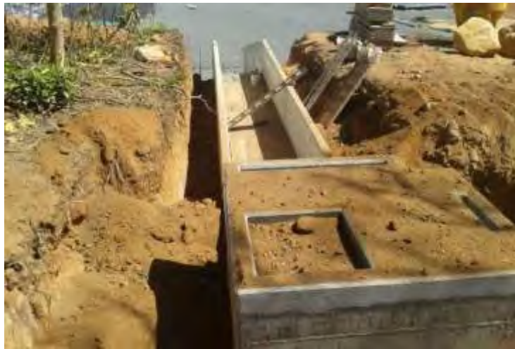
Figura 164. Estructura de Entrada Laguna 4.
