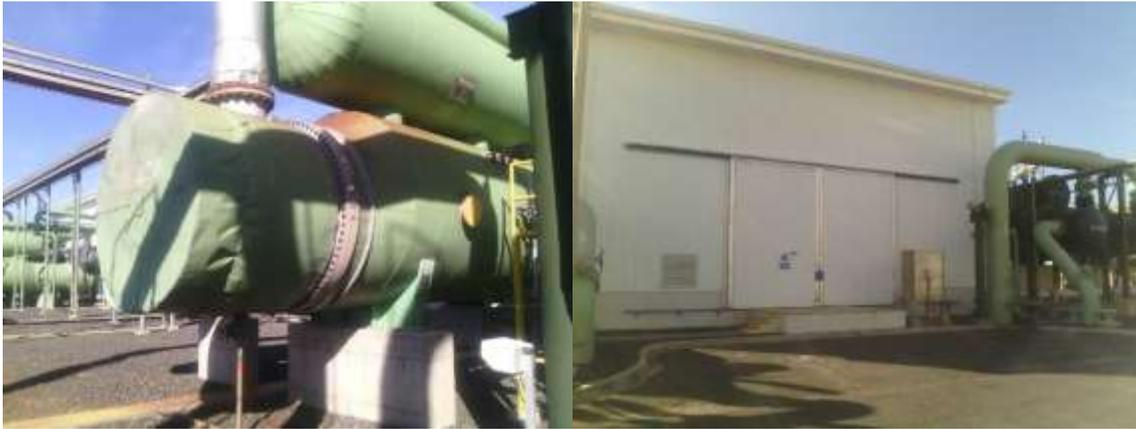
Tuberías recubiertas con forros aislantes térmicos y aislamiento térmico y acústico de la caseta de turbina 20/3/2015
