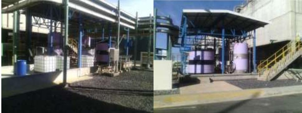
Sistema de soda, muros de contención de derrames se cuenta con un kit de contención de derrames de aceites en el laboratorio. 23/3/2015.
