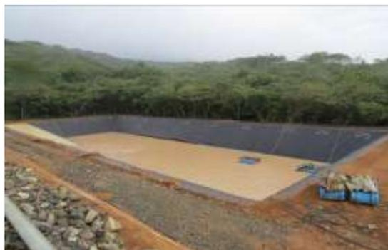
Figura 20. Lagunas utilizadas para el manejo de fluidos geotérmicos y de perforación.
