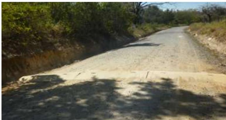
Figura 117. Colocación de reductor de velocidad.
