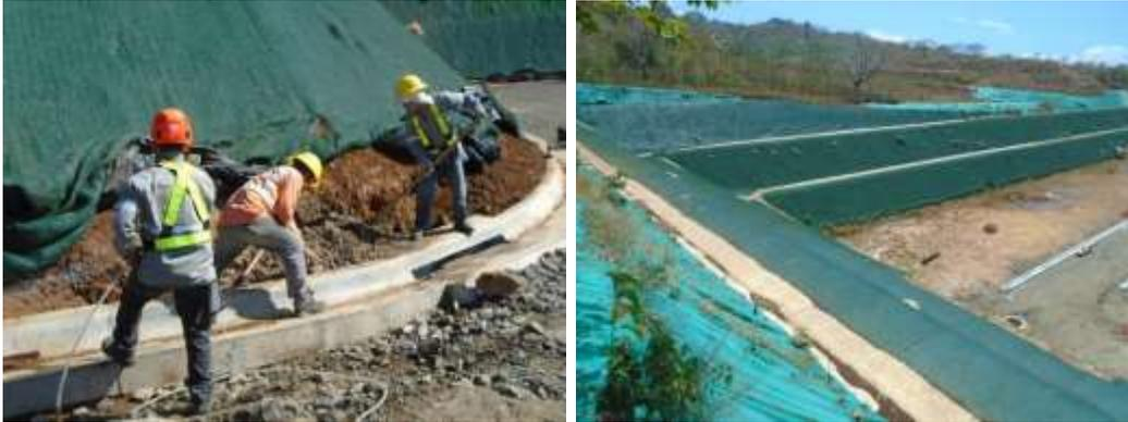
Figura 38. Reacondicionamiento de taludes Casa de Máquinas Pailas II.
