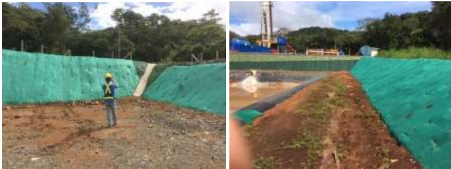
Figura 39. Trabajos de protección de taludes en plazoletas. Todos los taludes de corte de plazoletas y rutas de tuberías llevarán una protección superficial con ecomatrix.
