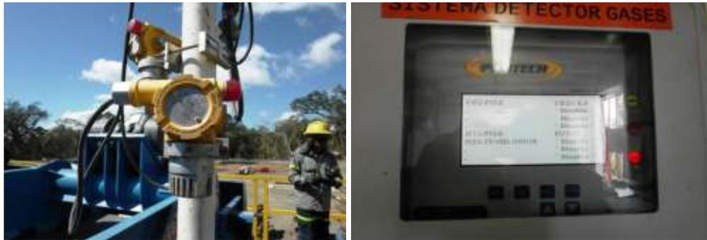
Figura 10. Alarmas audibles instaladas.
