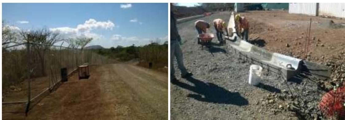
Figura 122. Construcción de cordón y caño en terraza de Casa de Máquinas, así como instalación de malla perimetral en el camino de acceso.
