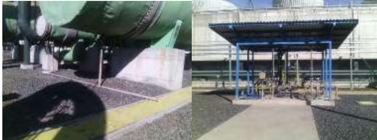
Sistema de recolección y neutralización de drenajes de condensados, se encuentran en buen estado 20/3/2015
