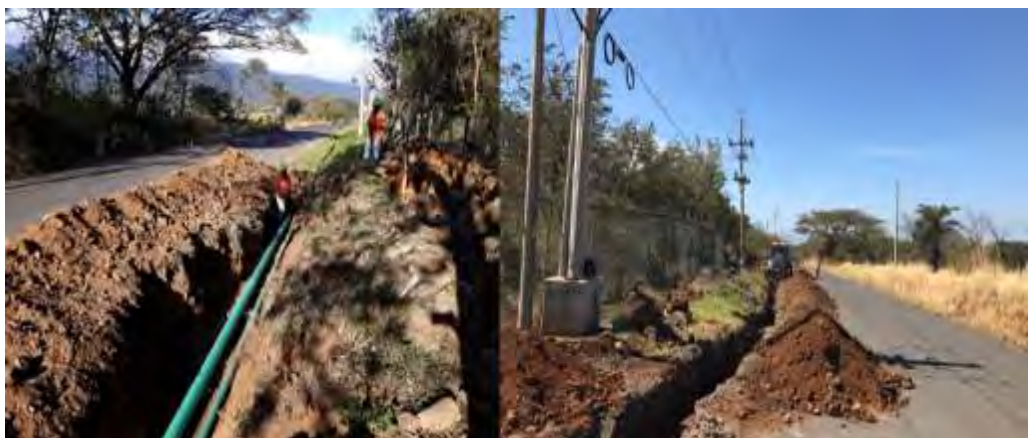
Figura 172. Colocación de tubería de conducción.
