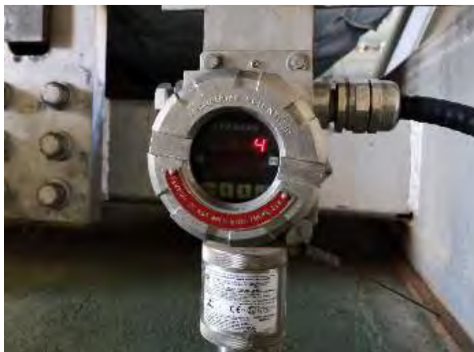
Figura 144. Sistema de medición de pentano fijo en turbina de unidad 1.
