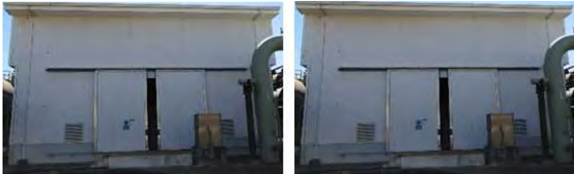
Figura 152. Aislamiento acústico de la Unidad 1 y 2, manteniendo la puerta cerrada.
