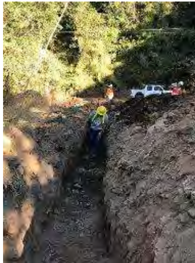
Figura 109. Excavación de canal entre el tanque ICE y tanque Curubandé, Acueducto de Curubandé. Proyecto Geotérmico Pailas Unidad II.
