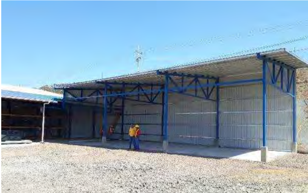
Figura 174. Bodega para almacenamiento de repuestos.
