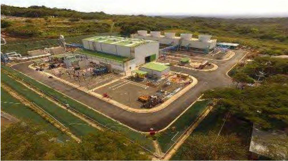
Figura 167. Avance general de Casa de Máquinas.
