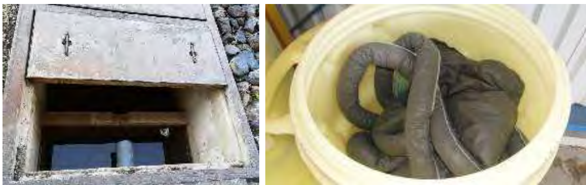
Figura 156. Tanque de contención de derrames y kit de recolección de derrames del almacén de sustancias peligrosas, Área 10.
