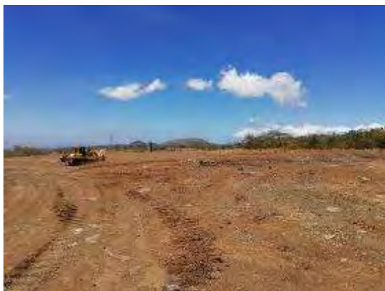
Figura 111. Conformación y acomodo de material en la ampliación de la Escombrera 1.
