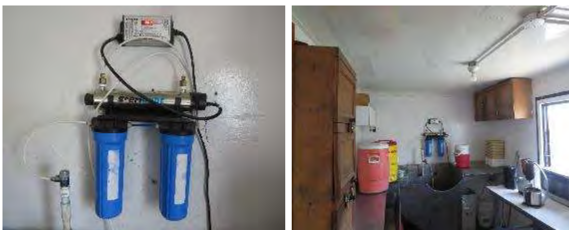
Figura 23: Sitios rotulados para agua potable y no potable.
