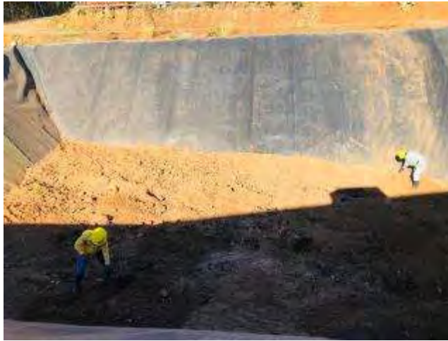
Figura 104. Vertido de residuos orgánicos en el Relleno Sanitario del Proyecto Geotérmico Pailas.
