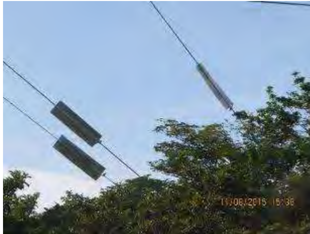
Figura 108. Láminas anti escalamiento.
