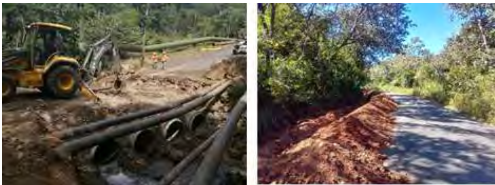
Figura 72. Presencia en sitios de movimientos de tierra. Proyecto Geotérmico Las Pailas II.
