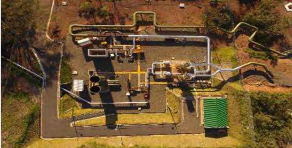
Figura 171. Avances en Estaciones Separadoras.
