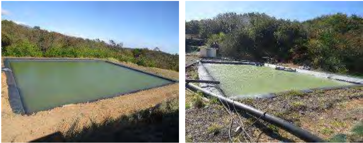
Figura 21: Lagunas almacenamiento de fluidos geotérmicos y de perforación en PLP-03.
