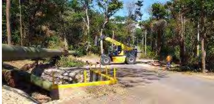
Figura 57. Corta de árboles con riesgo de caída en los caminos internos de Pailas II.
