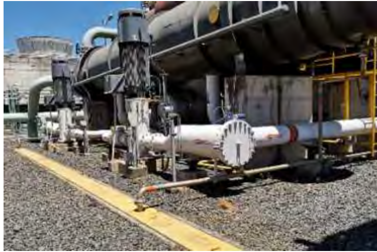
Figura 159. Sistema de drenajes de condensado.
