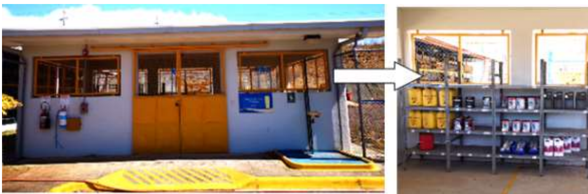
Figura 154. Almacén de sustancias peligrosas, Área 9.
