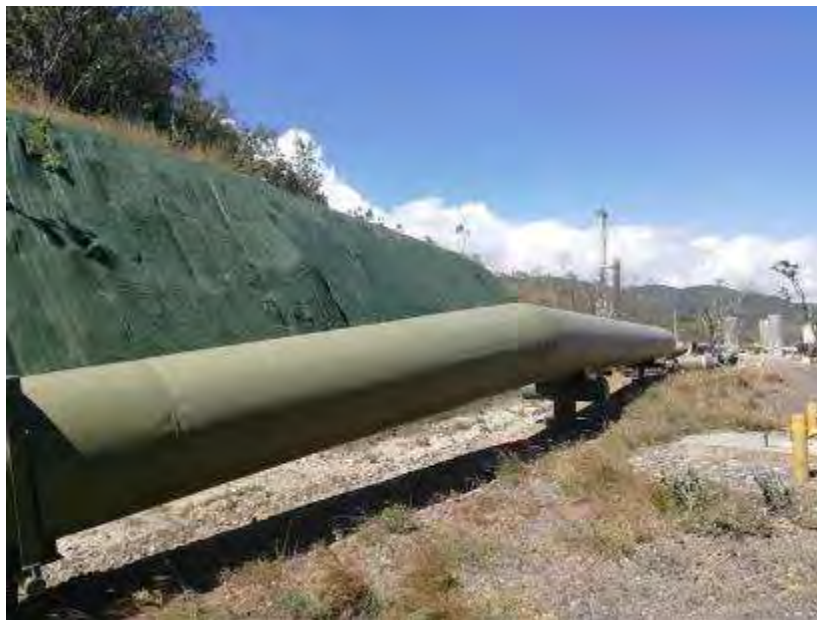
Figura 42. Taludes de los caminos internos de Pailas II cubiertos con geomanto.
