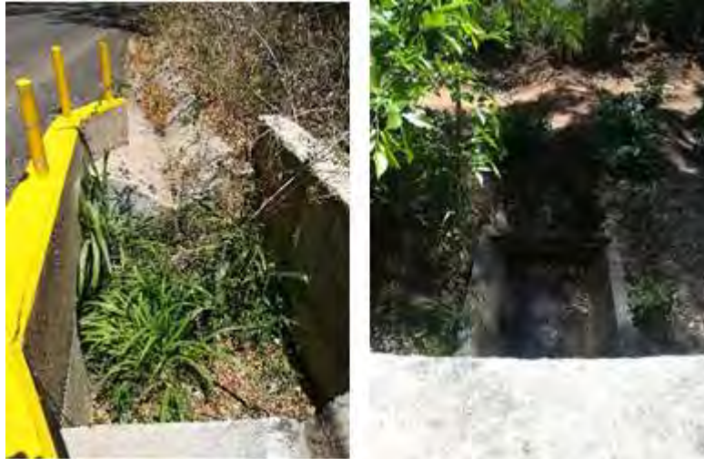
Figura 66. Inspección de sedimentadores en marzo 2019.
