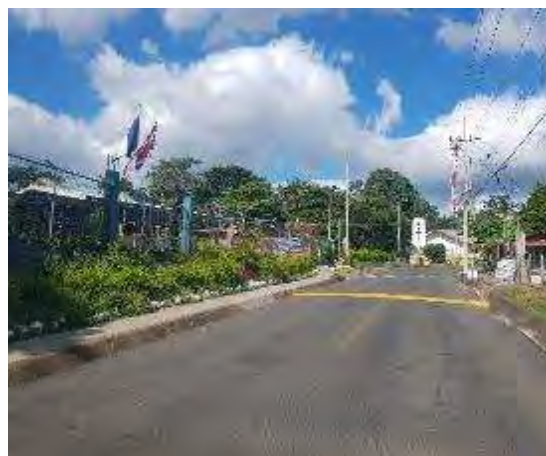
Figura 132. Reductor de velocidad, Curubandé.
