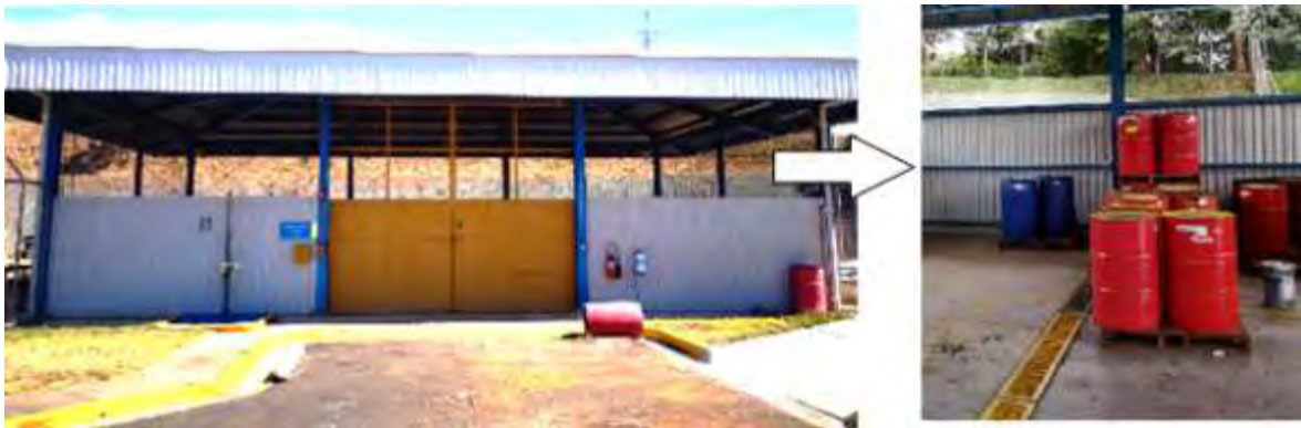
Figura 155. Almacén de sustancias peligrosas, Área 10.
