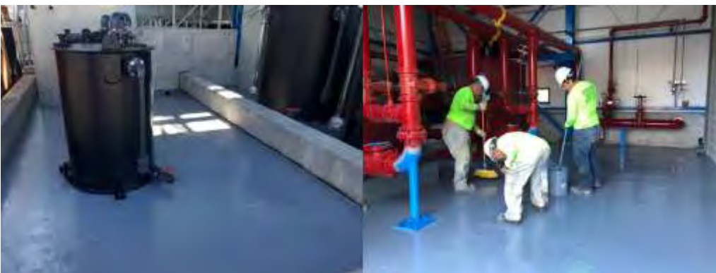
Figura 169. Colocación de recubrimiento epóxico en pisos.
