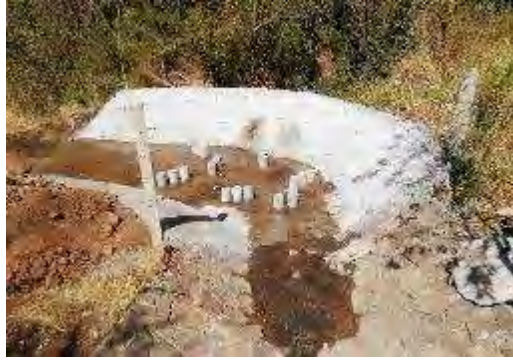
Figura 137. Construcción de cabezal, propiedad Hotel Rincón de La Vieja Lodge.
