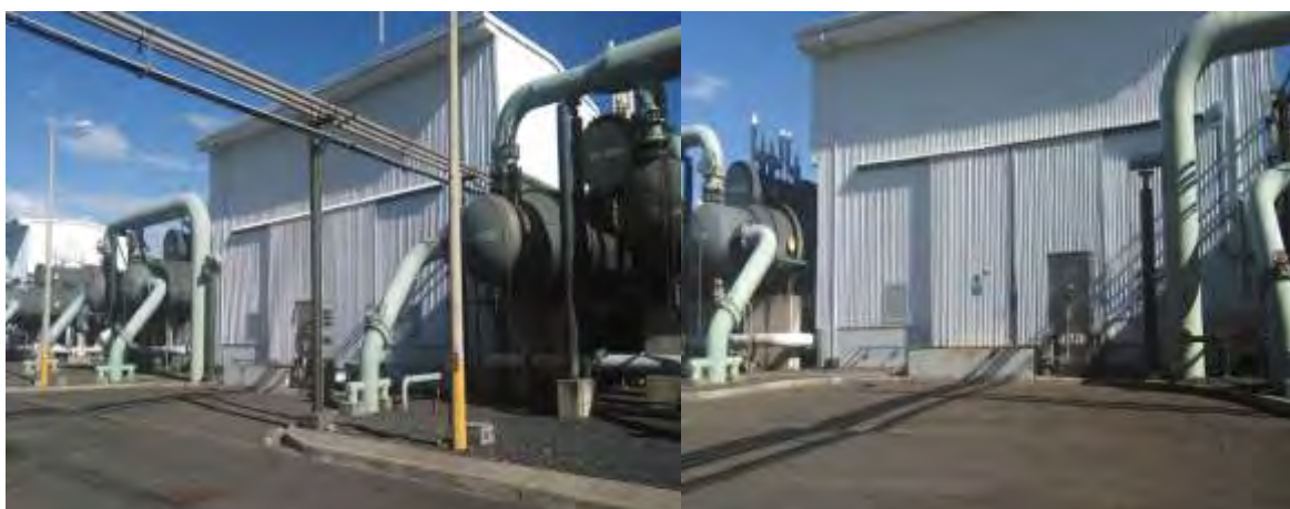
Figura 27. Aislamiento térmico y acústico de la caseta de turbina.
