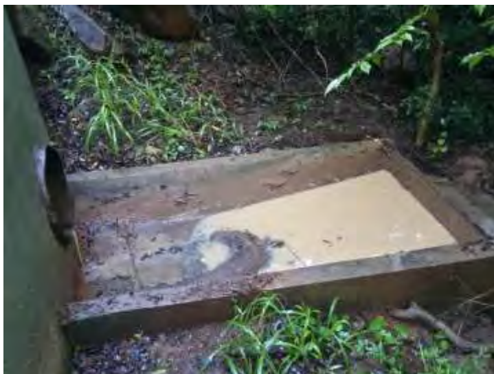
Figura 59. Inspección de sedimentadores en octubre 2017.
