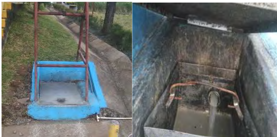
Figura 17. Vista del tamiz de gruesos del comedor.
