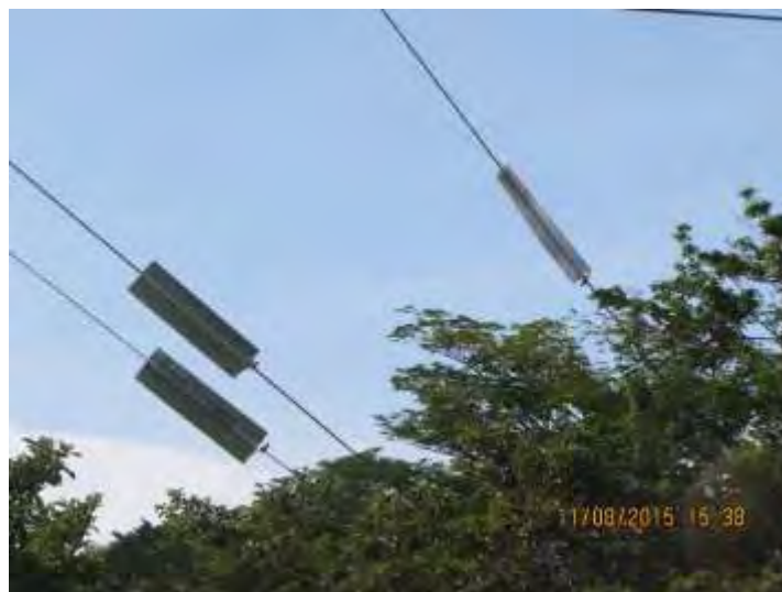
Figura 107. Láminas antiescalamiento.
