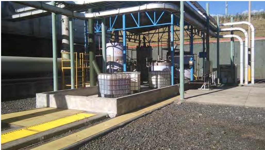
Figura 12. Sistema de soda con muros de contención de derrames
