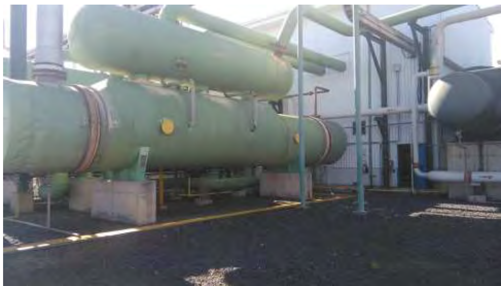
Figura 25. Vaporizadores de pentano con aislamiento térmico.
