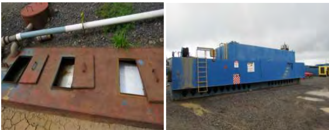
Figura 7. Uso de toallas absorbentes en trampas para aguas oleaginosas en PGP-61.
