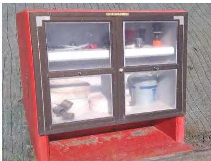
Figura 9. Gabinete con equipo contra incendios, con mangueras, pitones y herramientas.
