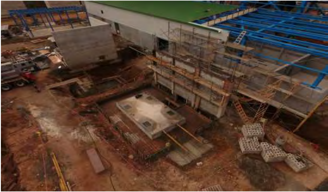
Figura 134. Avance en la cimentación del transformador principal.
