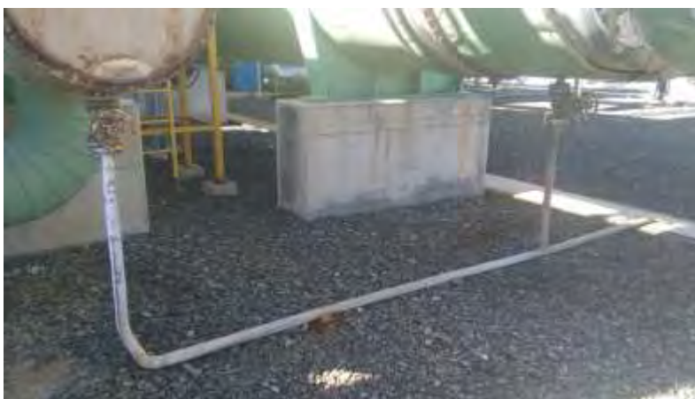
Figura 23. Sistema de drenajes de condensados
