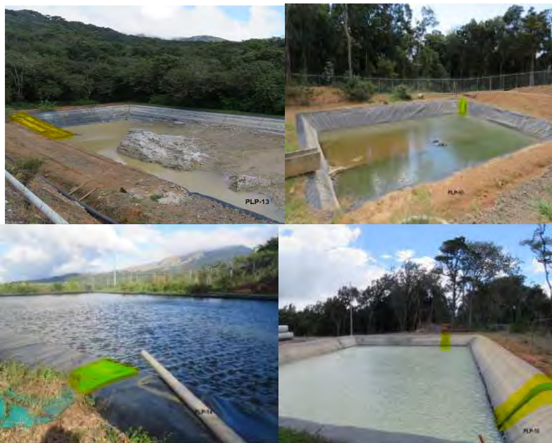
Figura 27. Dispositivos para escape de fauna en plazoletas de perforación.
