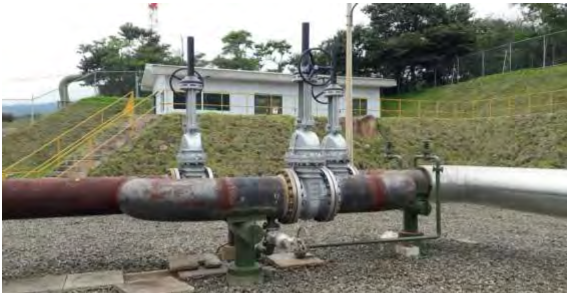
Figura 137. Avance ES-02 (Colocación de válvulas).
