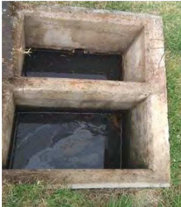
Figura 13. Trampa de aceites de taller 5 de diciembre, está limpia de aceites la salida.
