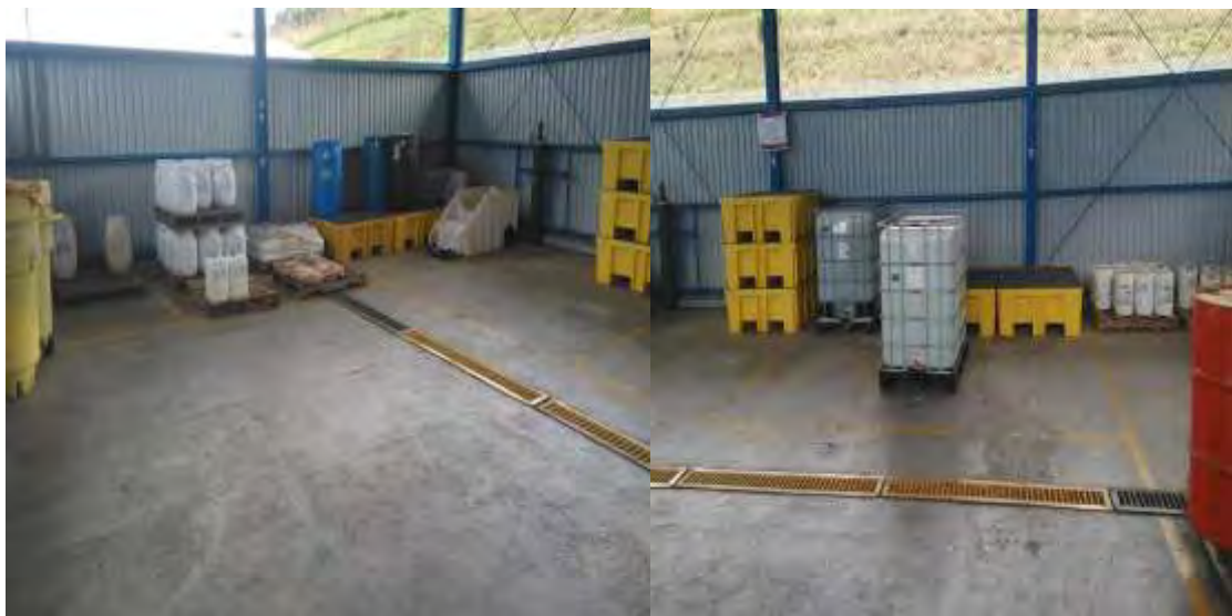
Figura 4. Bodega de inflamables acomoda y sistemas de contencion.
