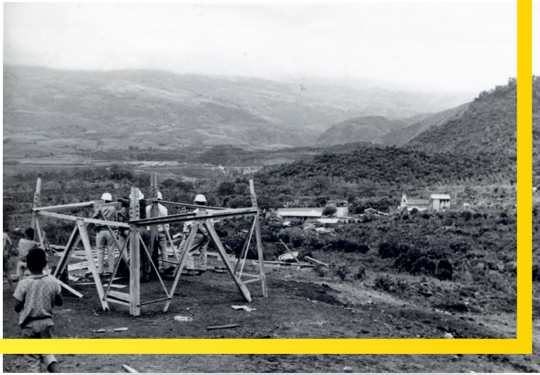
Construcción torre de transmisión, Cachí.
