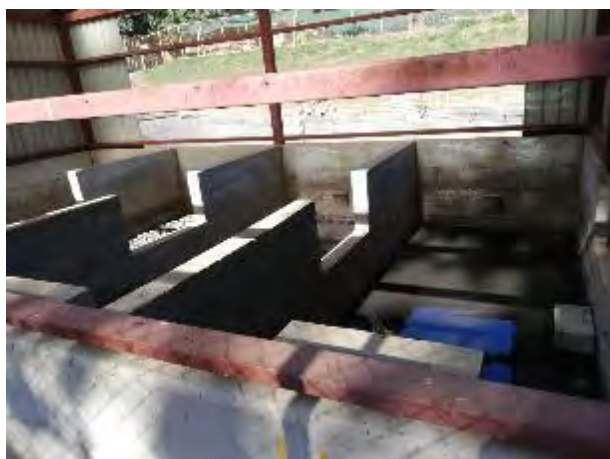
Figura 56. Fosas del lecho de secado, diciembre 2018.
