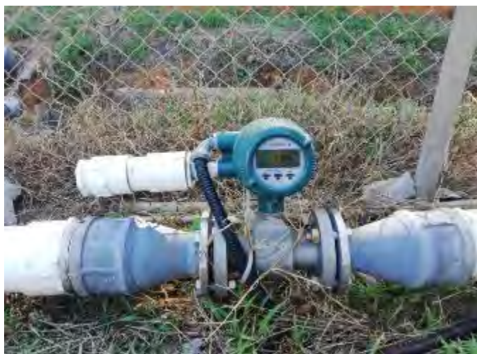
Figura 26. Salida del agua del sedimentador del agua tratada con medidor de flujo magnético. Diciembre, 2018.
