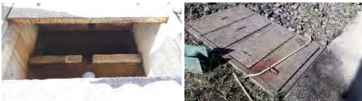
Figura 19. Trampa de aceites de la bodega de inflamables y almohadillas. Diciembre, 2018.
