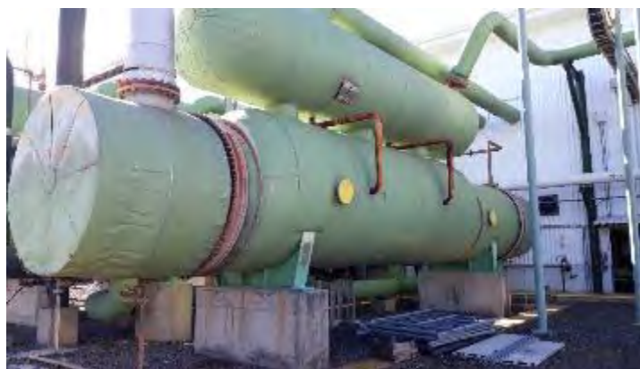
Figura 43. Vaporizadores de pentano con aislamiento térmico en buen estado. Diciembre 2018.
