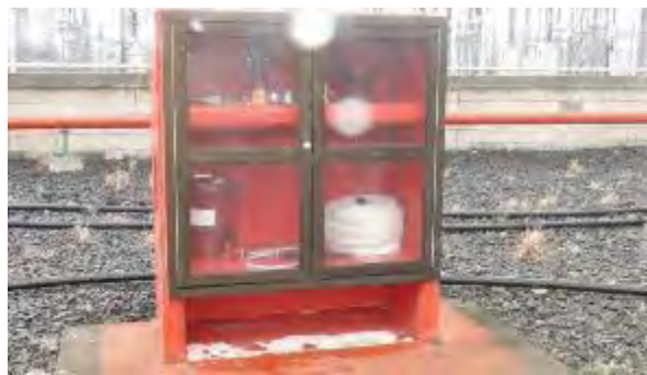
Figura 14. Gabinete con equipo contra incendios en buen estado, con mangueras, pitones y herramientas. Diciembre, 2018.
