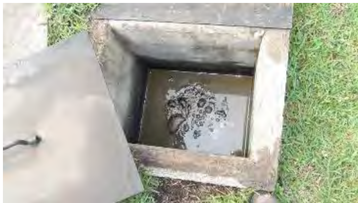
Figura 22. Trampa de aceites de taller, pendiente la limpieza.
