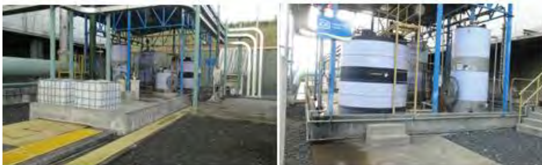
Figura 21. Sistema de soda con muros de contención de derrames, diciembre 2018.
