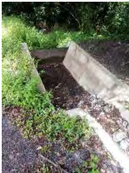
Figura 8. Sedimentador en el Proyecto Geotérmico Las Pailas Unidad II.
