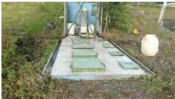
Figura 27. Vista de Tanque desgrasador. Diciembre, 2018.
