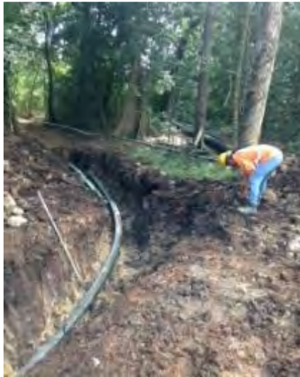
Figura 102. Excavación de canal entre el tanque ICE y tanque Curubandé, Proyecto Pailas II.
