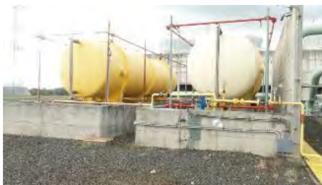
Figura 46. Tanques de pentano, pintura y sistema de aspersion en buen estado. Diciembre 2018.
