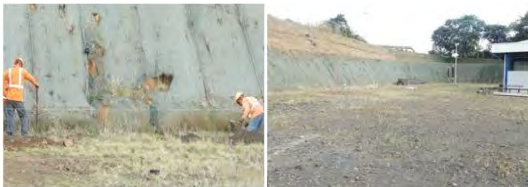
Figura 33. Taludes estabilizados con geo-membranas sintéticas en la Planta Geotérmica Pailas 1.
