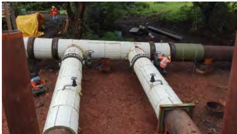
Figura 129. Conexiones para el soplado.
