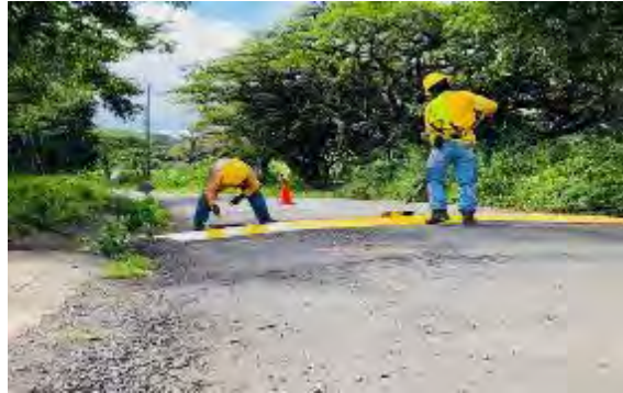
Figura 68. Mantenimiento de reductores de velocidad, noviembre 2018.
