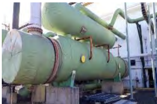
Figura 10. Recubrimientos térmicos de vaporizadores en buen estado. Diciembre, 2018.
