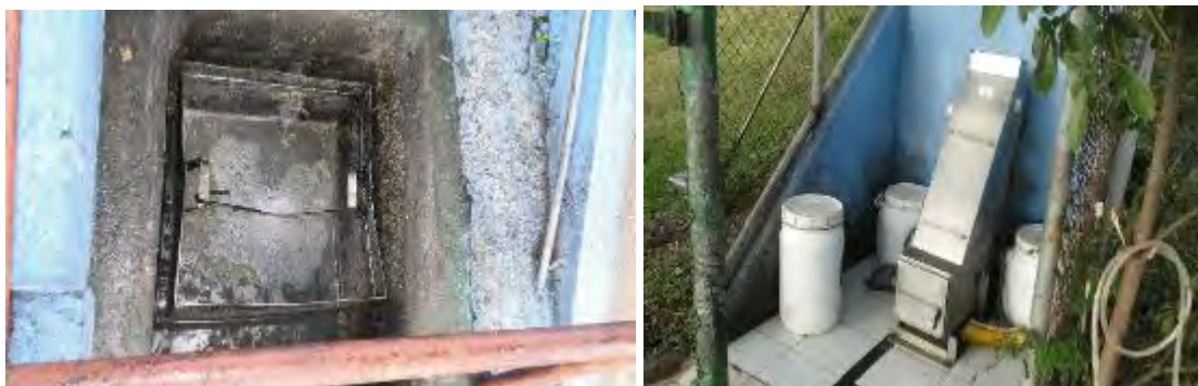
Figura 28. Vista del tamiz de gruesos del comedor. Diciembre, 2018.
