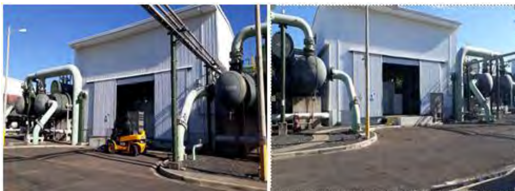
Figura 45. Aislamiento térmico y acústico de la caseta de turbina en buen estado. Las puertas están cerradas dado que la unidad esta parada por mantenimiento. Diciembre 2018.
