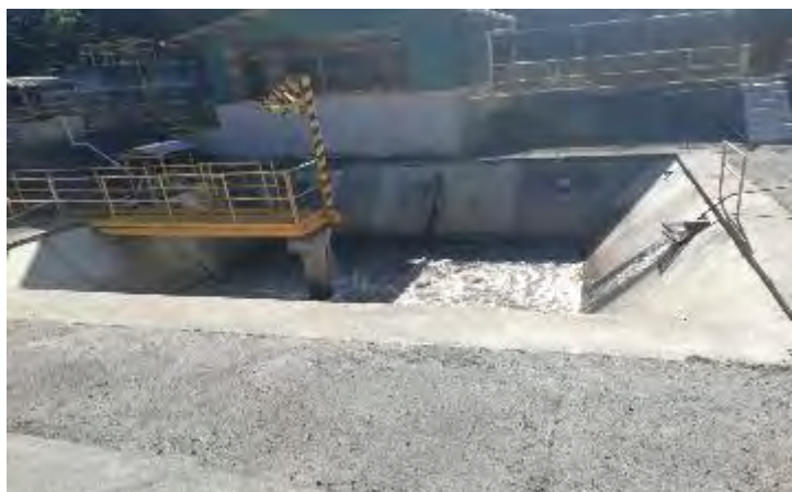
Figura 54. Vista de Tanque homogenizador, diciembre 2018.
