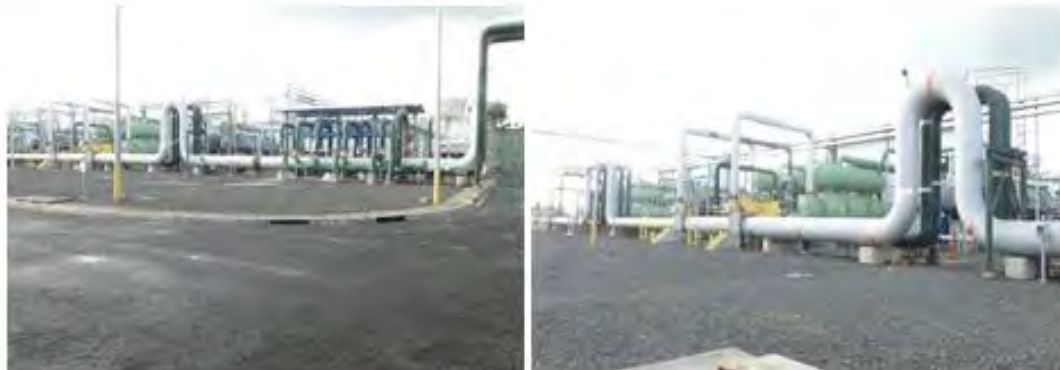
Figura 44. Estado de cubiertas aislantes. El aislamiento está en buen estado, diciembre 2018
