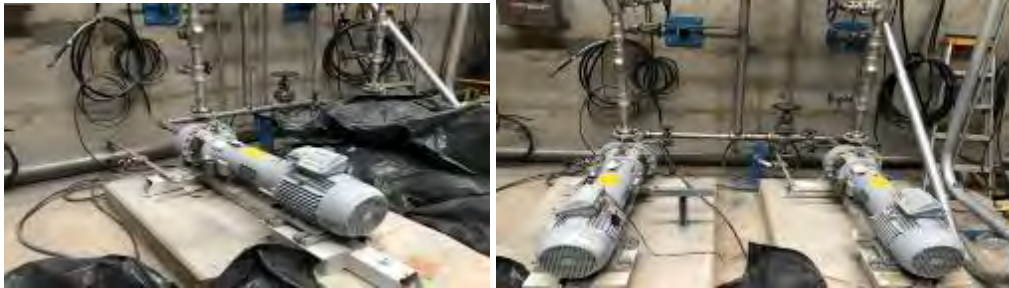
Figura 128. Instalación de tuberías de sistemas auxiliares.
