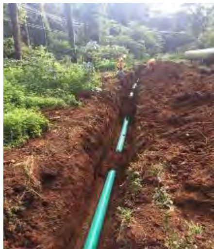
Figura 131. Tubería de conducción.
