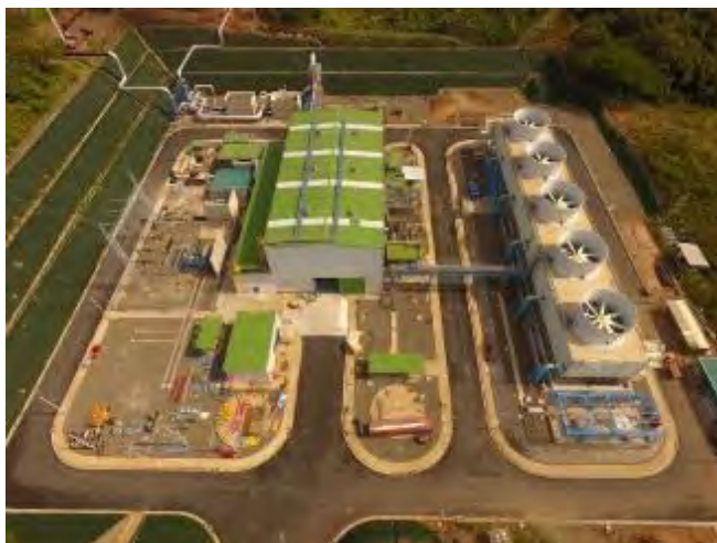
Figura 25. Taludes de la Casa de Máquinas II recubierto con geomanta.
