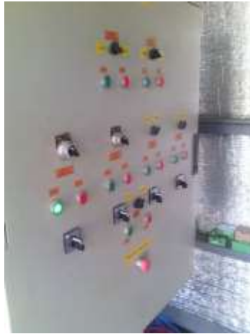
Mejoras al panel, con botoneras nuevas y luces nuevas.
