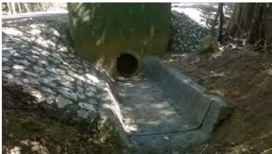
Figura 29. Disipador de energía del agua pluvial y prevista para reestructura de retención de sólidos.
