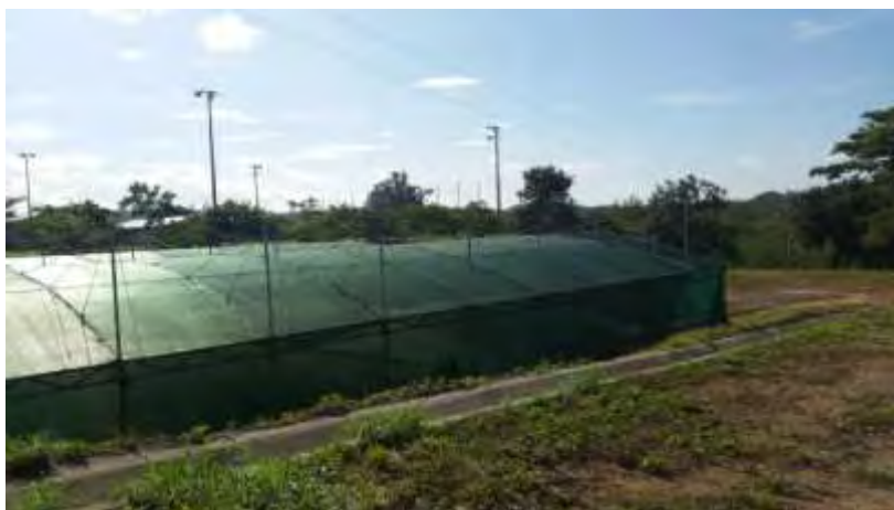
Figura 38. Reparación del sarán para proteger las bolsas del sistema de biodigestores.
