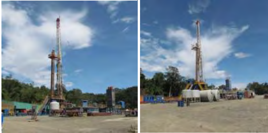
Figura 9. Vistas panorámicas de plataformas en perforación PLP-14 y PLP-16.
