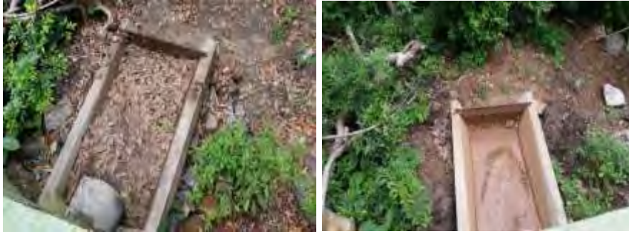
Figura 68. Ejemplo de mantenimiento de sedimentadores realizado.
