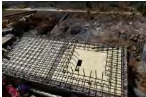
Figura 69. Construcción de trampa de grasas y aceites para aguas residuales del Taller Mecánico.
