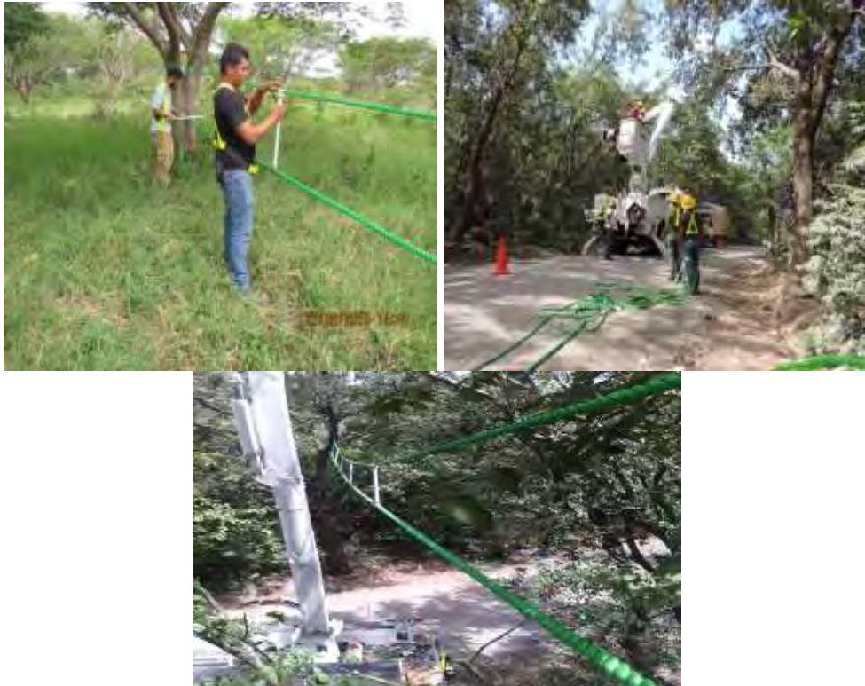
Figura 104. Construcción e instalación de pasos aéreos para fauna arborícola.
