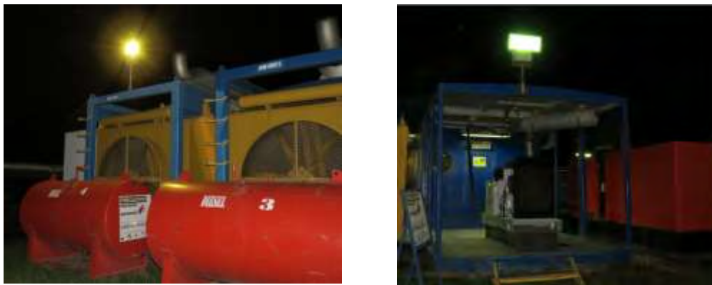
Figura 113. Luminarias LED instaladas en zonas de tránsito en perforadora National.
