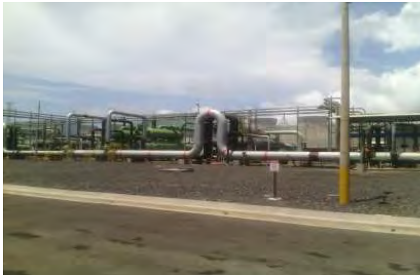
Vista general de lado.
