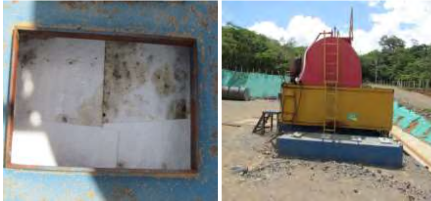
Figura 5. Uso de toallas absorbentes en trampas para aguas oleaginosas en PLP-14.
