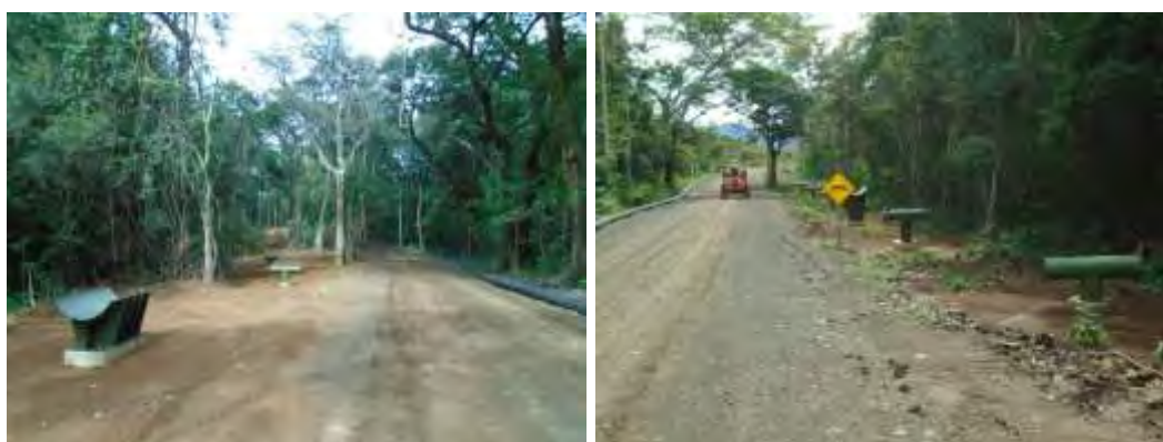
Figura 44. Trabajos de preparación de pedestales en las rutas de tuberías están muy avanzados.
