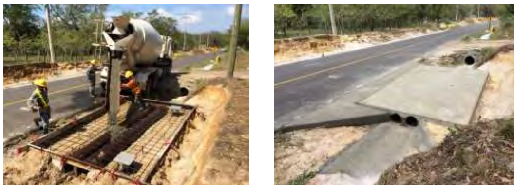
Figura 142. 05 de setiembre de 2015. Trabajos parada de bus. y 08 de setiembre de 2015 losa de concreto para de bus.
