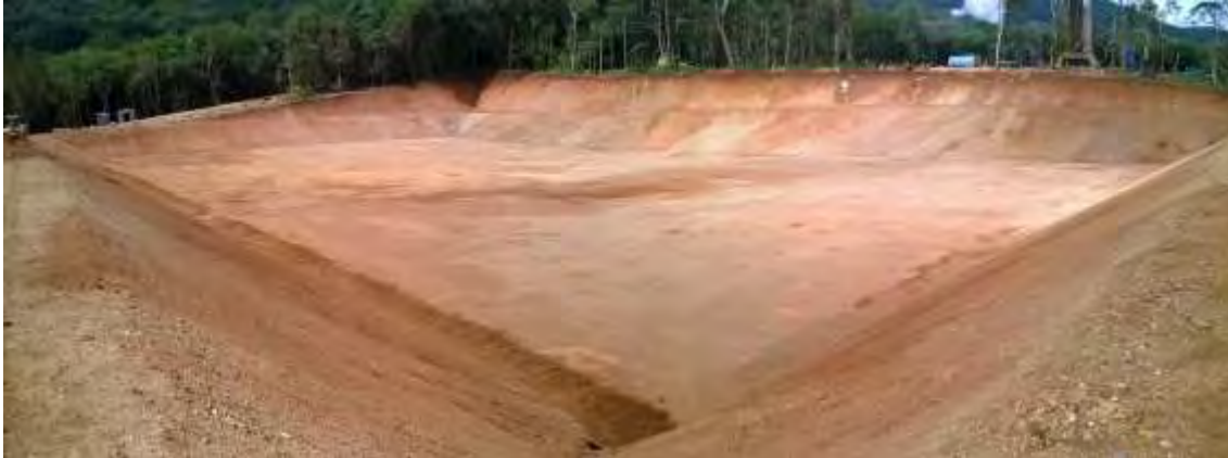
Figura 156. Excavación terminada de la Laguna 3.
