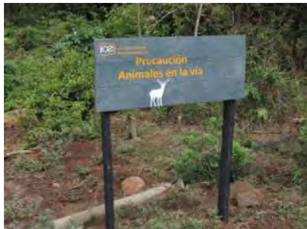
Figura 105. Colocación de rótulos preventivos sobre la presencia de fauna en la vía.
