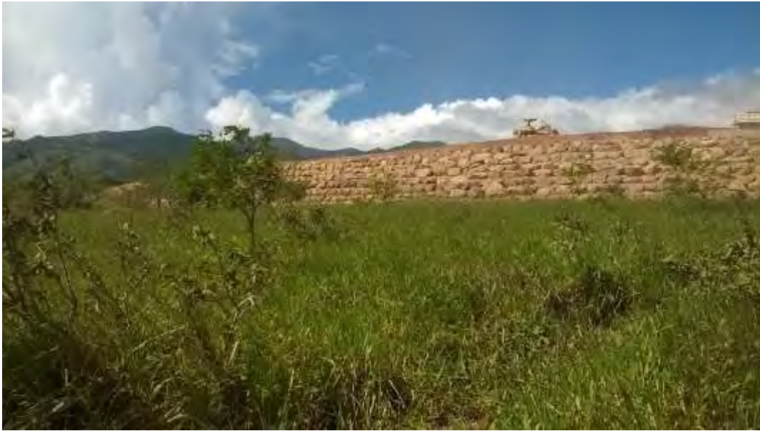
Figura 158. Construcción Dique y conformación de la escombrera I.
