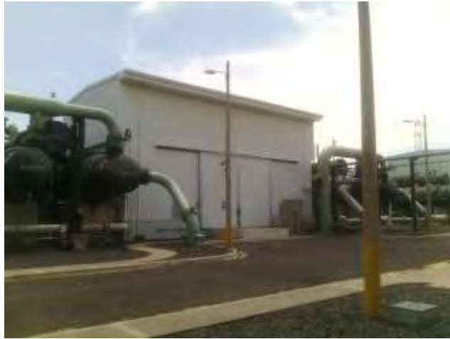
Aislamiento térmico y acústico de la caseta de turbina, 28 de setiembre.
