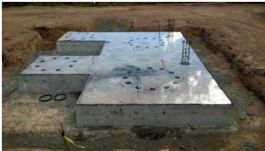
Figura 155. Cimiento del Separador Ciclónico y Tanque de Agua de la Estación Separadora 2
