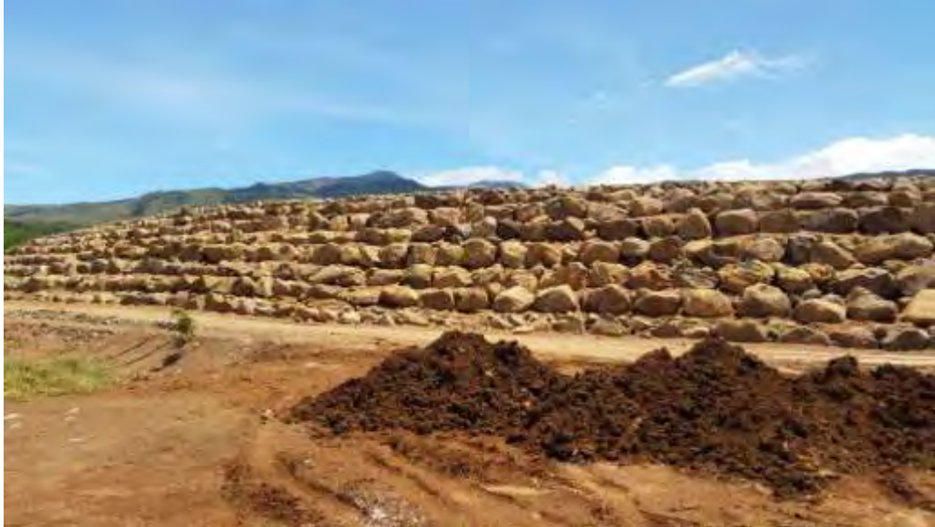
Figura 121. Dique de retención de la Escombrera Pailas I.
