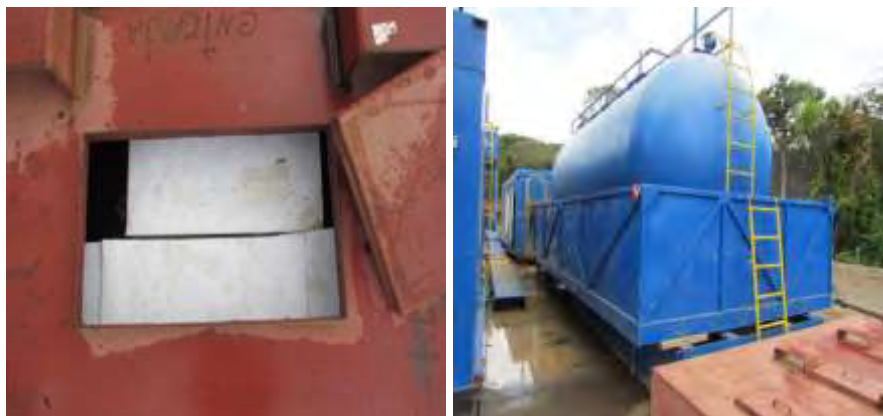
Figura 6. Uso de toallas absorbentes en trampas para aguas oleaginosas en PLP-16.
