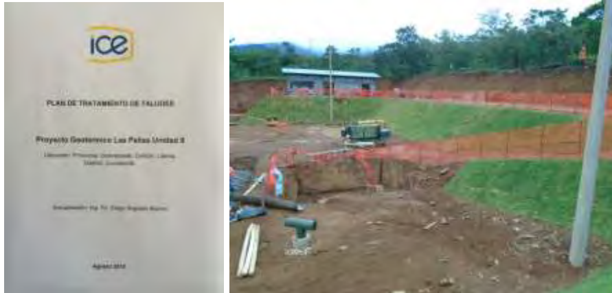
Figura 45. El plan de tratamiento de taludes; e instalación puntual de cospes de zacate San Agustín en el satélite N° 2.
