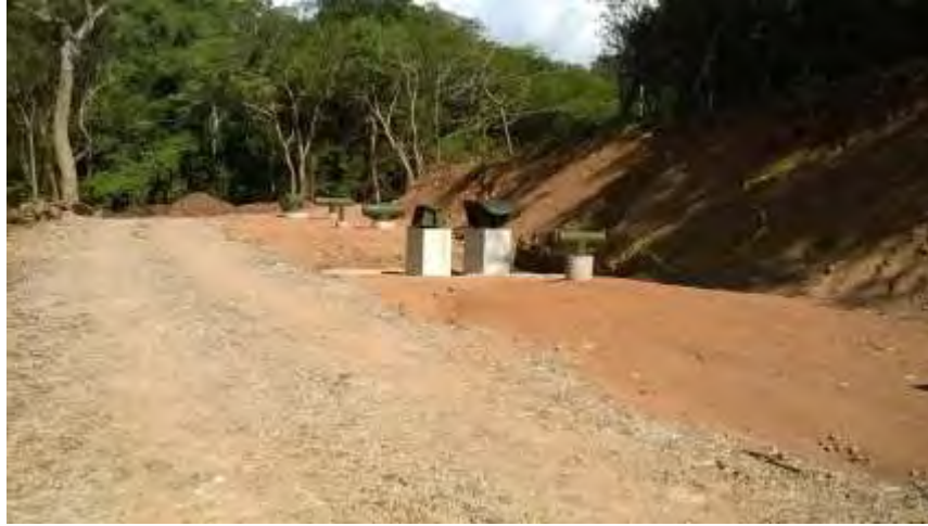
Figura 149. Cimientos Ruta A (AS2-PL14).
