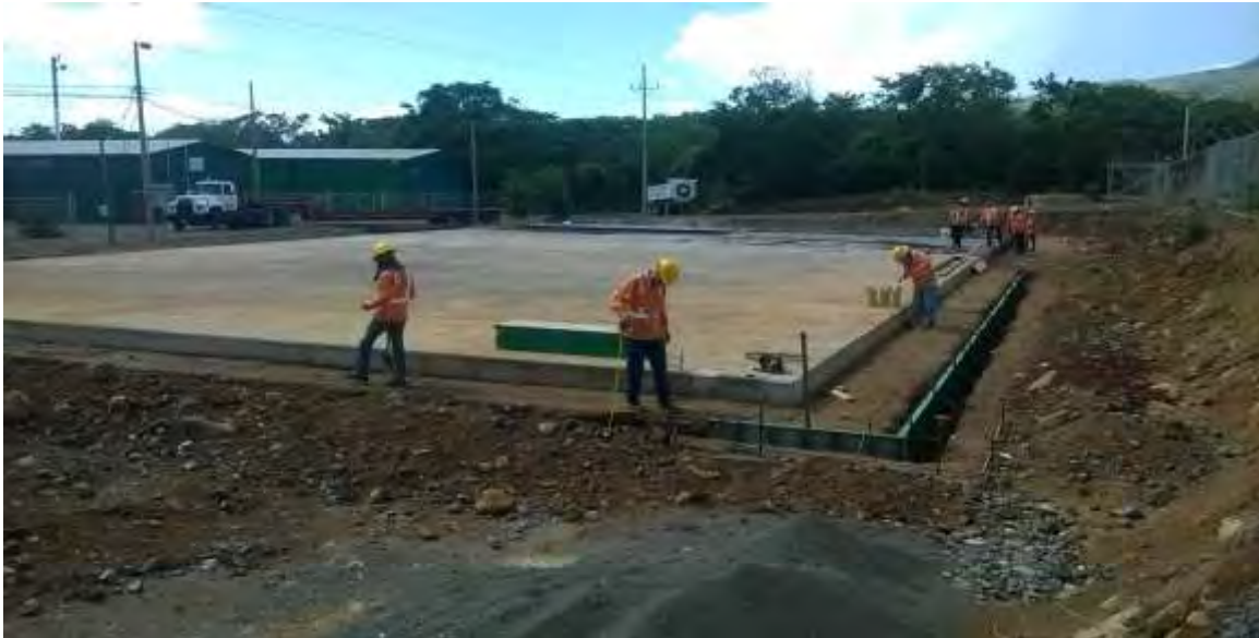
Figura 160. Construcción de Bodega de 1000m 2 para CSRG.
