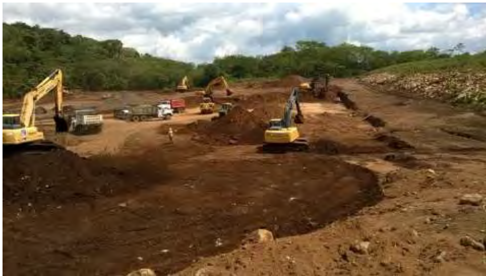
Figura 157. Trabajos de excavación en la Laguna 2.
