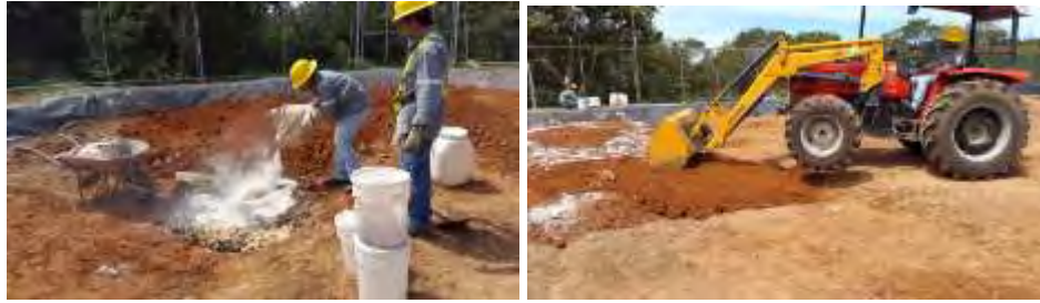
Figura 36. Cobertura de residuos vertidos en Relleno Sanitario.
