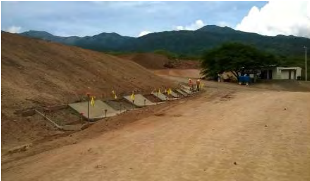
Figura 159. Construcción de cunetas en la escombrera Pailas I.
