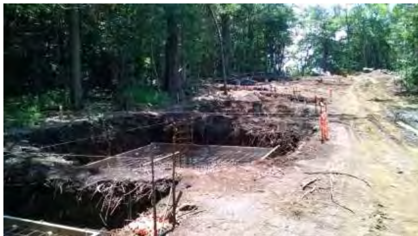
Figura 151. Armado de cimientos de la Ruta A (AS2-PL15).
