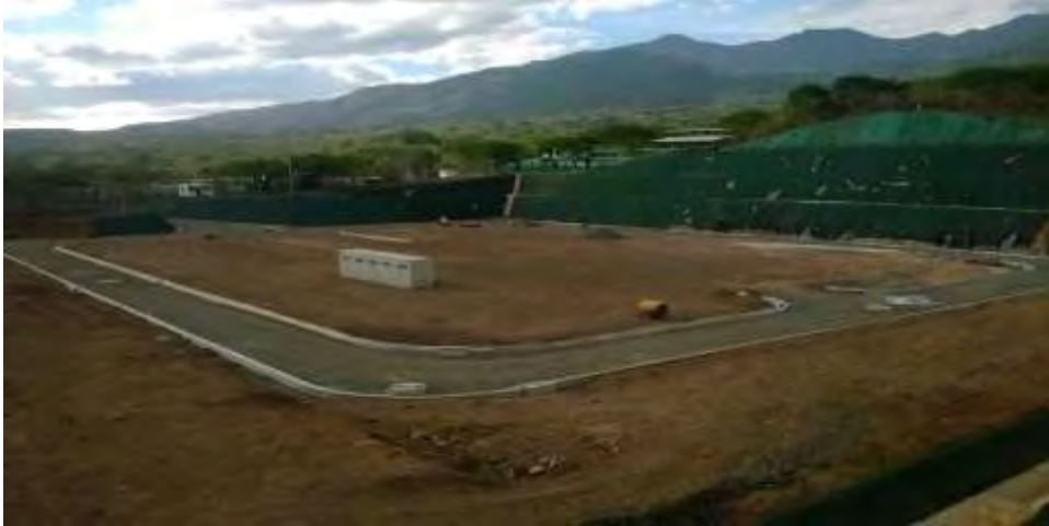
Figura 147. Explanada de Casa de Máquinas con obras de infraestructura completadas.
