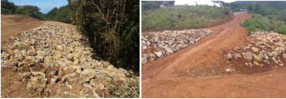
Figura 123. Trabajos de conformación de la escombrera de la plazoleta 13.
