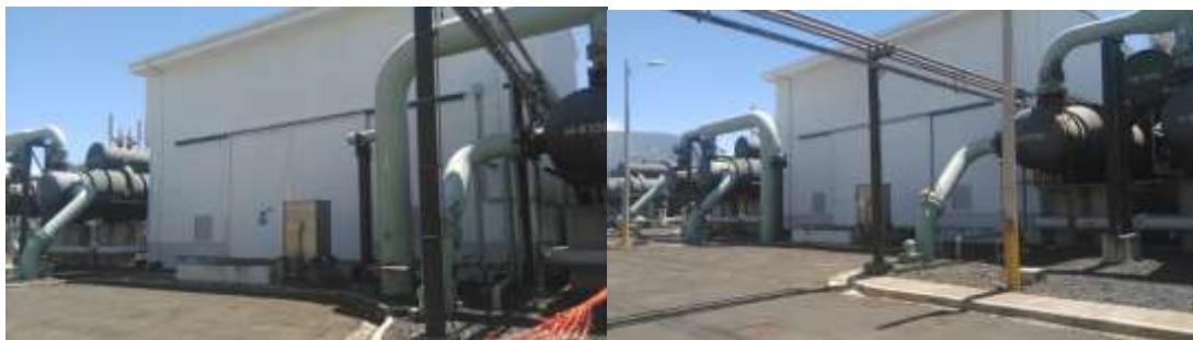
Figura 36 Aislamiento térmico y acústico de la caseta de turbina está en buen estado.
