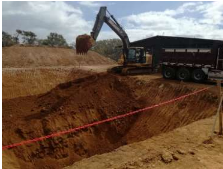
Figura 102. Ampliación del Relleno Sanitario del Proyecto Geotérmico Pailas.
