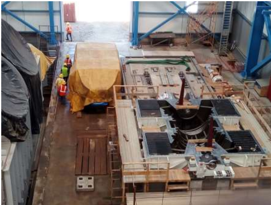
Figura 133. Instalación de la turbina.
