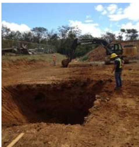
Figura 110. Excavación de fosa impermeabilizada para residuos en el Centro de acopio.
