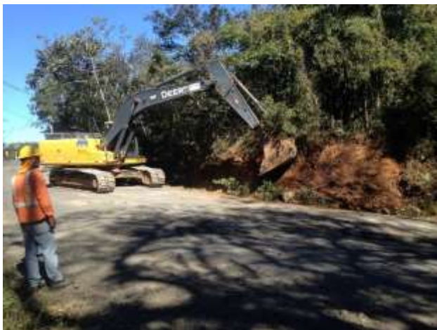
Figura 109. Camino de acceso al Proyecto Pailas II
