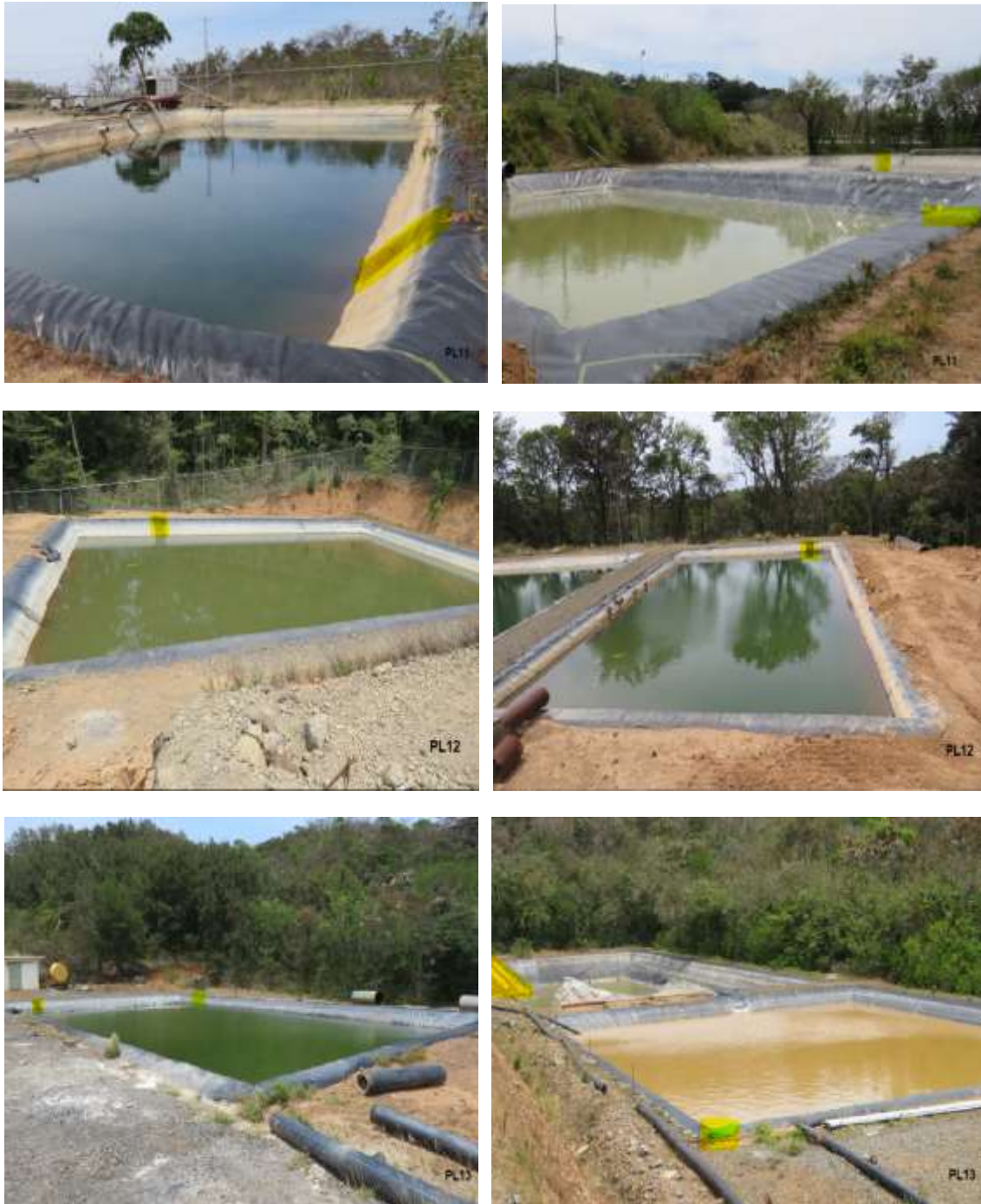
Figura 22. Dispositivos para escape de fauna en plazoletas de perforación.
