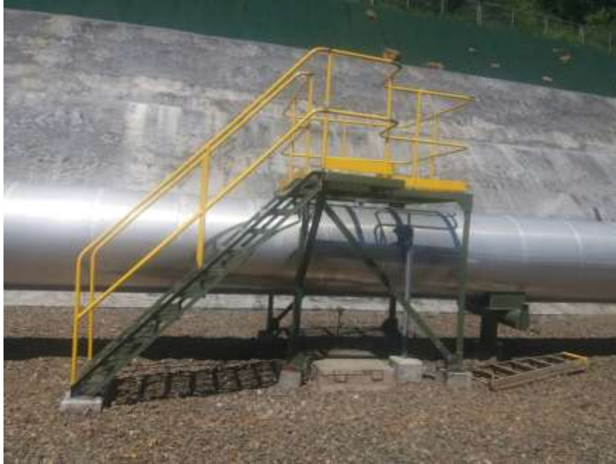
Figura 138. Montaje de andamios.
