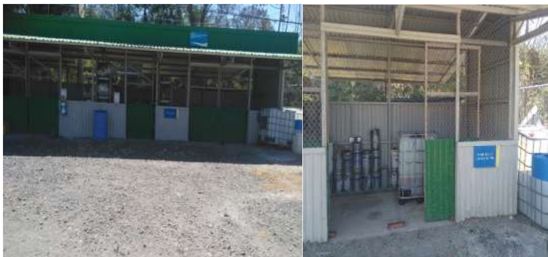
Figura 17. Vista frontal del centro de acopio de la planta.
