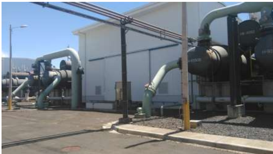
Figura 10. Casa de máquinas con las puertas cerradas,
