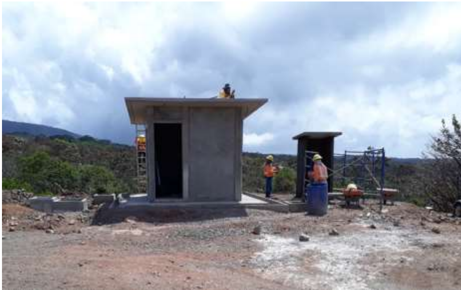
Figura 135. Construcción de Casetas en PL-13
