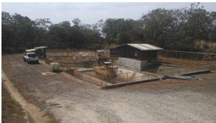
Figura 23. Vista general de planta de tratamiento.
