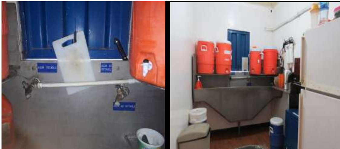
Figura 18. Sitios rotulados para agua potable y no potable
