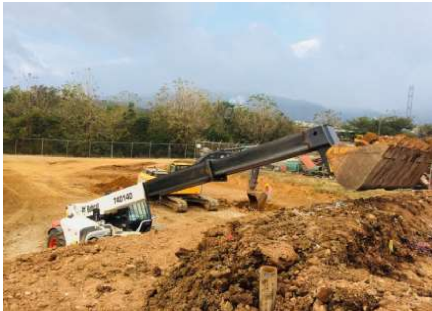
Figura 101. Cobertura de residuos orgánicos en relleno sanitario.
