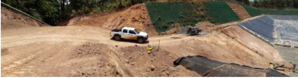
Figura 139. Trabajos en Laguna 03
