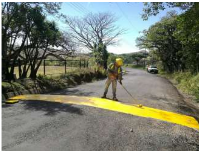
Figura 74. Mantenimiento de reductor de velocidad.
