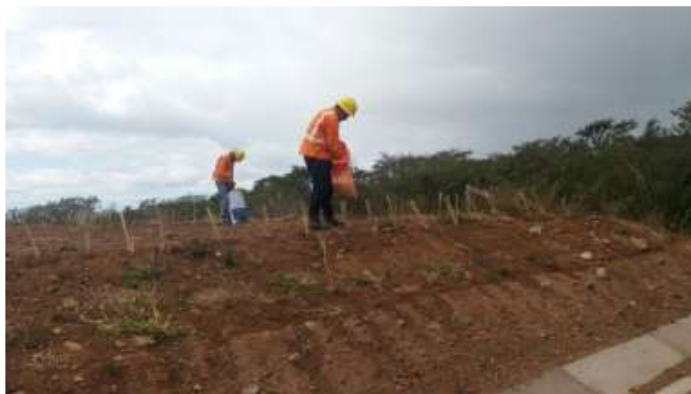
Figura 21. Aplicación de abono orgánico.
