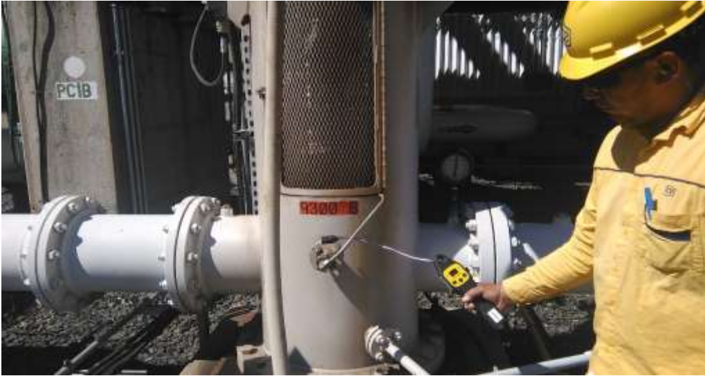
Figura 9. Medición de fugas de pentano
