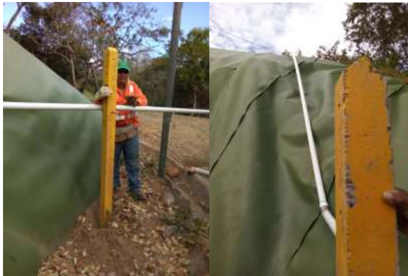
Figura 32. Instalación de tubería para la reutilización de aguas residuales en el Campamento Curubandé.
