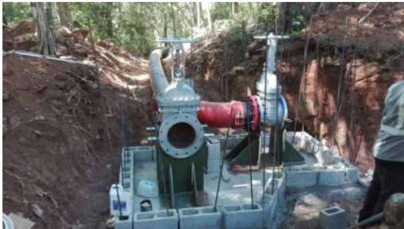
Figura 140. Montaje de válvulas
