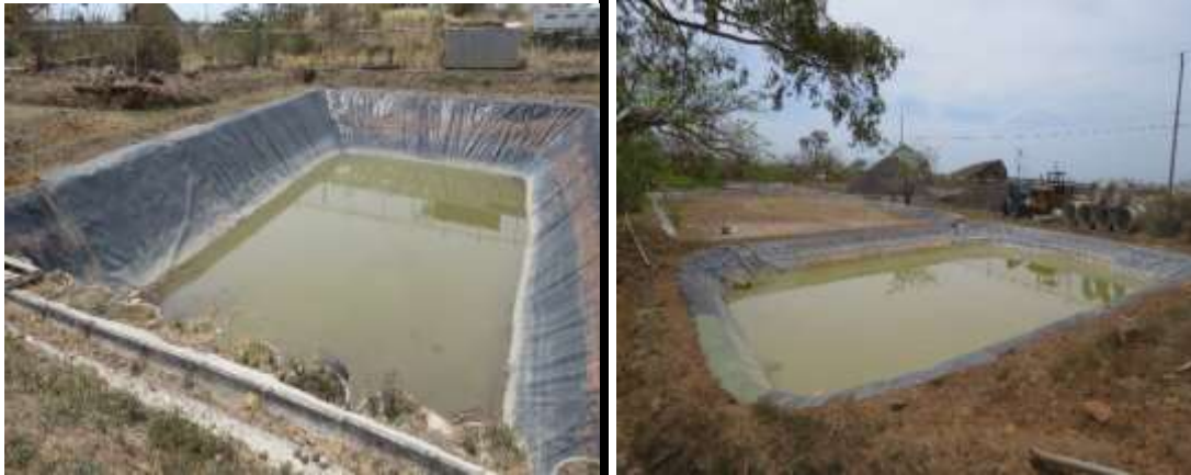
Figura 16. Lagunas almacenamiento de fluidos geotérmicos y de perforación en PLP-01
