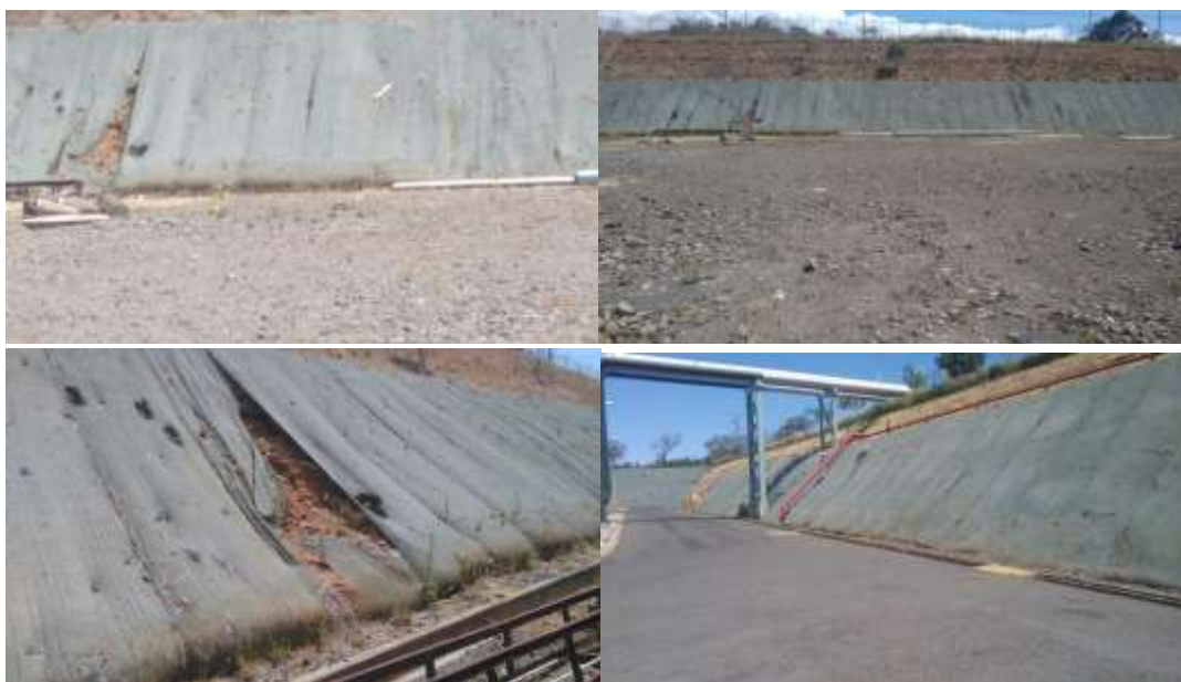
Figura 28. Taludes estabilizados con geo-membranas sintéticas en la Planta Geotérmica Pailas 1.
