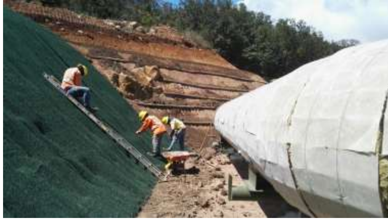
Figura 43. Recubrimiento del talud con geo membrana.
