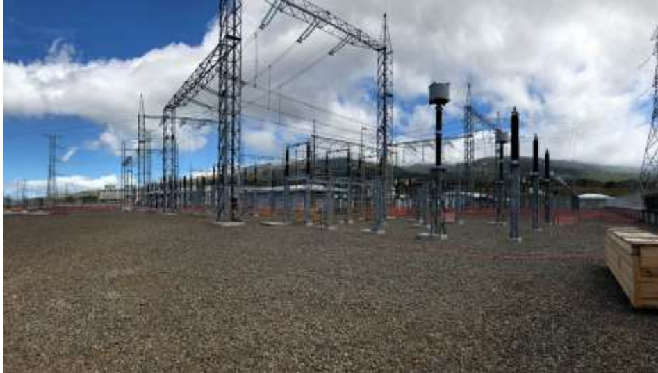
Figura 141. Avances en subestación.
