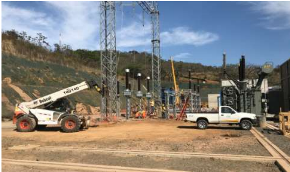
Figura 142. Avance en Patio de subestación planta
