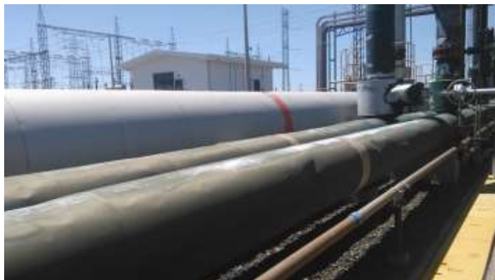
Figura 31. Vista del sistema de drenajes en buen estado.
