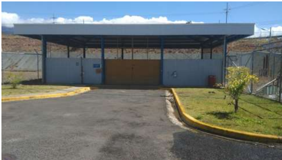
Figura 1. Vista exterior de la bodega de inflamables en su parte frontal y posterior.
