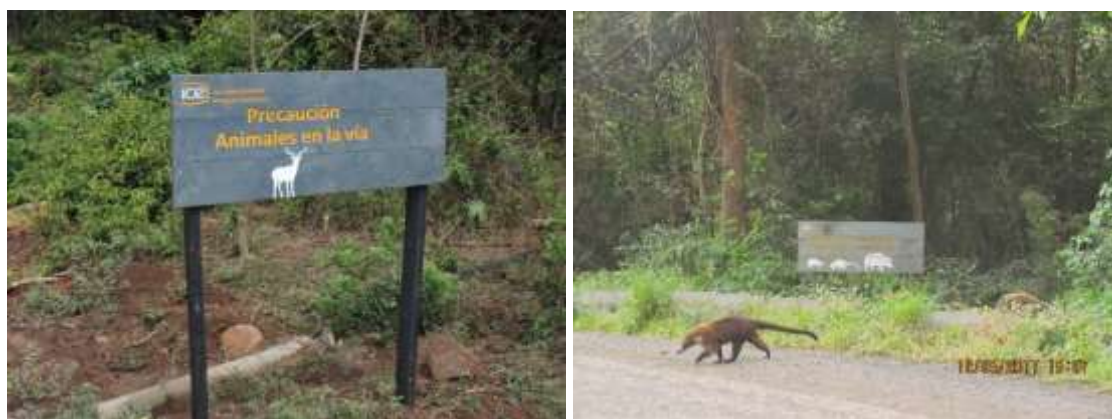
Figura 94. Colocación de rótulos preventivos sobre la presencia de fauna en la vía.
