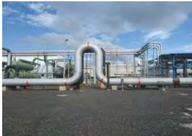
Tuberías recubiertas con forros aislantes térmicos en buen estado
