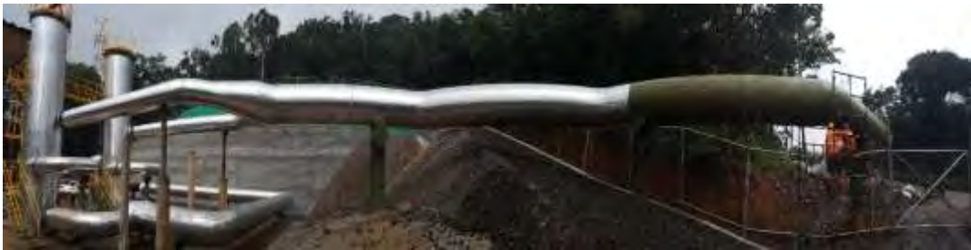
Figura 137 Aislamiento ruta F(PL-13/FS4) Bifásico entrando a la ES-04.
