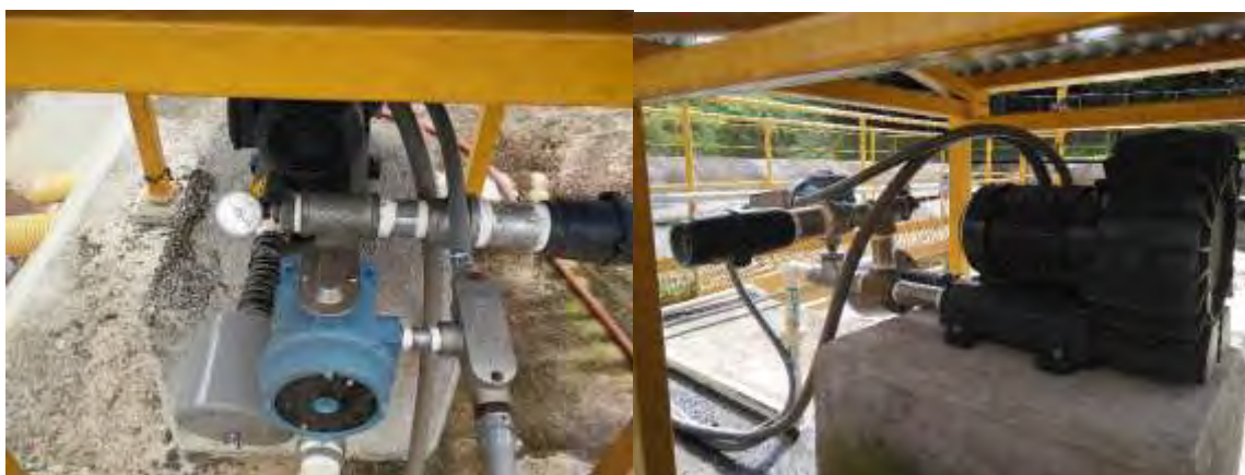
Colocación del aireador reparado del tanque de homogenización Diciembre
