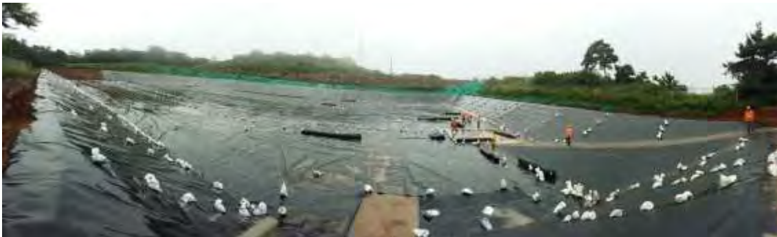
Figura 143 Impermeabilización de la Laguna 2.
