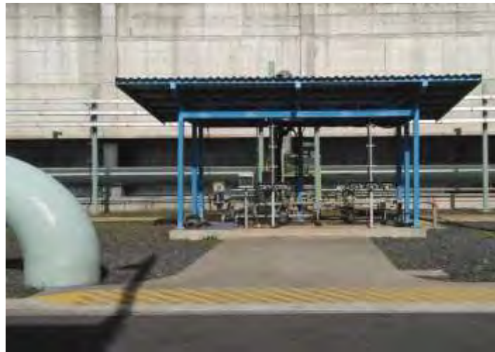
Sistema de recolección y neutralización de drenajes de condensados, en buen estado
