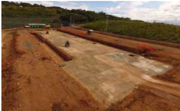
Figura 129 Excavación de la cimentación de la Torre de Enfriamiento y colocado de sello.
