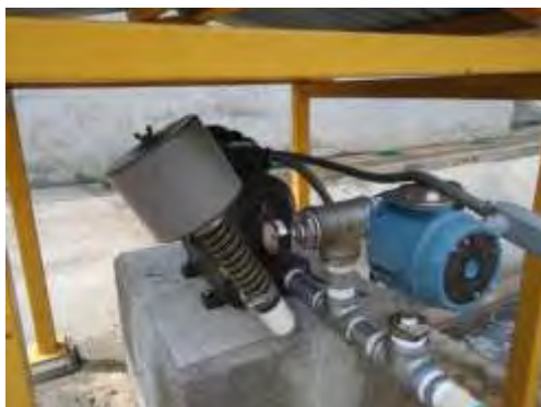
Aireador de reactor biológico funcionando correctamente
