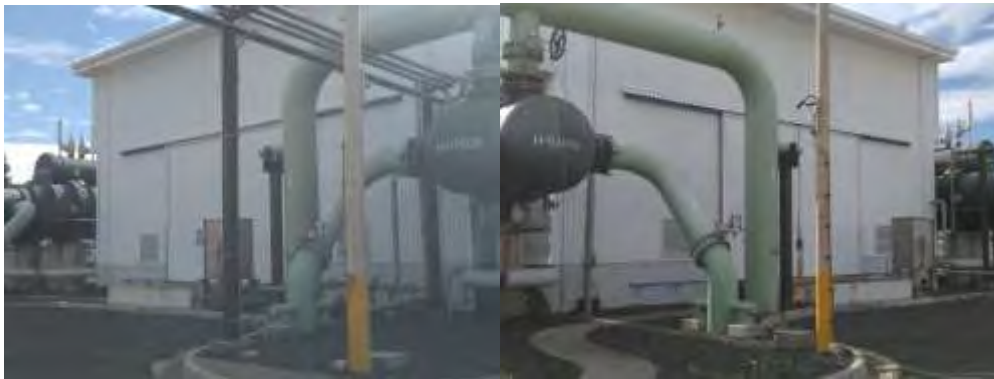
Aislamiento térmico y acústico de la caseta de turbina Diciembre
