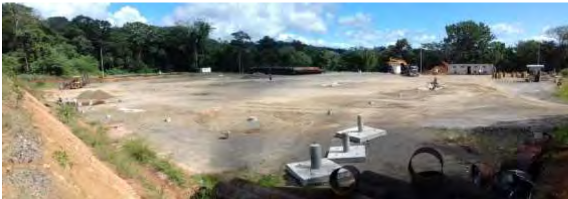
Figura 132. Colocado de cimientos en la Plazoleta 15.
