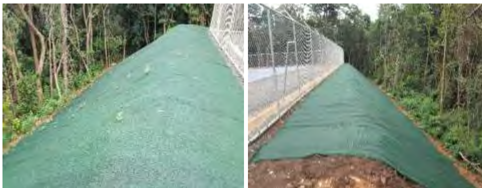
Figura 43 Taludes recubiertos con geo-membrana en la laguna de enfriamiento 4.
