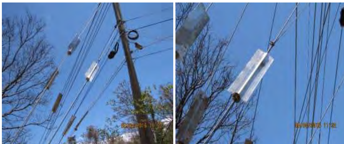
Figura 95. Láminas antiescalamiento colocadas en LD.
