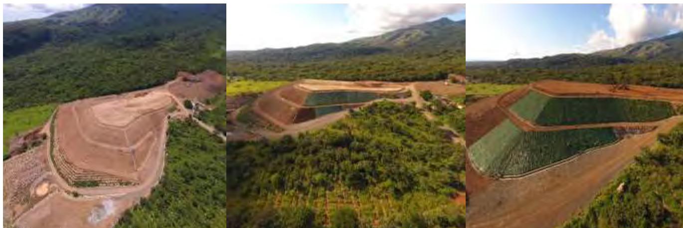
Figura 103. Avance en el recubrimiento de taludes de la escombrera 1.
