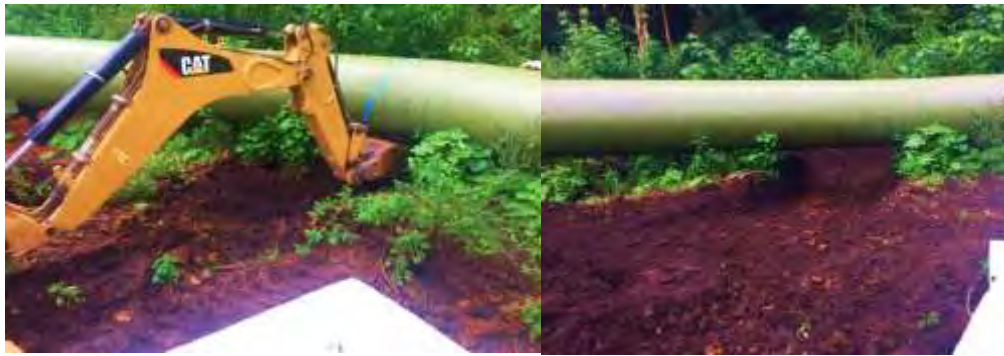
Figura 149. Zanjas para paso de animales por debajo de las tuberías.
