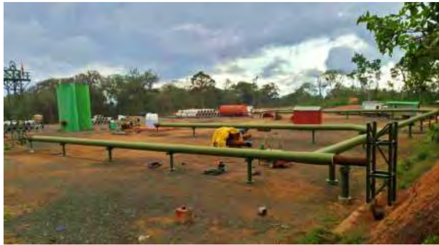
Figura 131 Montaje de tuberías y colocación de aislamiento en la Plazoleta 16.
