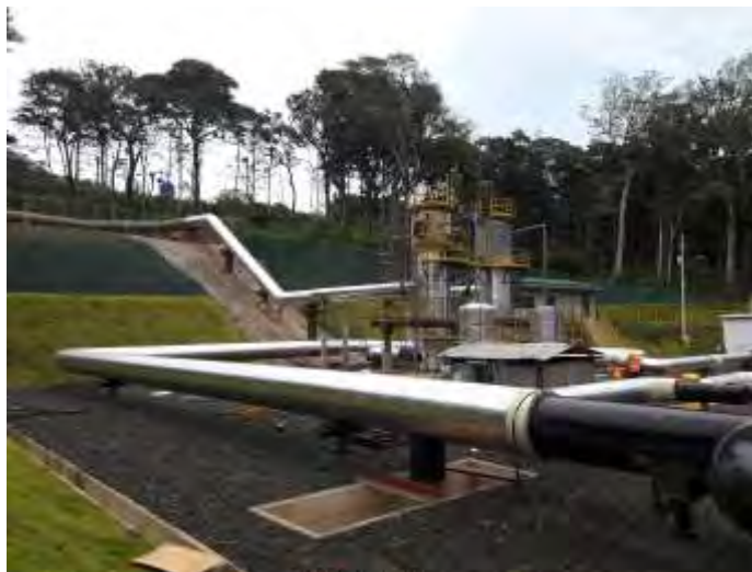
Figura 136 Sección PL12-FS3 (bifásico), con aislamiento hasta la entrada de ES-03.
