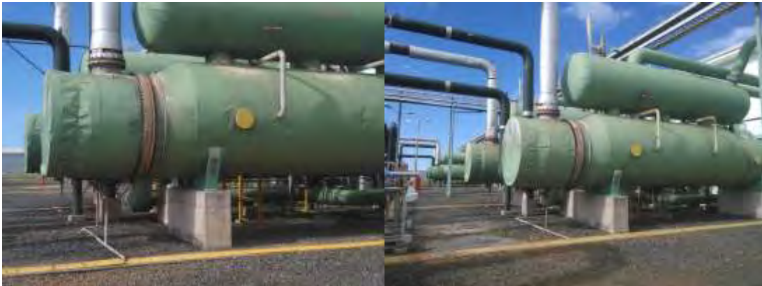
Precalentadores y vaporizadores con cubiertas aislantes en buen estado.
