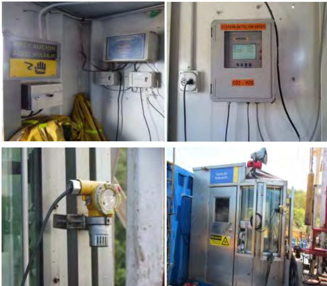
Figura 15: Detectores fijos con sistema de alarmas audibles de H 2 S y CO 2 .
