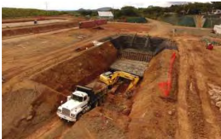
Figura 128. Excavación de la cimentación del turbo-generador.
