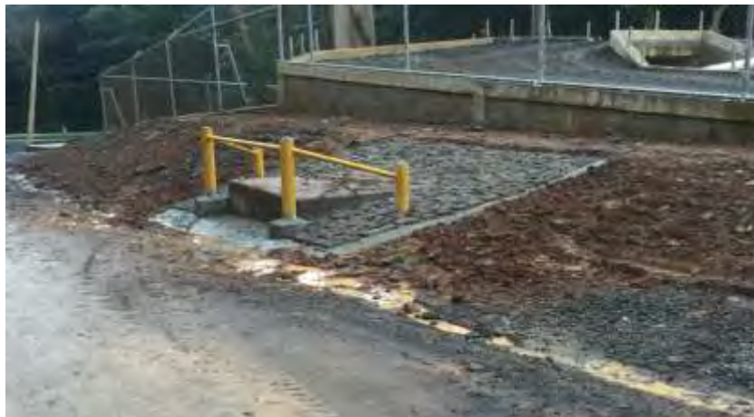
Figura 145. Protección de cajas de registro.
