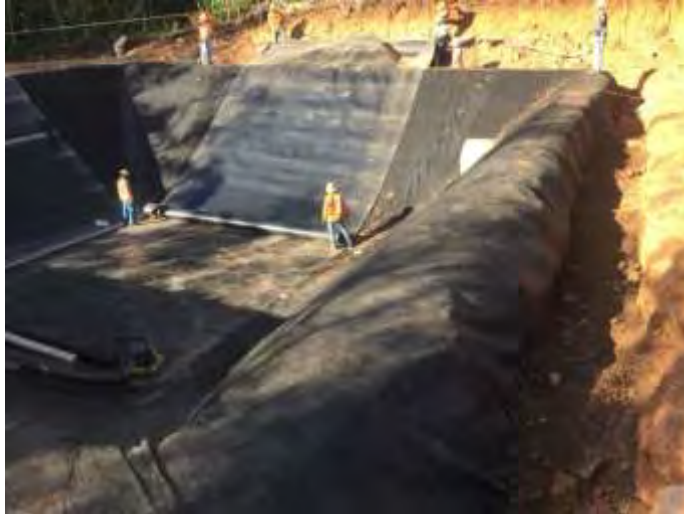
Figura 156. Impermeabilización fosa de bypass Laguna de Enfriamiento N°4.
