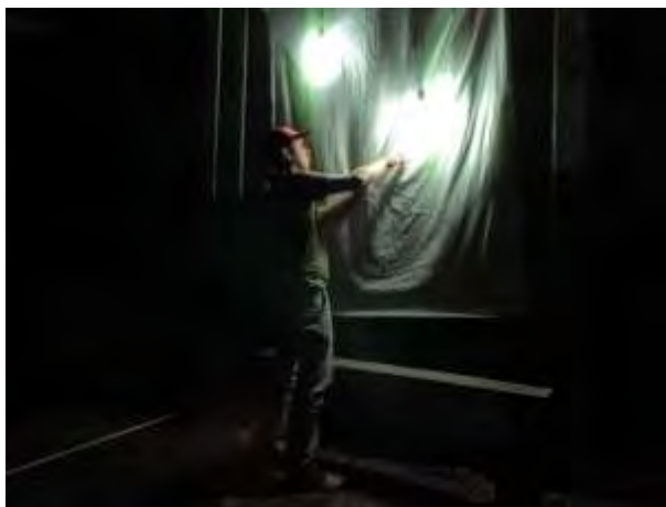
Figura 113. Sistema de luces instalada en los alrededores de la Casa de Máquinas. Enero 2017.
