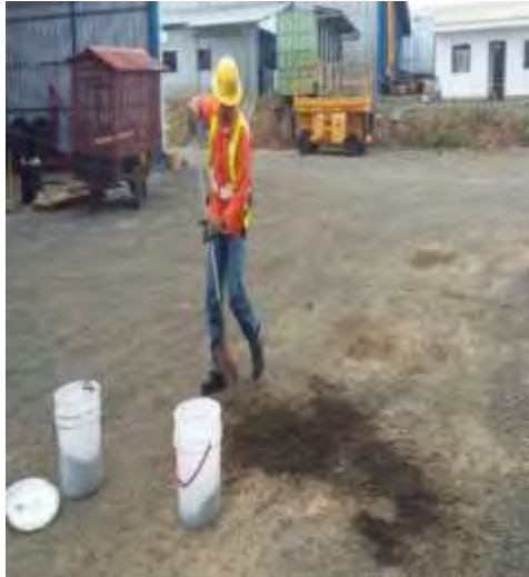
Figura 41. Atención de derrame ocurrido en el Patio del Taller Mecánico.
