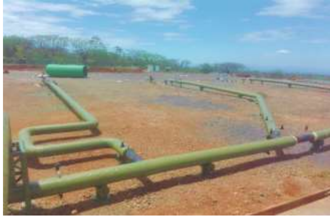
Figura 149 Montaje de tubería PL-14.
