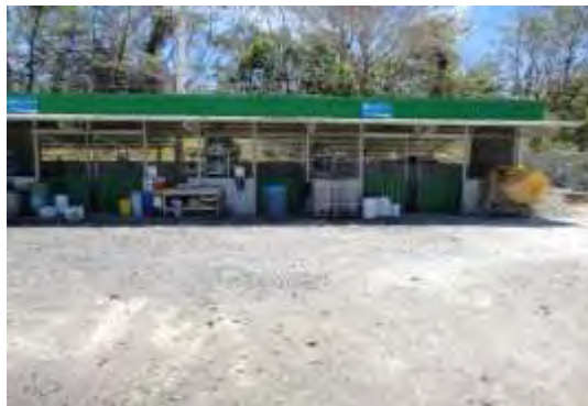
Figura 9. Centro de acopio de residuos.
