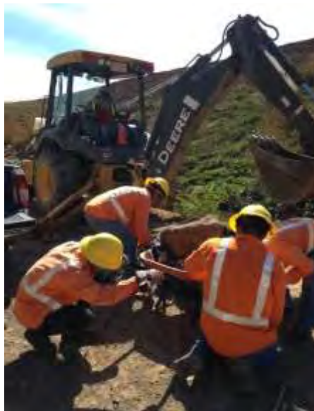
Figura 120. Traslado de petroglifo a la Planta Geotérmica Pailas I.
