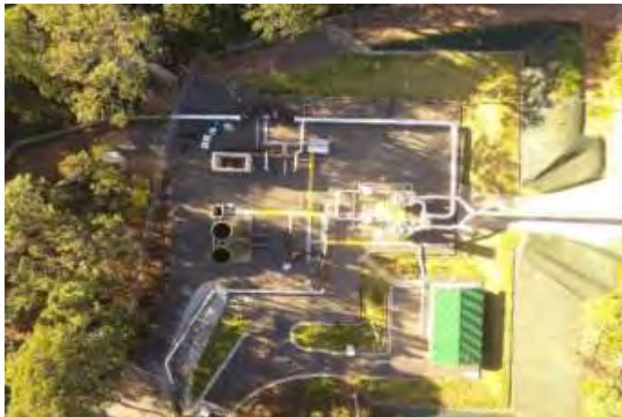
Figura 153. Estación Separadora N°3.
