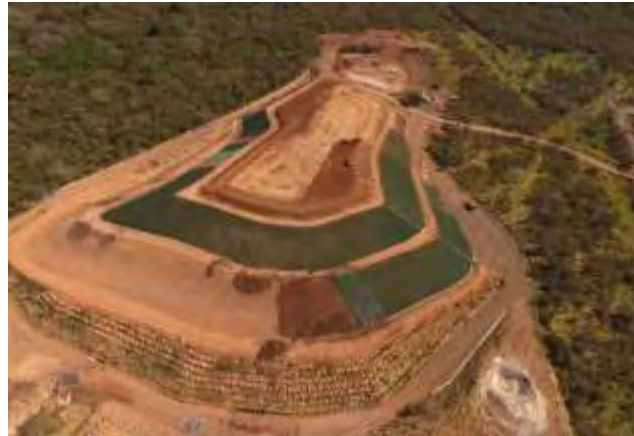
Figura 122. Taludes recubiertos con Geo-manta en la escombrera 1.
