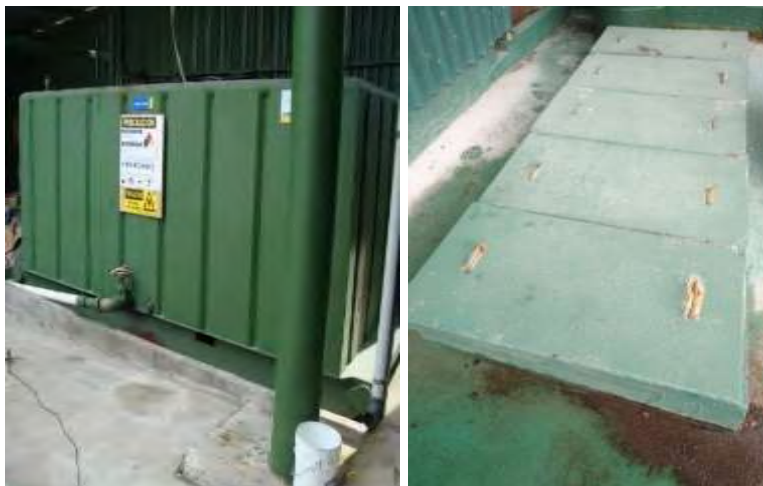
Figura 39. Trampas para aguas oleaginosas.
