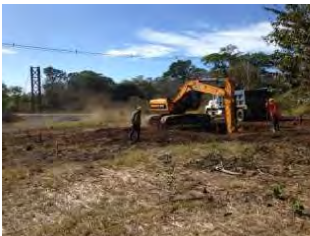
Figura 121. Movimientos de tierra en la torre 3 de la línea de transmisión
