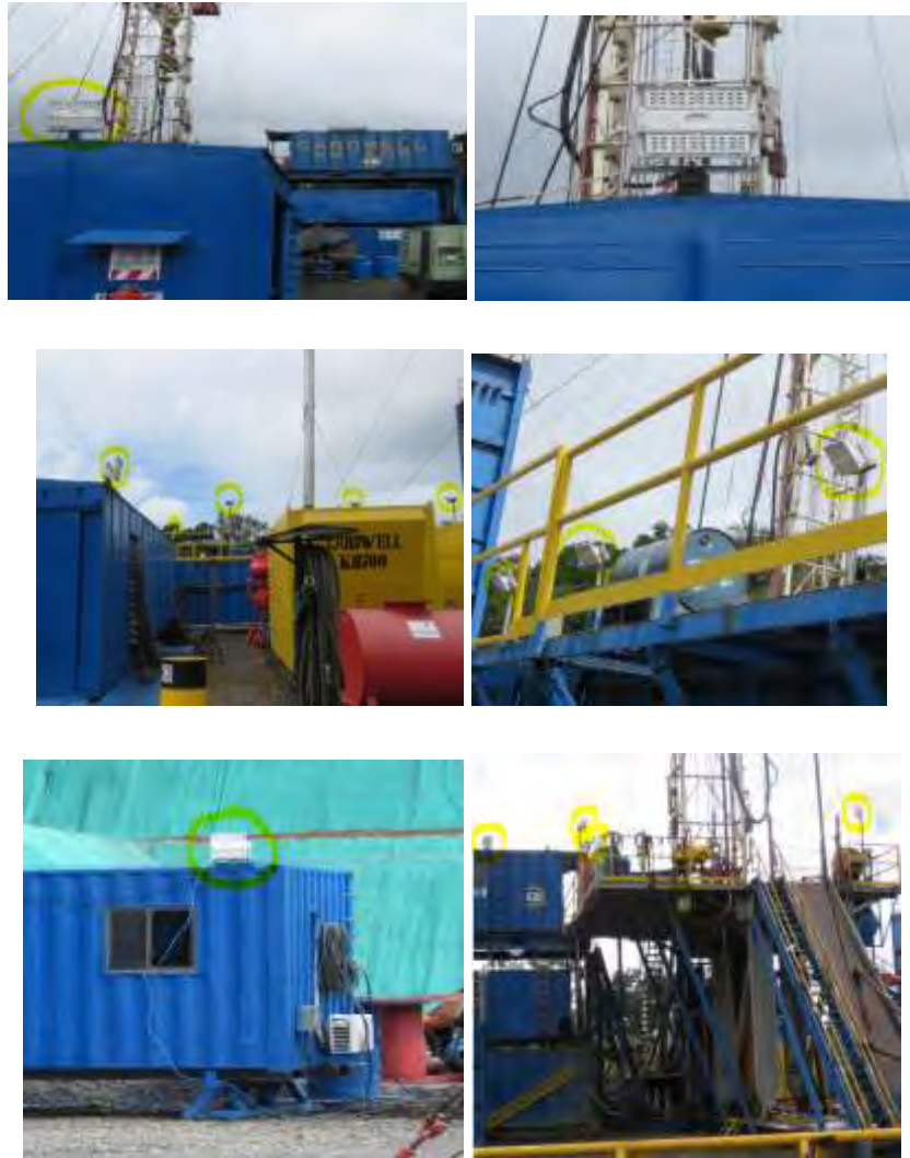
Figura 115: Luminarias LED en perforadora Cardwel.
