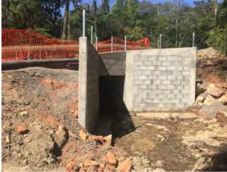
Figura 160. Paso subterráneo de fauna en la quebrada El Yugo.
