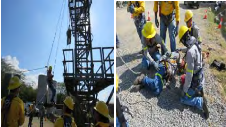
Figura 134. Trabajo en altura en equipos de perforación.
