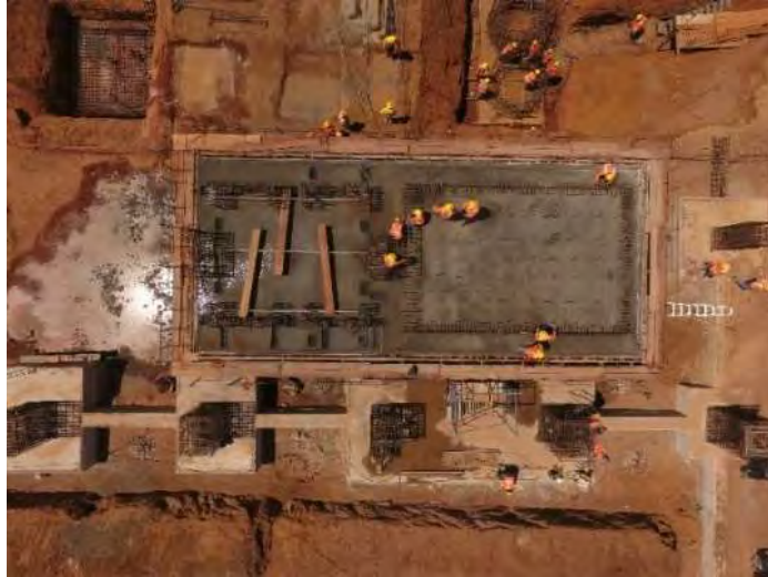
Figura 145. Avance en la cimentación del Turbogenerador.
