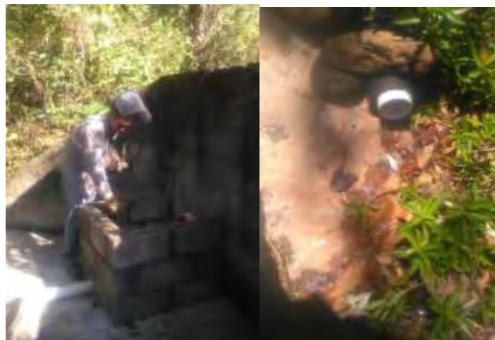
Figura 35. Implementación de mejoras recomendadas en el STAR del Campamento.
