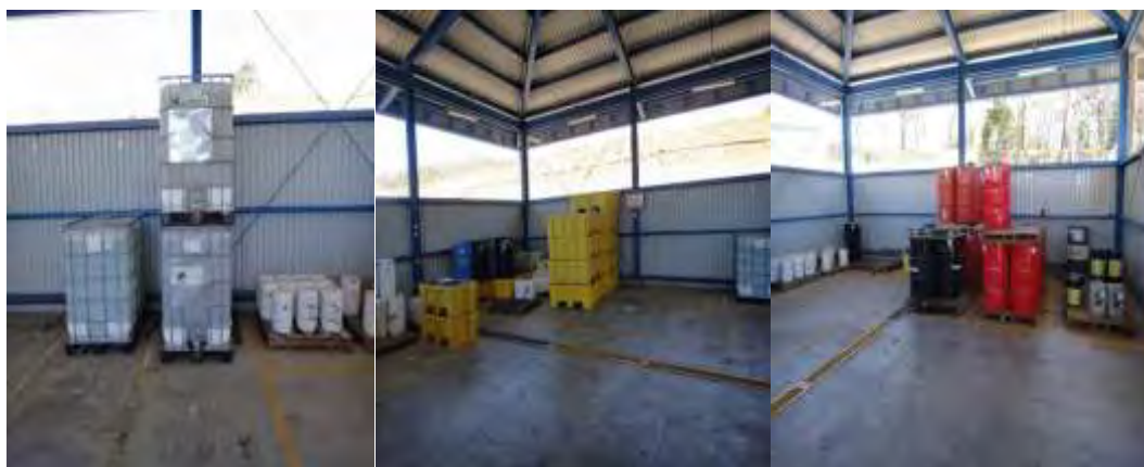
Figura 3. Vista interior de la de la bodega de sustancias inflamables.
