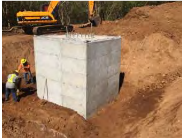
Figura 162. Cimentación de la torre N°05. Línea de Transmisión PG Pailas II.
