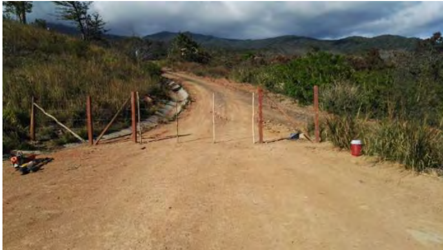
Figura 124. Cerca construida en la escombrera de la PL-13.
