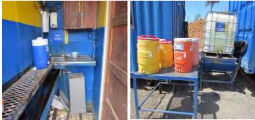
Figura 22. Sitios rotulados para agua potable y no potable.
