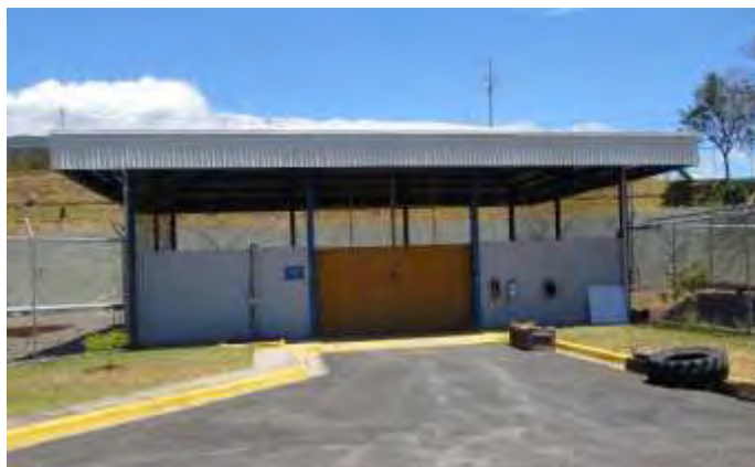
Figura 1. Vista exterior de la bodega de inflamables.
