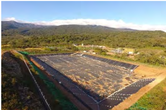
Figura 157 Impermeabilización de la Laguna de Enfriamiento N° 2.
