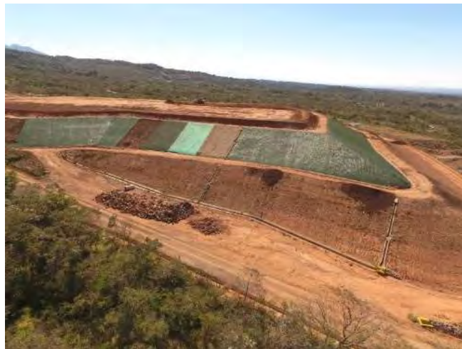
Figura 161. Escombrera 1 del PG Pailas II.
