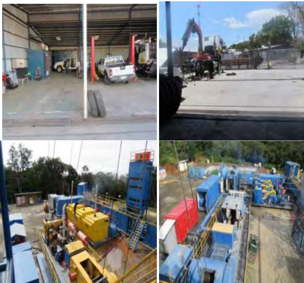
Figura 8: Maquinaria, vehículos y equipos de perforación Cardwell y Kpem
