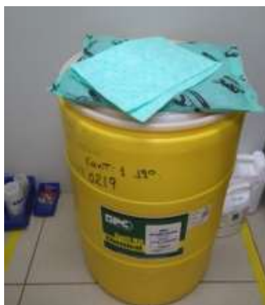
Figura 12. Kit de control de derrames del área química.
