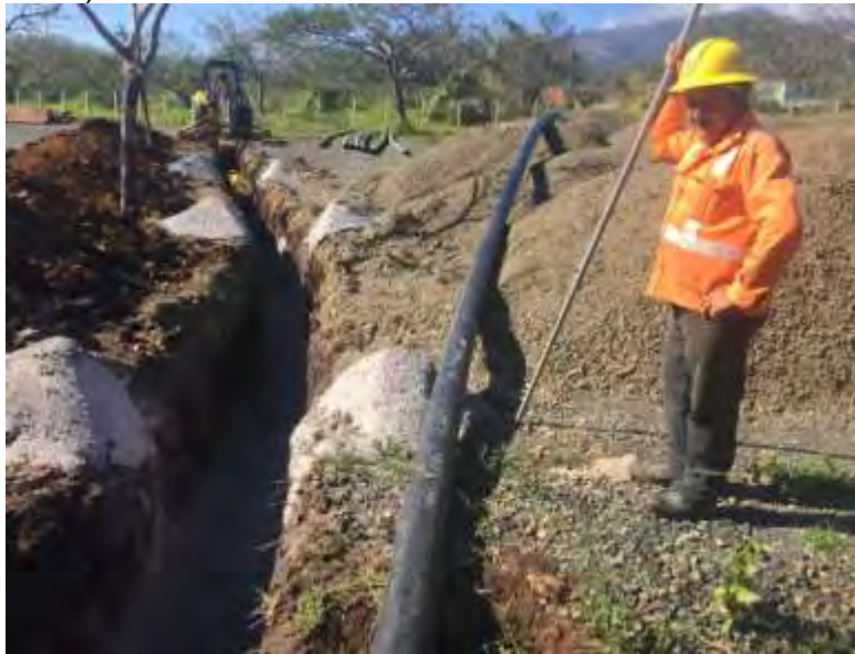
Figura 159. Construcción de tubería de sobreflujo.
