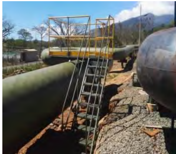
Figura 150. Andamio Ruta Satélite 2- Unión.
