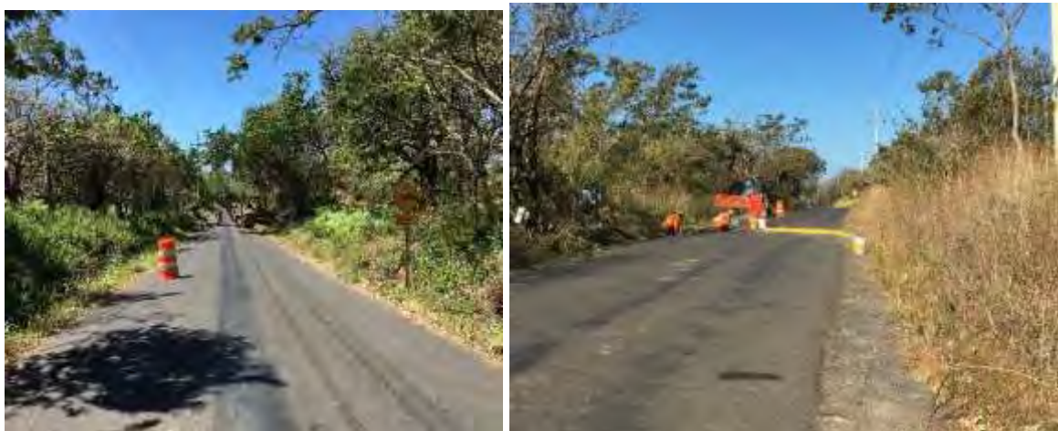
Figura 142. Construcción de reductores de velocidad, ruta de acceso Proyecto.
