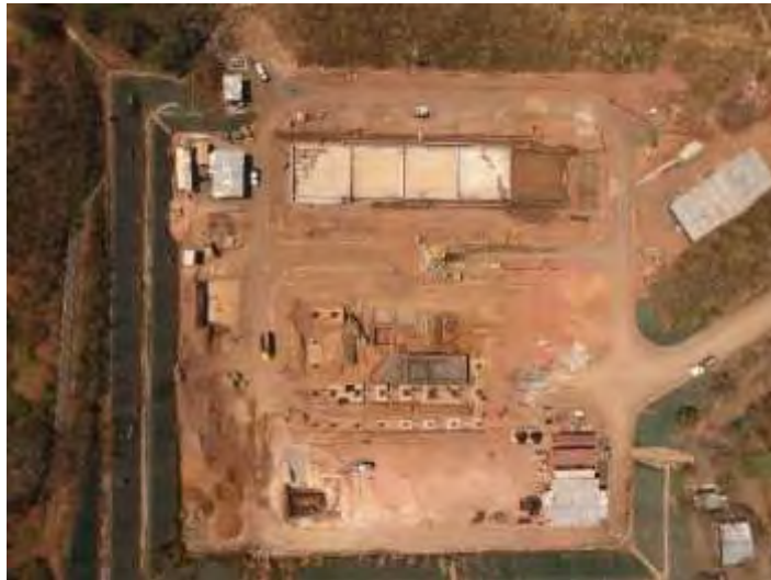
Figura 146. Avances de trabajos en el sitio de Casa de Máquinas.
