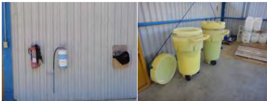
Figura 2. Extintores y equipo de control de derrames.
