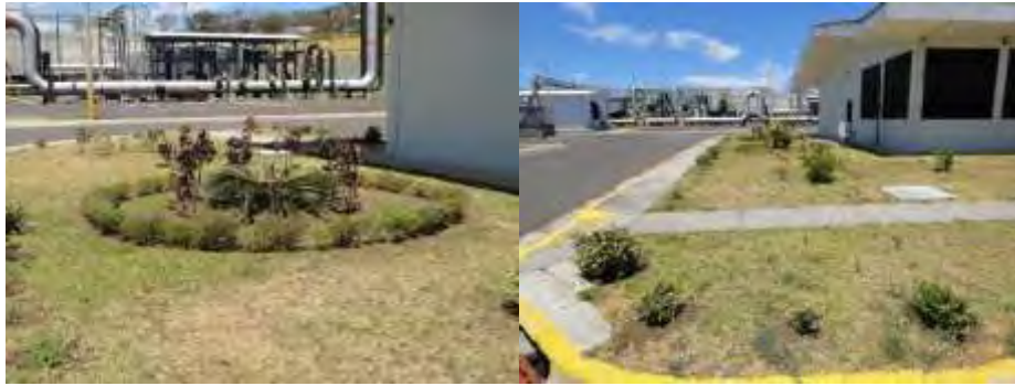
Figura 23. Zonas verdes ubicadas en los alrededores de la Planta Geotérmica Pailas 1.
