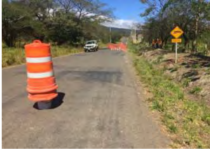
Figura 164. Construcción de reductor de velocidad en camino de acceso al PG Pailas II.
