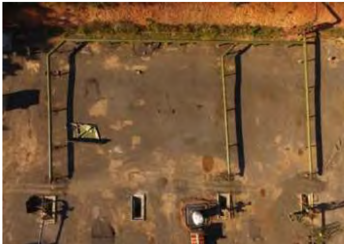
Figura 147. Tuberías de la PL-16.
