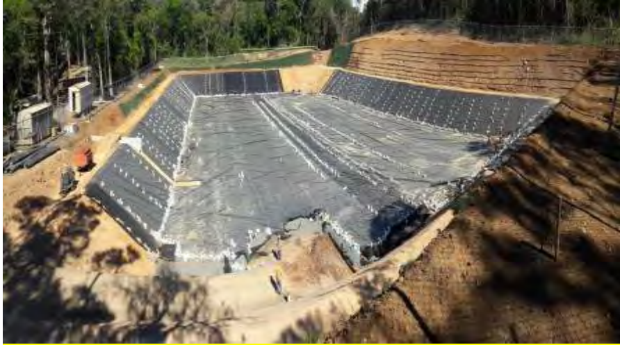
Figura 158. Avances en impermeabilización de la Laguna de Enfriamiento N° 3.
