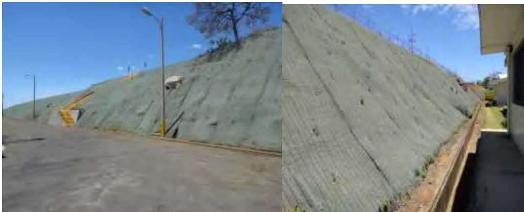
Figura 22. Taludes estabilizados con geo-membranas sintéticas en la Planta Geotérmica Pailas 1.
