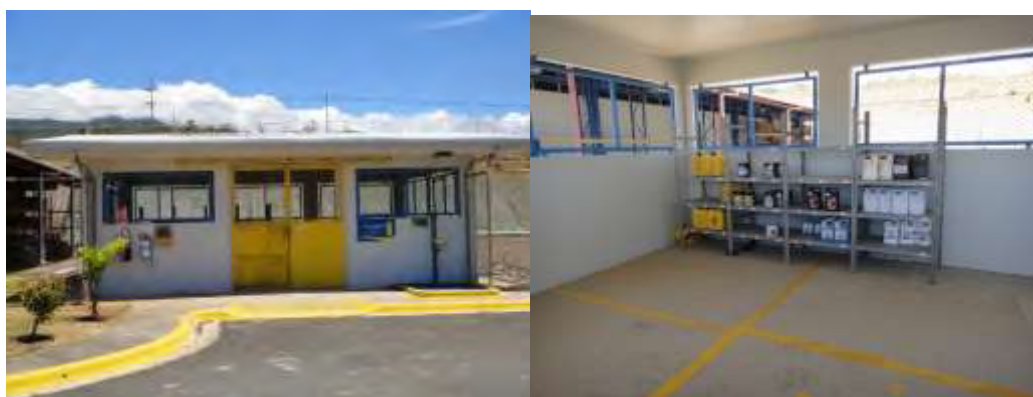
Figura 4. Vista del exterior e interior de la bodega de químicos.
