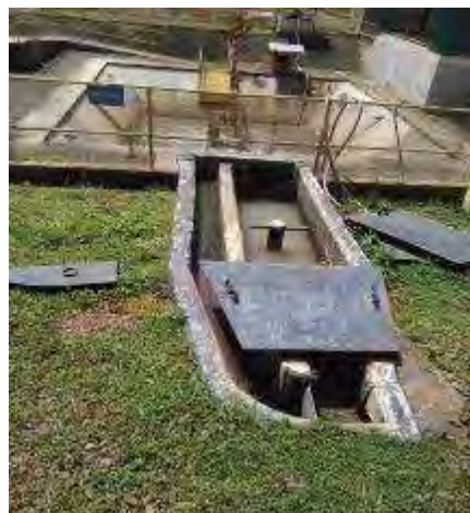
Figura 33. Entrada del agua al homogenizador. Esta se limpia diariamente de sólidos gruesos. Septiembre, 2018.
