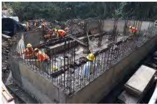
Figura 145. Construcción de toma de agua.
