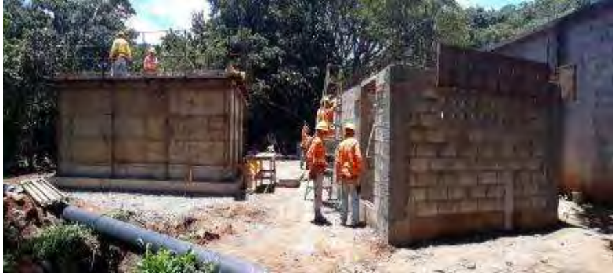
Figura 144. Construcción de caseta y tanque ICE.
