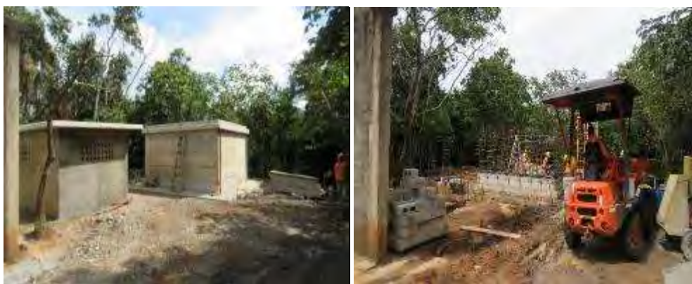
Figura 112. Trabajos tanque de almacenamiento ICE, III trimestre 2018.
