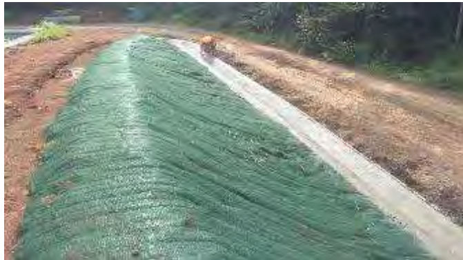
Figura 143. Construcción de cunetas y mejoramiento de taludes.
