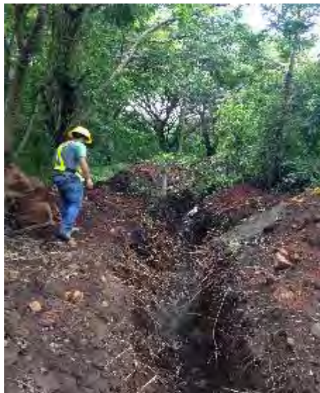
Figura 105. Excavación de canal para tubería del Acueducto Curubandé, PG Pailas II.
