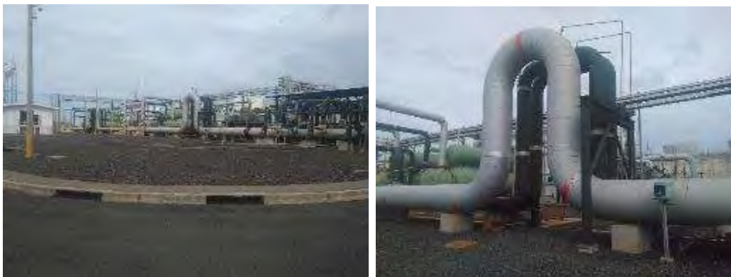
Figura 55. Estado de cubiertas aislantes. El aislamiento está en buen estado, agosto 2018
