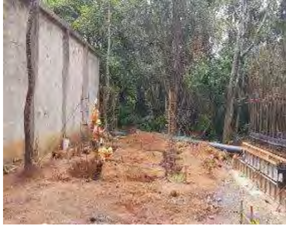
Figura 113. Trabajos caseta ICE, III trimestre 2018.
