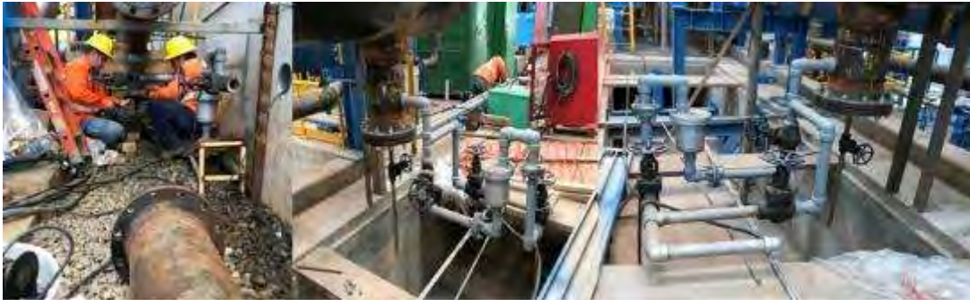
Figura 137. Instalación de tuberías de sistema de vapor principal.
