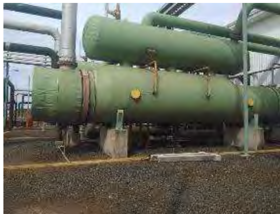
Figura 12. Recubrimientos térmicos de vaporizadores en buen estado. 24 de agosto, 2018.
