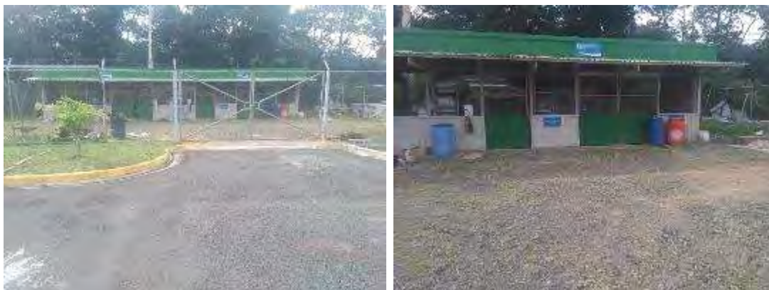
Figura 19. Centro de transferencia.
