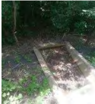
Figura 21. Sedimentador en el Proyecto Geotérmico Las Pailas Unidad II.
