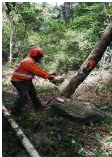
Figura 42. Corta de árboles para la construcción del Acueducto Curubandé.
