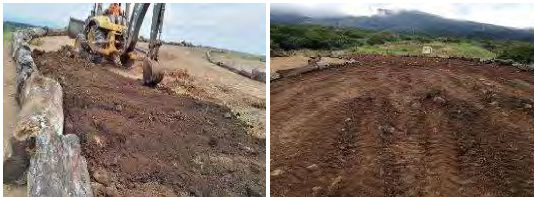
Figura 108. Colocación de tierra negra en la superficie de la Escombrera I.
