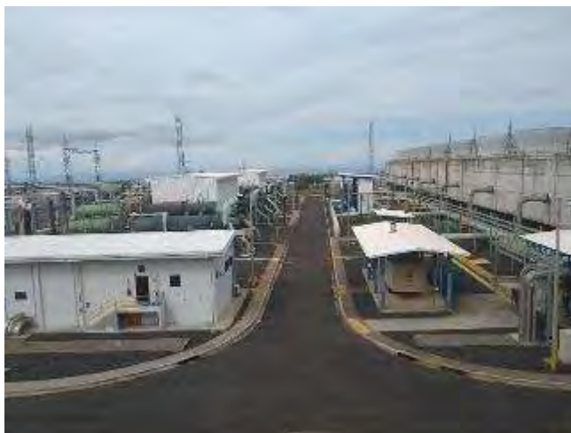
Figura 59. Vista general de la planta, en buen estado de conservación vial. Agosto, 2018.
