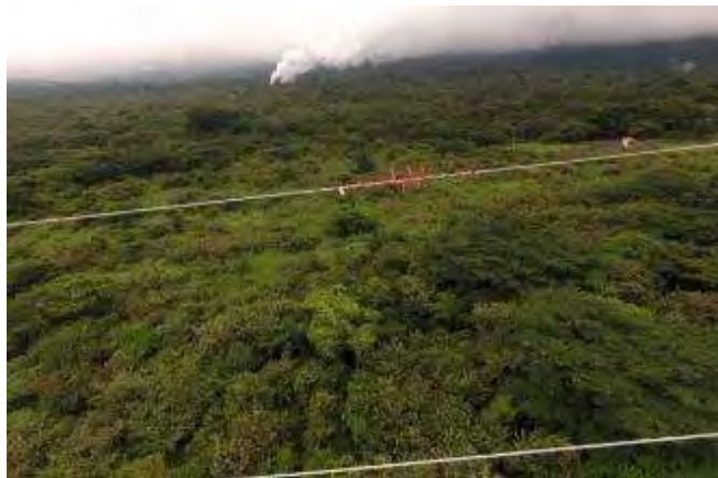
Figura 100. Dispersores para aves instalados en LT.
