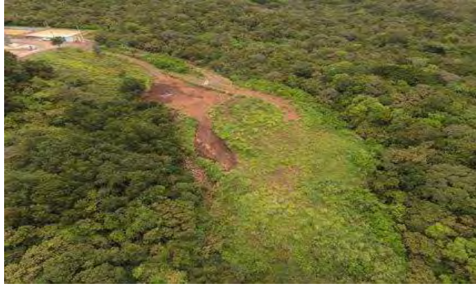
Figura 109. Estado actual de la Escombrera de la PL-13.
