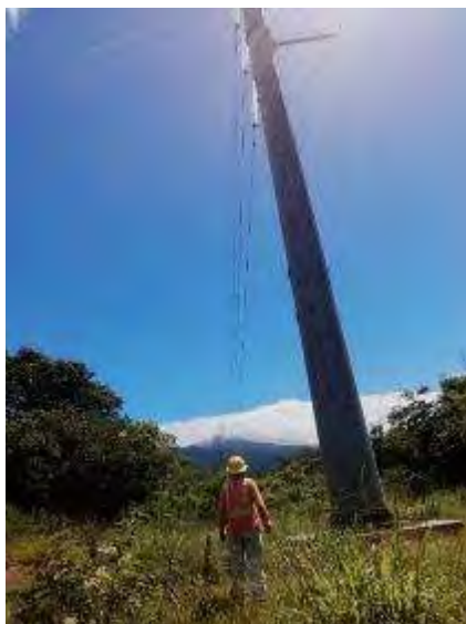
Figura 101. Recorridos en ruta de la Línea de Transmisión, agosto 2018.
