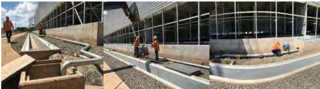
Figura 138. Instalación de tuberías de sistema de refrigeración principal.
