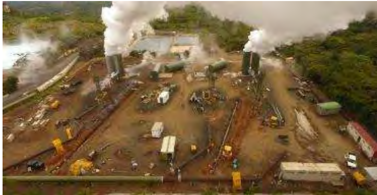
Figura 140. Avances en la Plazoleta 11.
