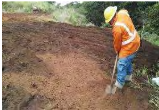
Figura 19. Aplicación de abono en la Escombrera 13.
