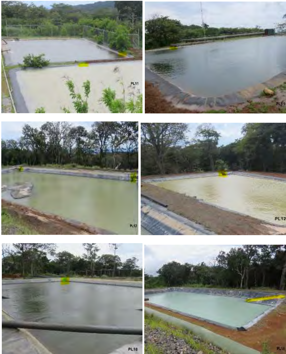
Figura 20. Dispositivos para escape de fauna en plazoletas de perforación.
