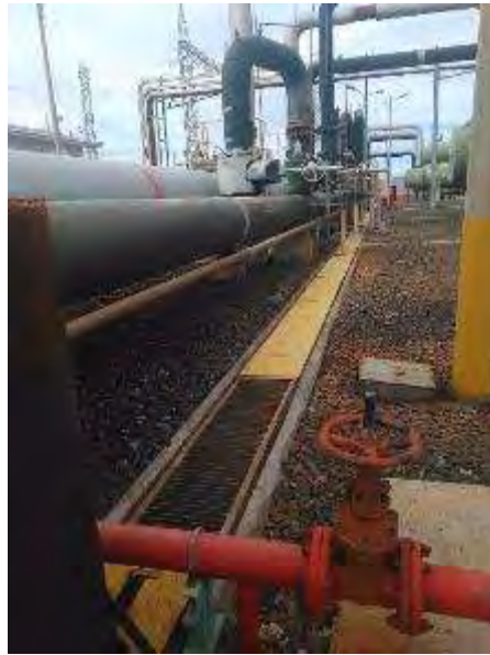
Figura 51. Vista del sistema de drenajes en buen estado y aislamientos. Setiembre 2018.
