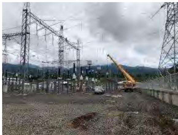
Figura 142. Avances en Subestación.
