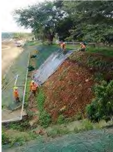
Figura 35. Plástico y geo-manto sobre los taludes de la Casa Máquinas.
