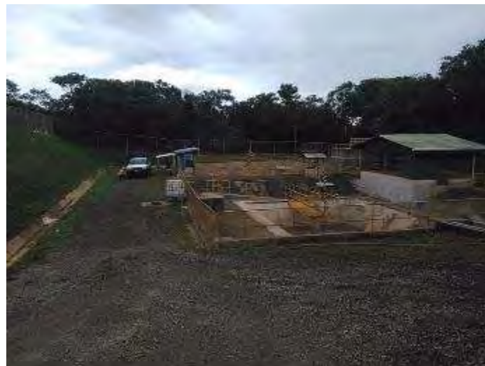
Figura 39. Vista general de planta de tratamiento. Septiembre, 2018.
