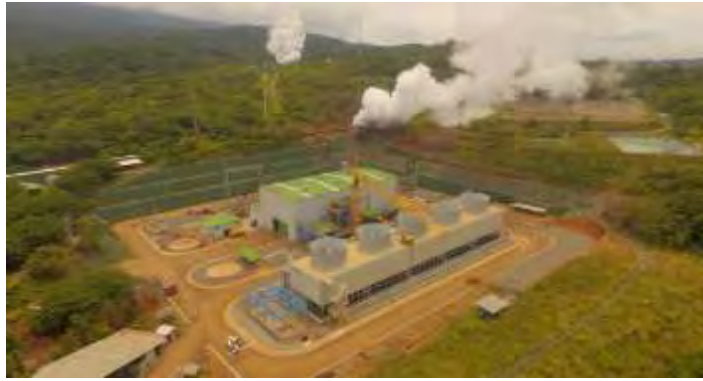
Figura 136. Avance general de Casa de Máquinas.
