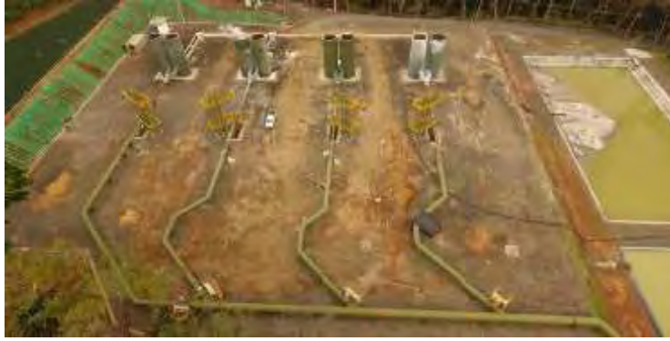
Figura 139. Avances en la Plazoleta 12.
