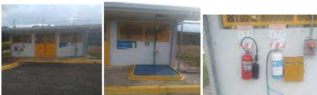
Figura 6. Bodega de químicos en buen estado. Agosto, 2018.
