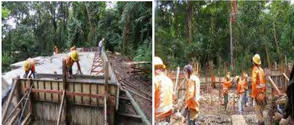
Figura 114. Trabajos toma de captación, III trimestre 2018.
