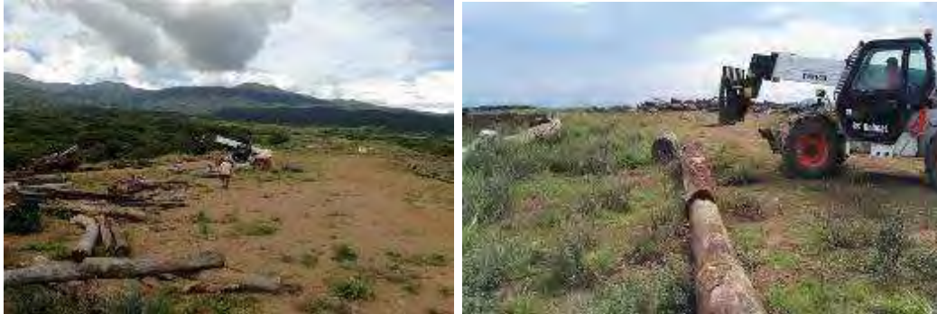
Figura 107. Colocación de troncos en la superficie de la Escombrera Pailas I.
