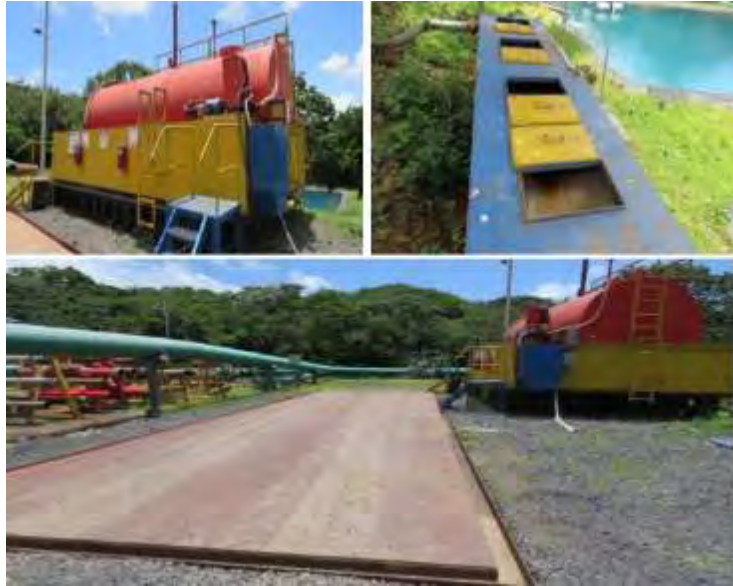
Figura 3. Uso de toallas absorbentes en trampas para aguas oleaginosas en PGP-03.
