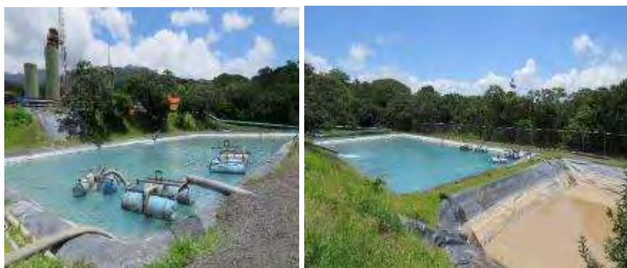
Figura 14. Lagunas almacenamiento de fluidos geotérmicos y de perforación en PLP-03.
