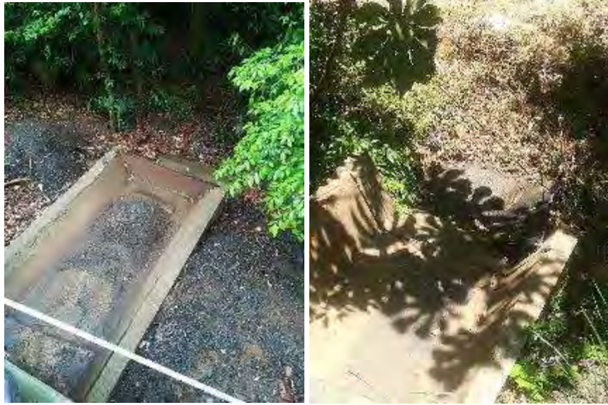
Figura 54. Inspección de sedimentadores en julio y agosto 2018.
