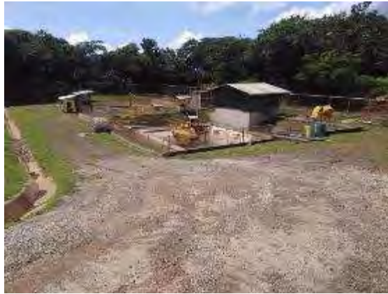
Figura 28. Vista general de la planta, está en buen estado. Se espera modernizar pronto. Septiembre 2018.
