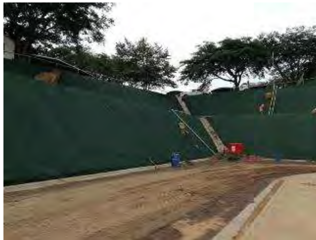
Figura 36. Colocación de geo-manto en los taludes de la Casa Máquinas.
