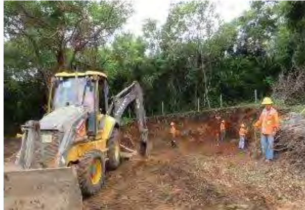
Figura 115. Trabajos tanque almacenamiento Curubandé, III trimestre 2018.
