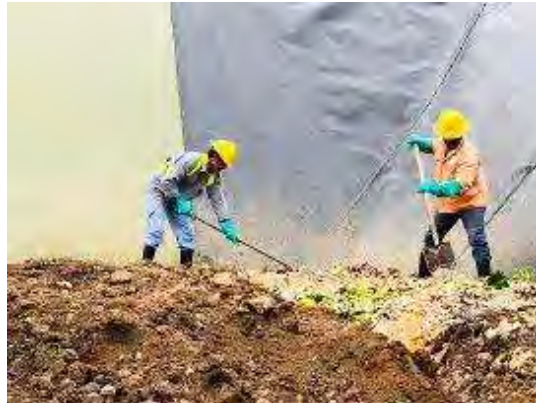
Figura 97. Vertido de residuos orgánicos en Relleno Sanitario del PG Las Pailas.
